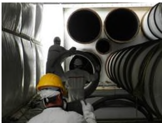
Figura 2-23 – Smantellamento delle condotte di ventilazione poste sopra al corridoio di passaggio che unisce l'Edificio BLD1 con l'Edificio BLD2
