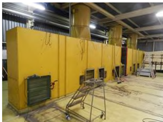
Figura 2-25 – Smantellamento filtrazione nel locale A221 dell'Edificio BLD2
