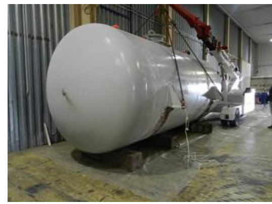
Figura 2-30 – Rimozione del serbatoio SR6 e posizionamento nel locale B106
