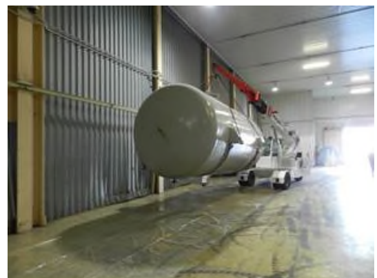
Figura 2-30 – Rimozione del serbatoio SR6 e posizionamento nel locale B106
