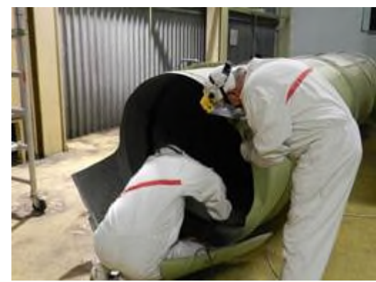
Figura 2-24 – Smantellamento tubazioni nel locale A221 dell'Edificio BLD2
