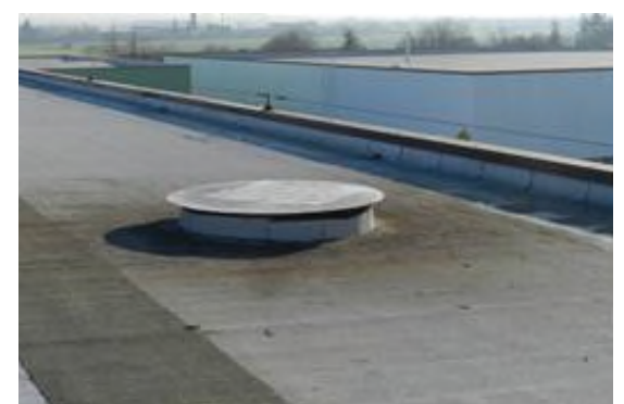
Figura 2-28 – Smantellamento camini esterni (V2, V3, V4 e V678) Edificio BLD2
