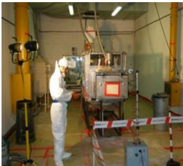
Smantellamento scatola a guanti per il recupero dell'uranio dai filtri (loCALE A220 del BLD2)
