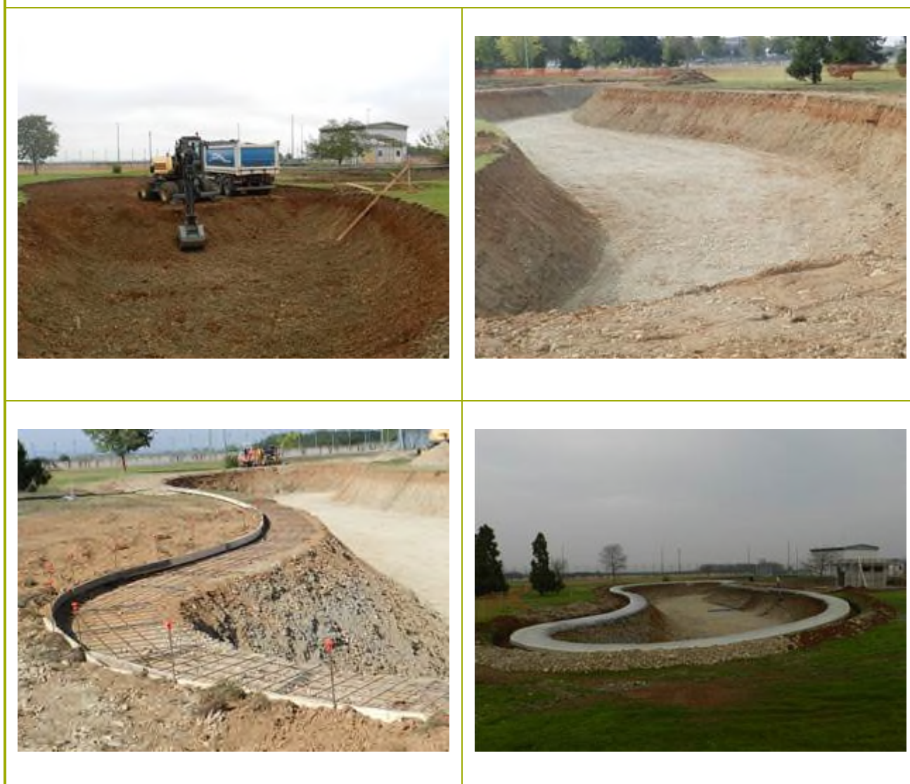
Figura 2-51 – Attività di realizzazione del bacino idrico
