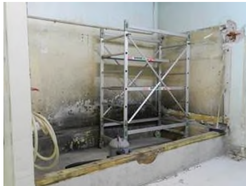
Figura 2-39 – Smantellamento della vasca di decontaminazione
