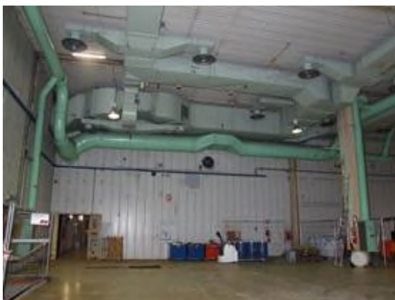
Figura 2-15 – Smantellamento impianto di espulsione nell'area A110 (filtri e tubazioni gialle)
