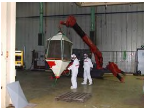
Figura 2-16 – Smontaggio filtri elettrostatici nell'area A124
