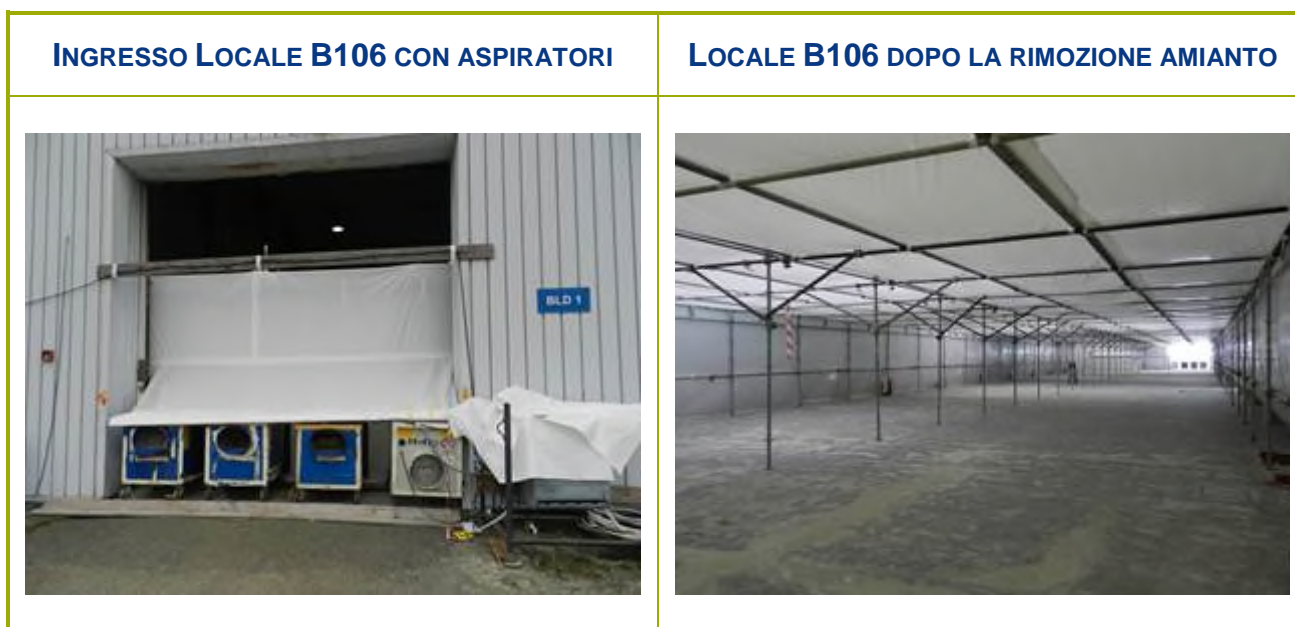
Figura 2-43 – Attività di rimozione amianto dalla pavimentazione del locale B106
