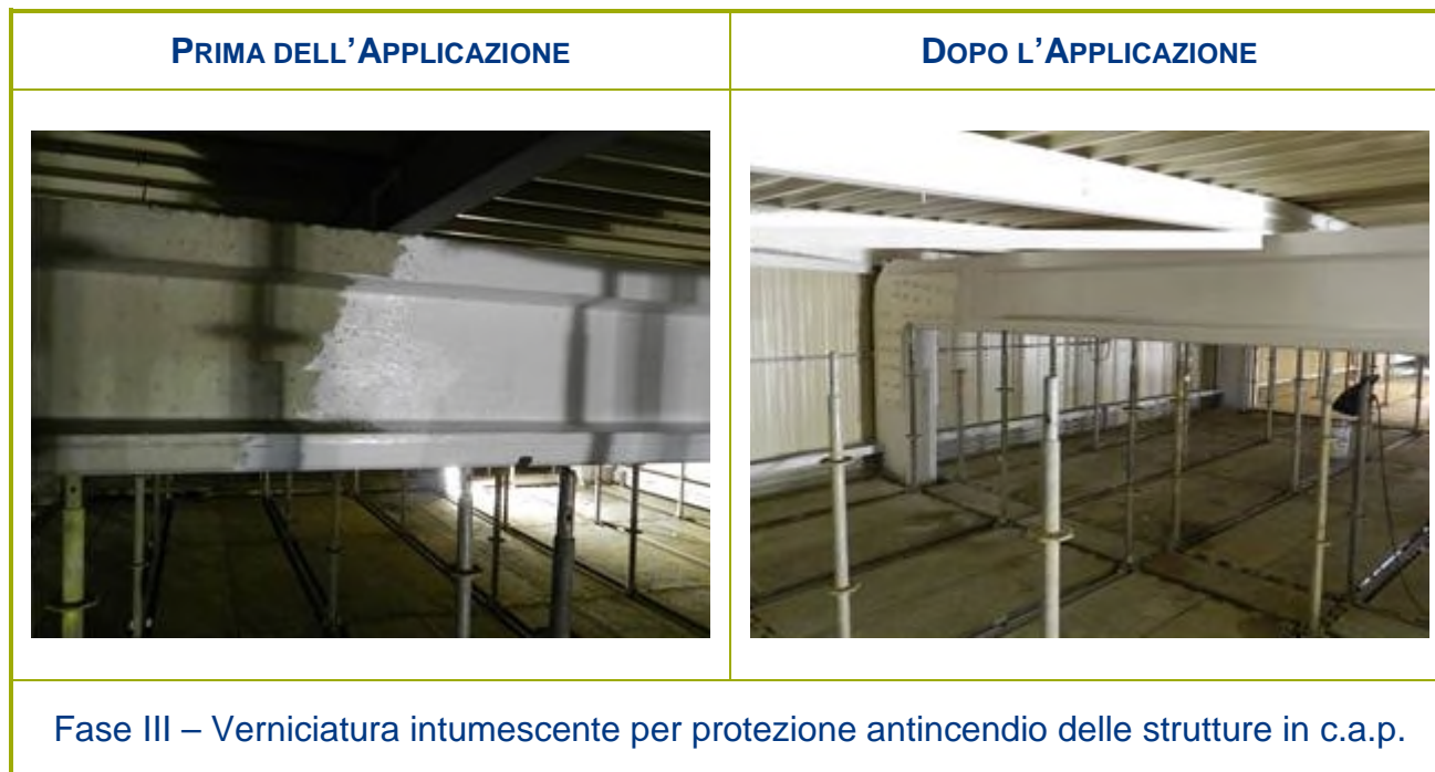
Figura 2-34 – Immagini attività di adeguamento dell'Edificio BLD11 (prima e dopo)
