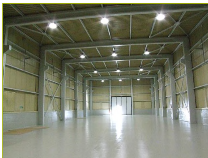
Figura 2-35 – Edificio BLD11 al termine delle attività di adeguamento
