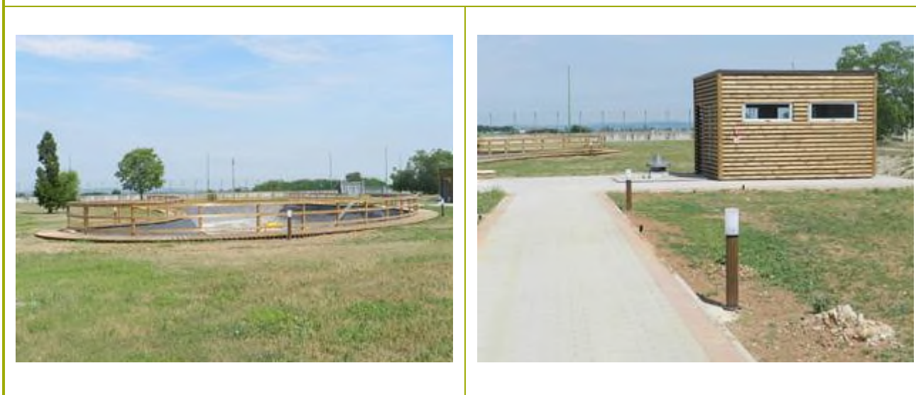
Figura 2-45 – Stato finale delle opere di realizzazione del bacino idrico e sistema di pressurizzazione
