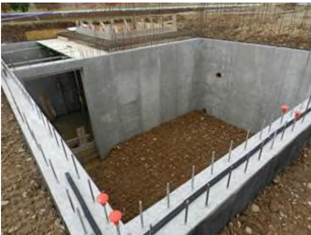
Figura 2-44 – Attività di realizzazione dell'edificio per il posizionamento del sistema di pressurizzazione
