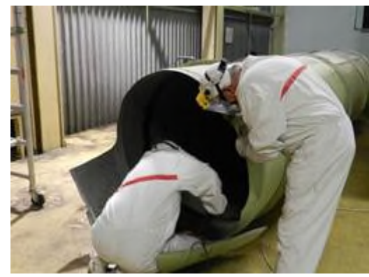
Figura 2-24 – Smantellamento tubazioni nel locale A221 dell'Edificio BLD2
