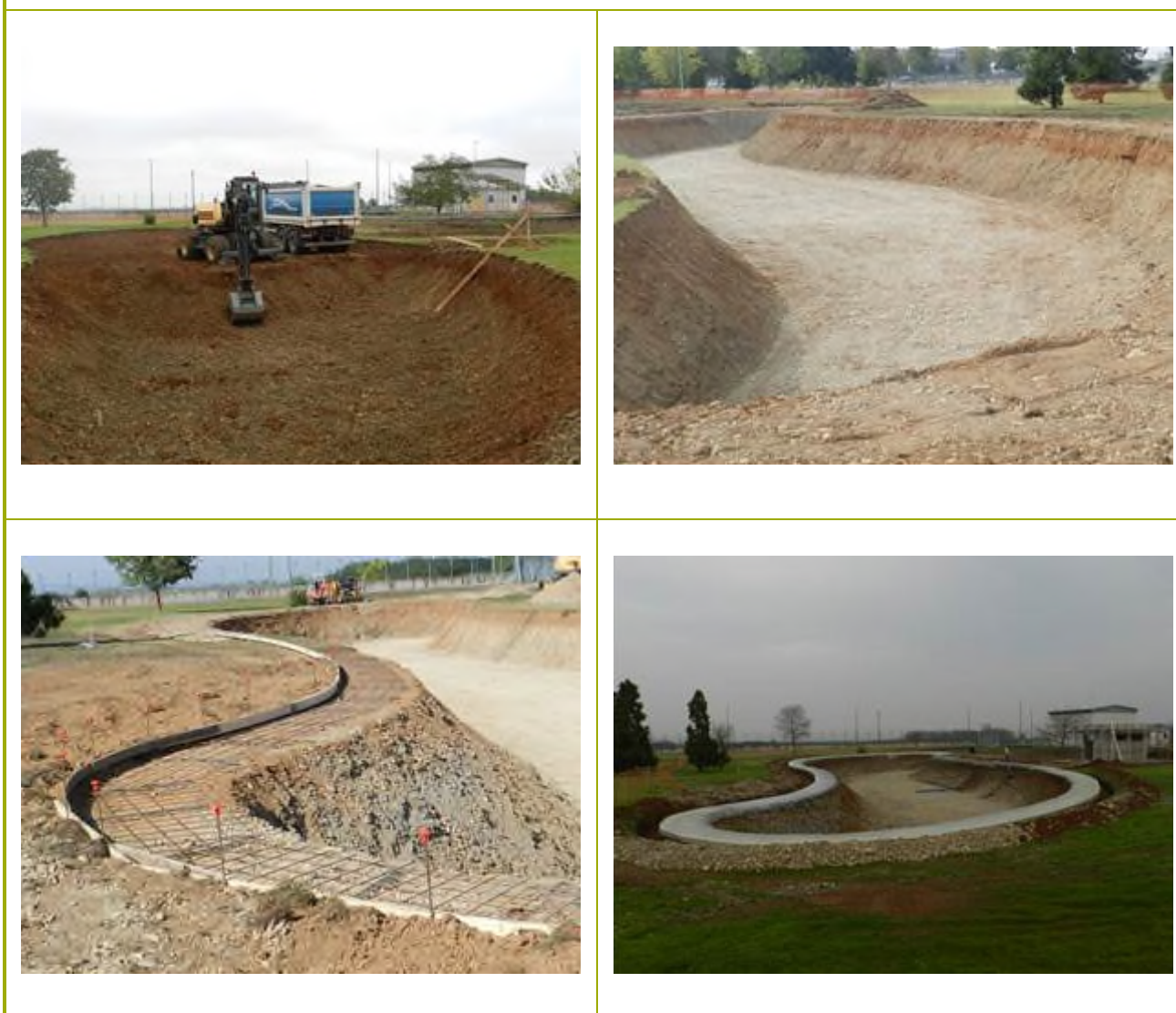
Figura 2-43 – Attività di realizzazione del bacino idrico
