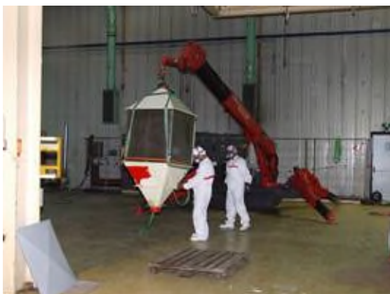
Figura 2-16 – Smontaggio filtri elettrostatici nell'area A124
