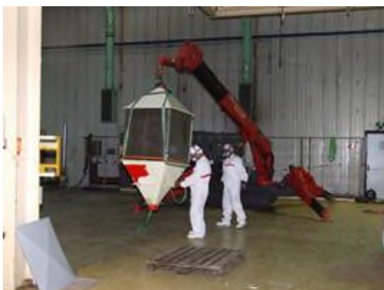
Figura 2-16 – Smontaggio filtri elettrostatici nell'area A124
