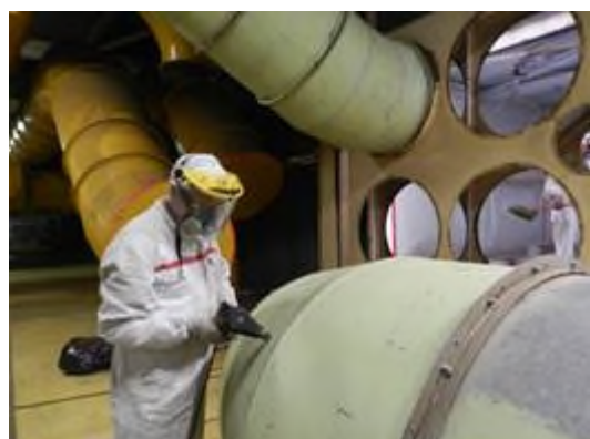
Figura 2-24 – Smantellamento tubazioni nel locale A221 dell'Edificio BLD2
