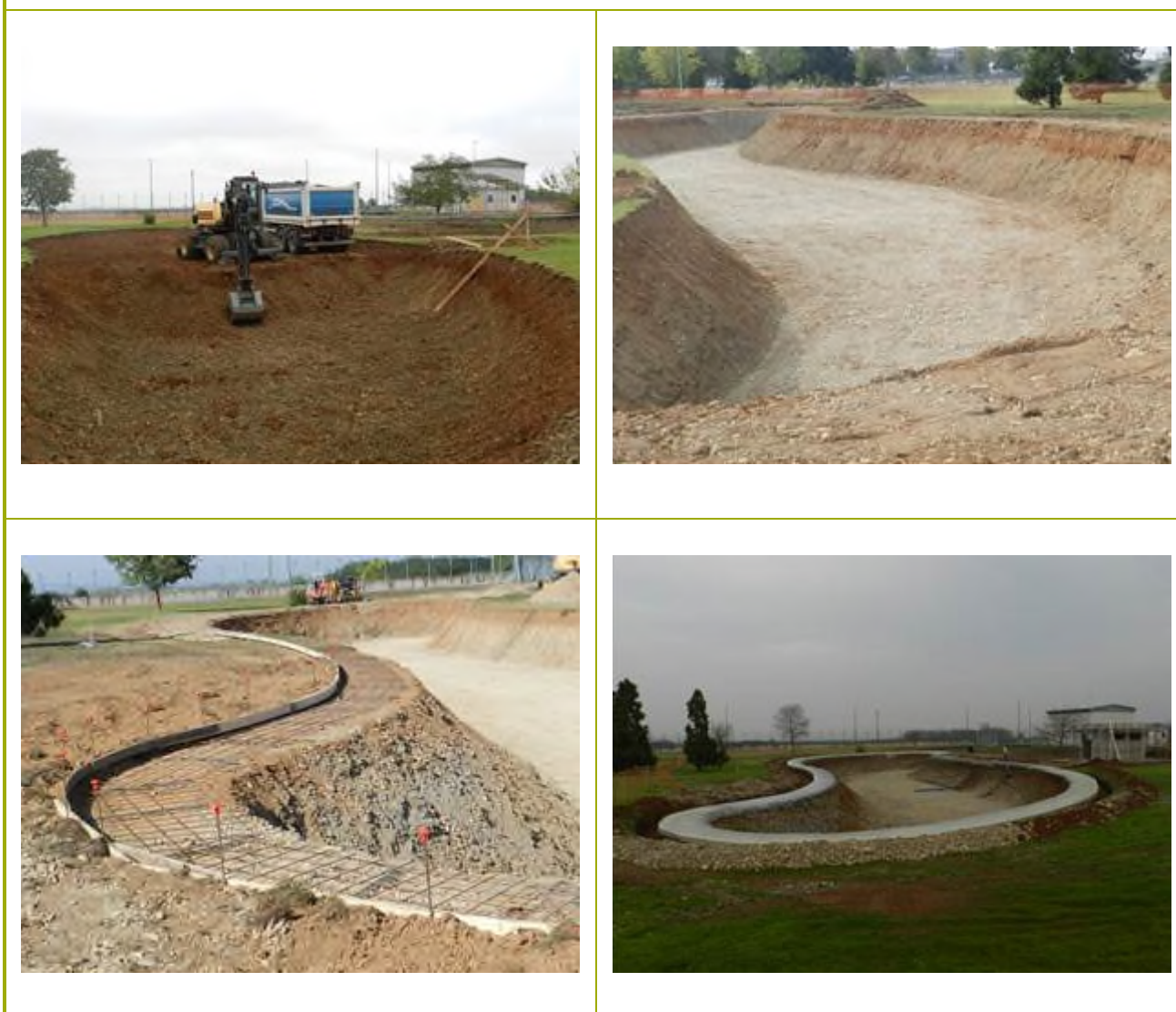
Figura 2-43 – Attività di realizzazione del bacino idrico
