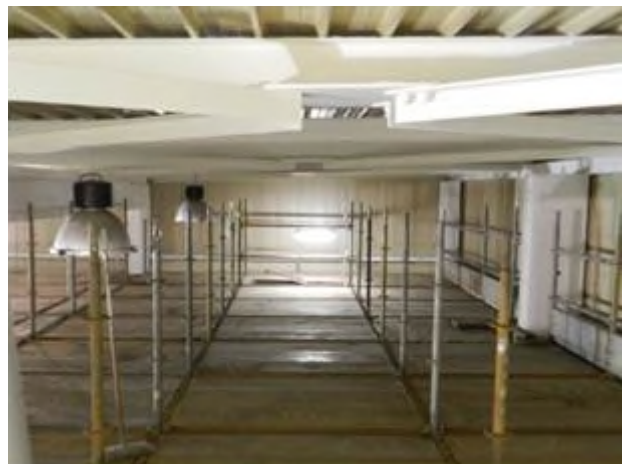
Fase III – Verniciatura intumescente per protezione antincendio delle traviature
