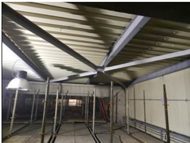
Fase III – Verniciatura intumescente per protezione antincendio delle traviature
