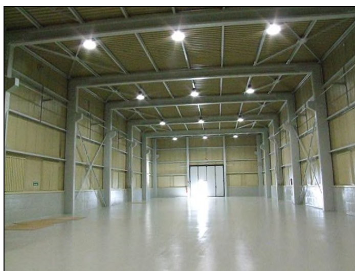
Figura 2-35 – Edificio BLD11 al termine delle attività di adeguamento
