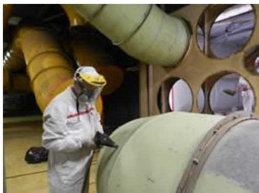
Figura 2-23 – Smantellamento tubazioni nel locale A221 dell'Edificio BLD2
