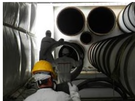
Figura 2-22 – Smantellamento delle condotte di ventilazione poste sopra al corridoio di passaggio che unisce l'Edificio BLD1 con l'Edificio BLD2
