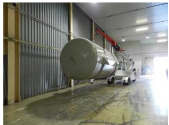
Figura 2-29 – Rimozione del serbatoio SR6 e posizionamento nel locale B106
