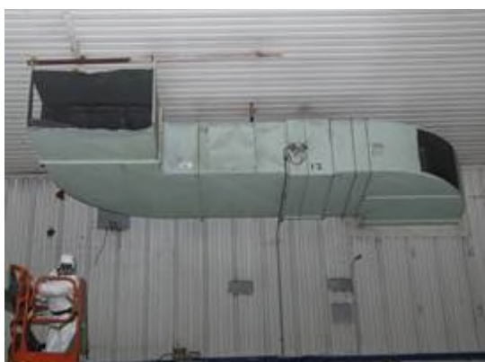
Figura 2-20 – Smantellamento impianto di ventilazione nelle aree A102, A103, A104, A105 e A107
