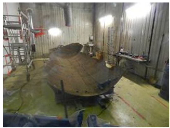
Figura 2-30 – Smantellamento del serbatoio SR6 nella capannina di taglio (A102)
