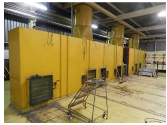
Figura 2-24 – Smantellamento filtrazione nel locale A221 dell'Edificio BLD2
