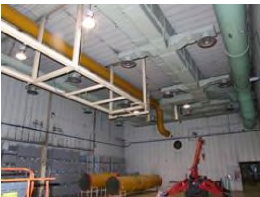
Figura 2-16 – Smantellamento impianto di espulsione nel locale A109 (tubazioni gialle)
