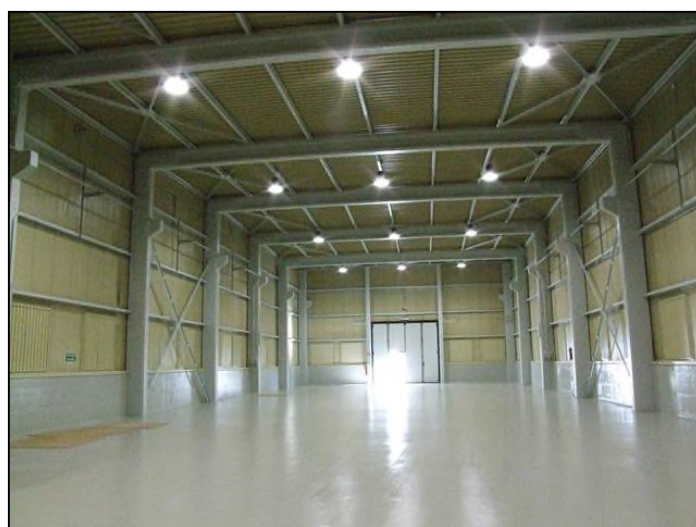
Figura 2-34 – Edificio BLD11 al termine delle attività di adeguamento
