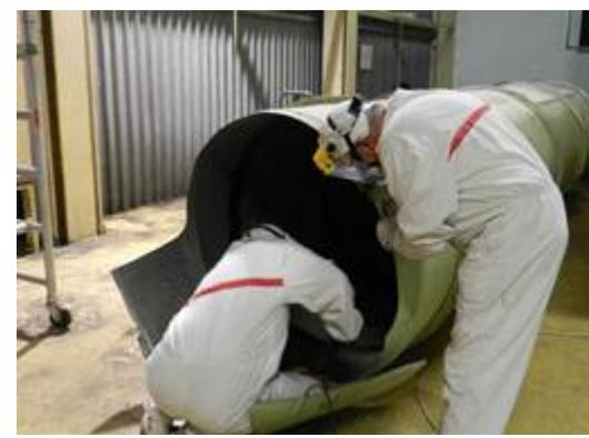
**Figura 2-21 – Smantellamento tubazioni nel locale A221 dell'Edificio BLD2**
