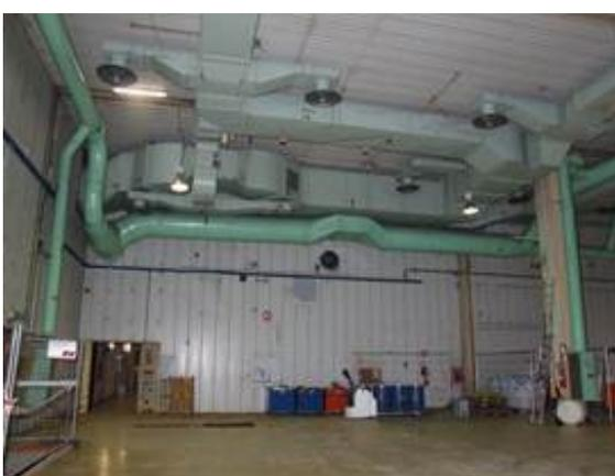
Figura 2-12 – Smantellamento impianto di espulsione nell'area A110 (filtri e tubazioni gialle)
