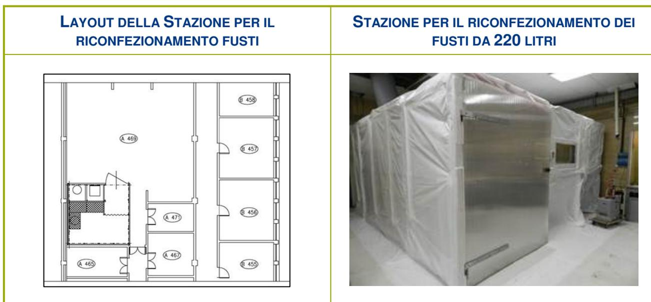
**Figura 2-9 – Stazione per il riconfezionamento dei fusti di rifiuti con U-235 > 10 g**
