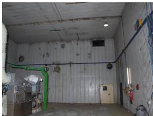
**Figura 2-18 – Smantellamento impianto di ventilazione nelle aree A102, A103, A104, A105 e A107**
