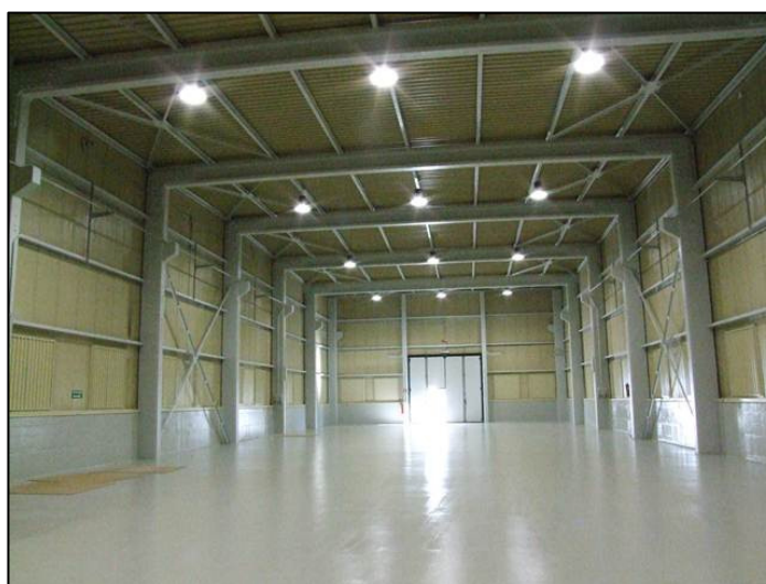
Figura 2-19 – Edificio BLD11 al termine delle attività di adeguamento
