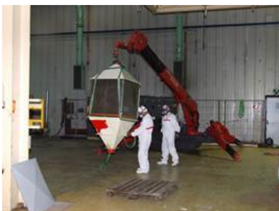
Figura 2-11 – Smontaggio filtri elettrostatici nell'area A124
