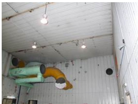
Figura 2-15 – Smantellamento impianto di ventilazione nel locale A108
