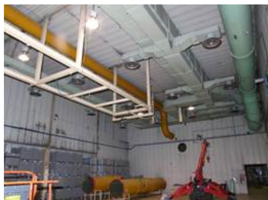
Figura 2-12 – Smantellamento impianto di espulsione nel locale A109 (tubazioni gialle)
