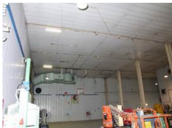
Figura 2-13 – Smantellamento mandata e ricircolo in area A110 (tubazioni verdi e grigie)
