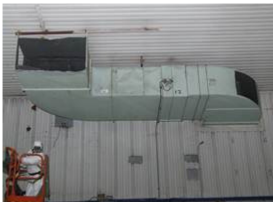
Figura 2-16 – Smantellamento impianto di ventilazione nelle aree A102, A103, A104, A105 e A107
