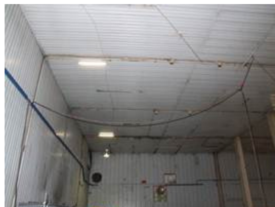
Figura 2-13 – Smantellamento mandata e ricircolo in area A110 (tubazioni verdi e grigie)
