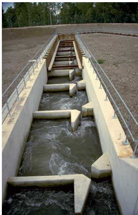
Figura A7: Passaggio a bacini successivi: tipologia vertical slot allo sbarramento di Iffezheim sul Reno (Germania) (Foto Larinier)
