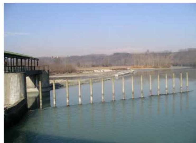
Figura 4 Vista da imbocco canale derivatore su sbarramento
