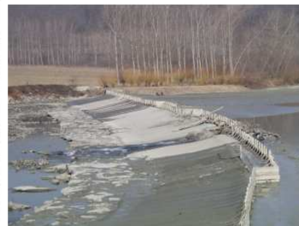
Figura 2 Dettaglio sezione rilascio su sbarramento
