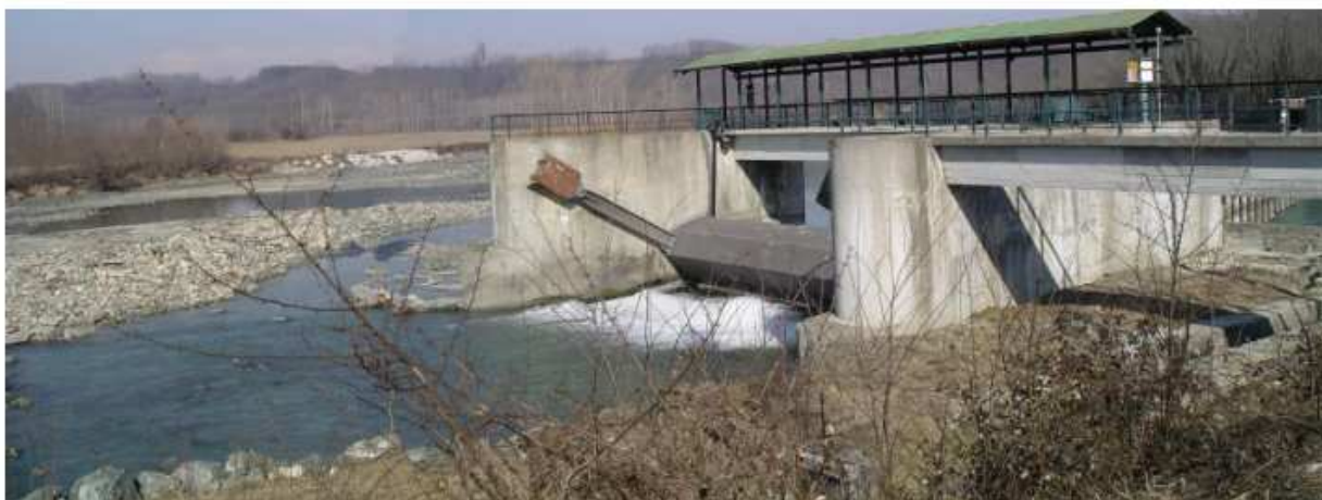
Figura 1 Vista da valle in sponda sinistra su paratoia di regolazione a settore
