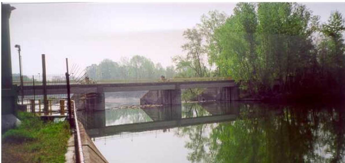
Figura 1 Vista da monte in sponda sinistra
