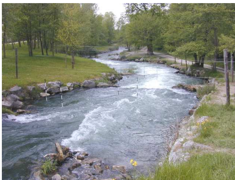
Figura A19: Passaggi semi-naturali: tipologia canale by-pass per ittiofauna e kayak Gave de Pau – Orthez. (foto Pini Prato)
