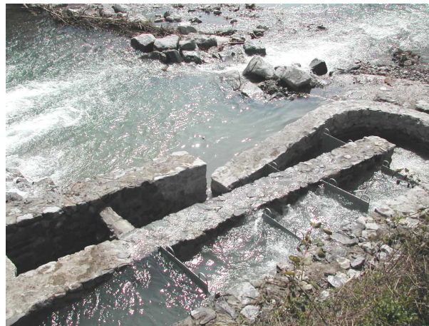
Figura A3: Passaggio a bacini successivi: tipologia deep side notch and submerged orifice realizzato con paratoie in lamiera zincata estraibili sul torrente Comano – Firenze. (Foto Pini Prato)
