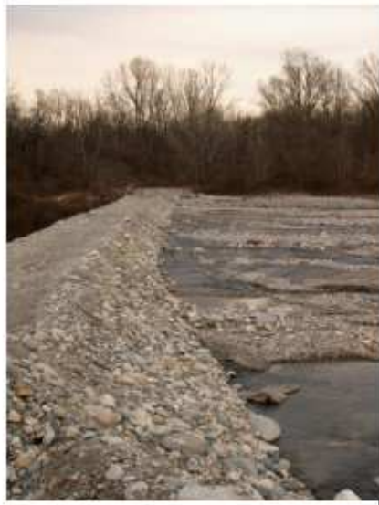
Figura 2 Vista da sponda destra su sommità sbarramento
