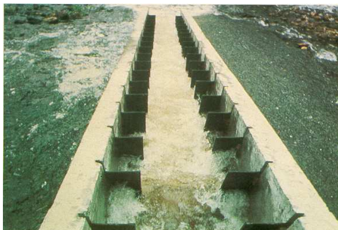
Figura A12: Passaggio a rallentatori: tipologia plain Denil sul torrente Evel in Francia (Larinier, in Progettazione di passaggi artificiali per la risalita dei pesci nei fiumi - Atti del Seminario Tecnico Regionale di Modena, 7-12-1984 )
