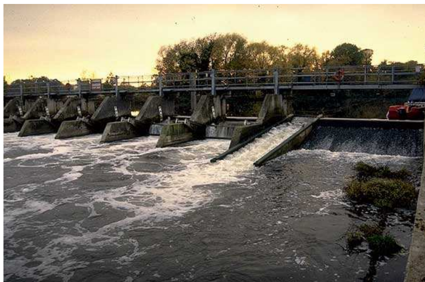
Figura A14: Passaggio a rallentatori: tipologia “a rallentatori sul fondo” sul Fiume Tamigi (UK) (Foto Larinier)
