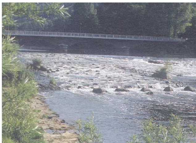
Figura A16: Passaggi semi-naturali: tipologia bottom ramp sul fiume Loisach, Bavaria (Germania) (da Fish passes design , DVWK 2002)
