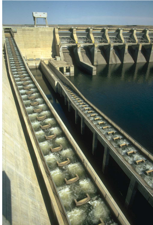
Figura A9: Passaggio per pesci modello “Ice Harbor” alla Ice Harbor Dam, Washington (U.S.A.) (Foto US Army Corps of Engineers)
