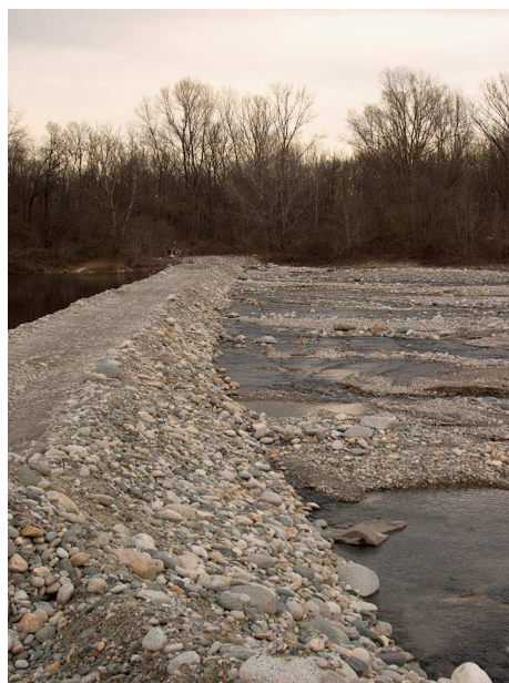
Figura 23: Sbarramento precario sul Fiume Ticino (Naviglio Langosco) – Associazione Irrigazione Est Sesia (Foto Comoglio)
