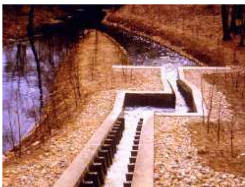
Figura A13: Passaggio a rallentatori: tipologia plain Denil con vasca di riposo (da Wasserwirtschaftsamt Bayreuth )
