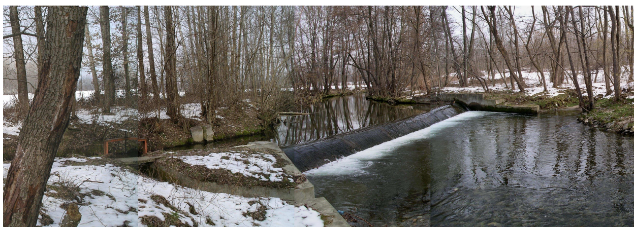
Figura 22: Traversa senza organi di regolazione sul T. Agogna (Cavo Orciolo) – Associazione Irrigazione Est Sesia (Foto Comoglio)
