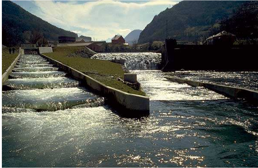
Figura A2: Passaggio a bacini successivi: tipologia triangular weir sul fiume Neste in Francia (Foto Larinier)
