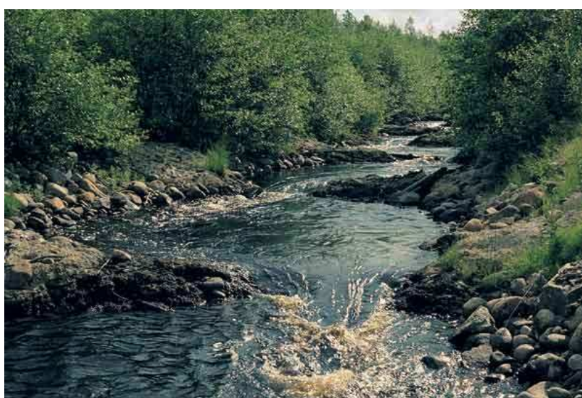
Figura A20: Passaggi semi-naturali: tipologia canale by-pass sul fiume Siikajoki (Finlandia). (foto Marmulla)
