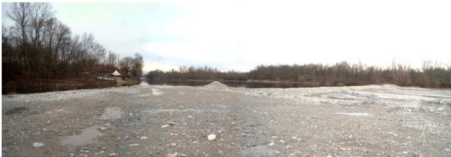
Figura 1 Vista da valle tra canale di derivazione e sbarramento precario
