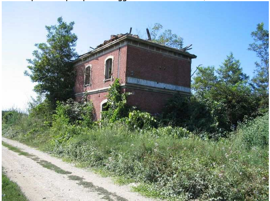
FIGURA 14 : Fabbricato Viaggiatori e W.C. al km 30+984
