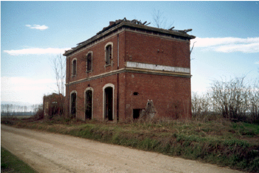
FIGURA 15 : Fabbricato Viaggiatori al km 30+984
