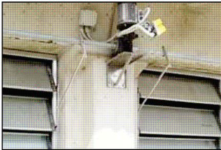
Fig. 52 - finestre con apertura comandata da centralina automatica
