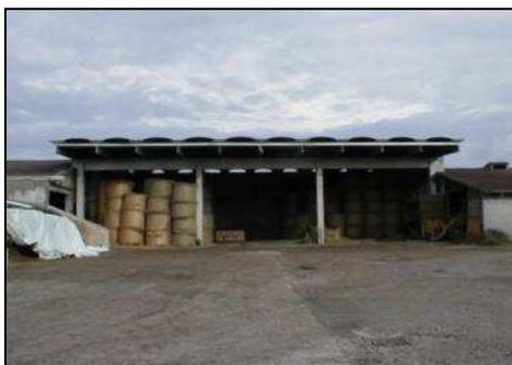
**Fig. 10 - Deposito per balle chiuso su tre lati**
