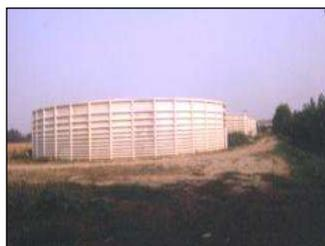
Fig. 5 - Vasca di stoccaggio realizzata con elementi prefabbricati
