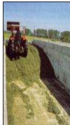
**Fig. 33 - Fase di compressione di un silo orizzontale mediante trattore con pala frontale**
