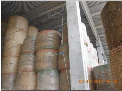
Fig. 19 Sistema di contenimento con cavi
