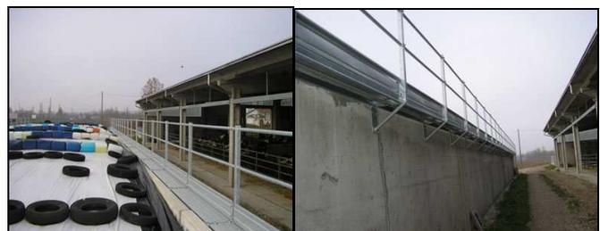
Fig. 31 - protezione anticaduta delle pareti di contenimento
