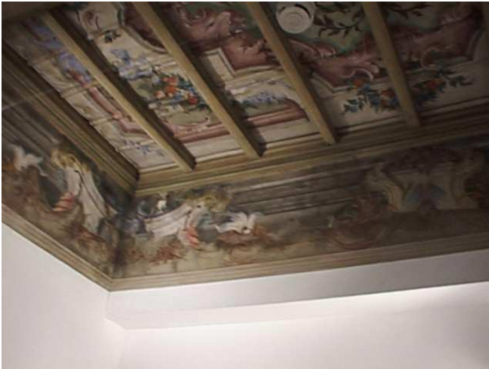
Particolare di soffitto ligneo decorato presente al primo piano
