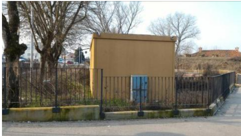
Cabina elettrica presso il parcheggio di Via Pavia
