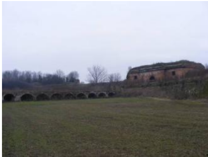
Viadotto di ingresso alla Porta del Soccorso
