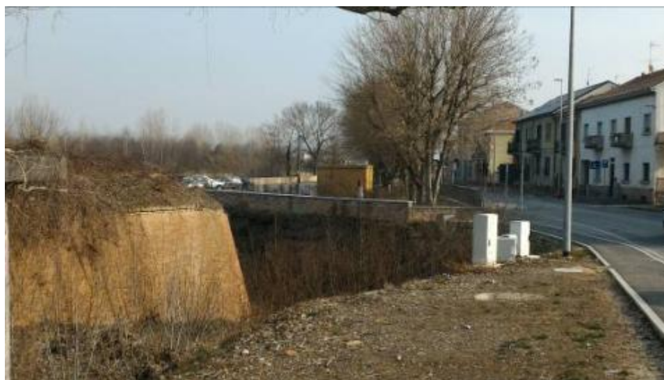
Parcheggio esistente su Via Pavia
