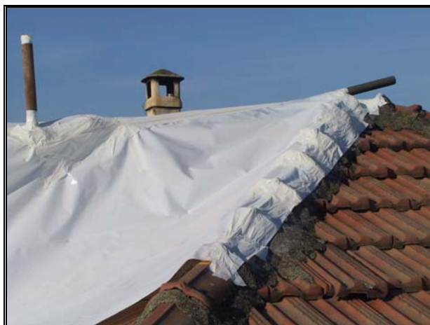
ril.fot. 18 – opera provvisoriale, coll. al tetto
