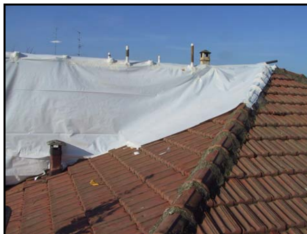
ril.fot. 19 – opera provvisoriale, coll. al tetto
