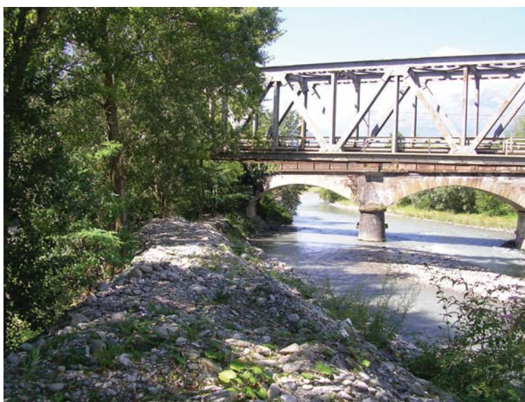
Figura 7. Sponda destra nel tratto a valle del ponte ferroviario della linea internazionale; per il saliceto è previsto il taglio di rigenerazione. A protezione della sponda è stato creato un rilevato con i sedimenti asportati in corrispondenza del ponte
