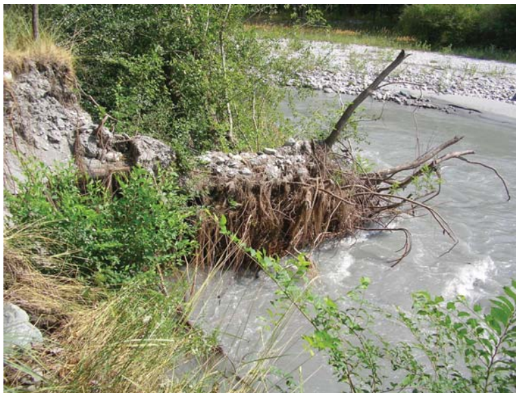
Figura 6. Tratto spondale nei pressi dell'area A soggetta ad erosione, con conseguenti crolli di alberi in alveo; occorre prelevare gli alberi schiantati e contestualmente ceduire le ceppaie radicate sul ciglio di sponda per evitare ulteriori crolli.
