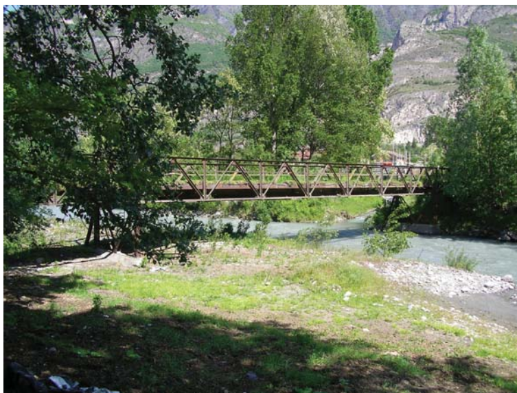
Figura 2. Il ponte di Coldimosso è un’infrastruttura pericolante per di più ritenuta interferente ed inadeguata per le piene con tempo di ritorno bicentenario, dagli studi idraulici dell’Autorità di Bacino.
