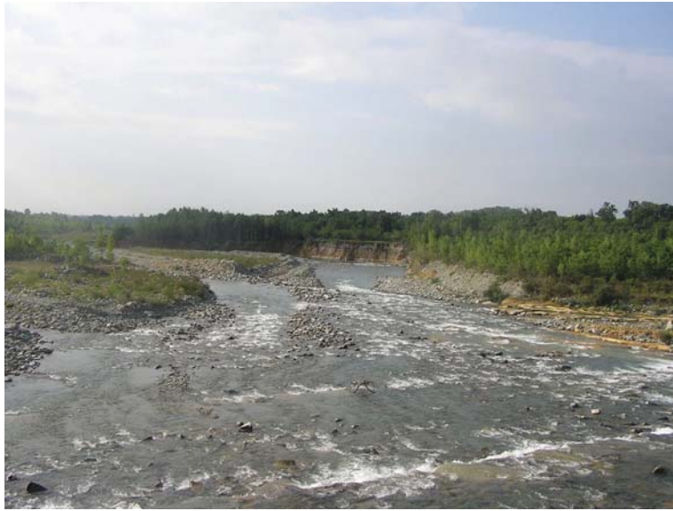
Figura 13. Porzione a valle del ponte di Villanova in cui è osservabile, al centro dell'immagine, un tratto di sponda recentemente asportato per effetto dell'erosione, con emersione del substrato sabbioso-limoso del Villafranchiano.
