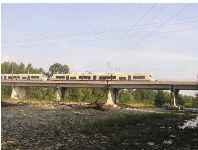
Figura 30. Ponte ferroviario nei pressi di Borgaro in cui sono presenti depositi di legno morto fluitato dalla corrente.
