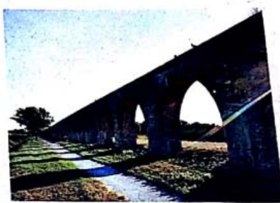
L'Acquedotto Non sarà demolito ma "smontato"
