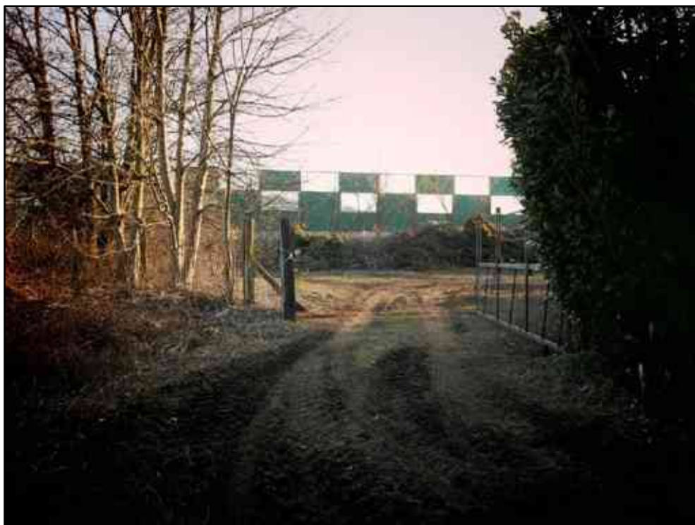
Figura 186 – Perimetrazione dell'area di compostaggio al termine di Via Asseri (Castelletto Ticino). Sullo sfondo le barriere antirumore dell'autostrada A8/A26 Diramazione Gallarate-Gattico.
