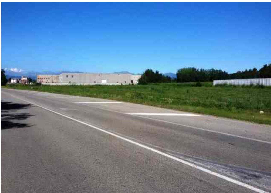
Figura 164 – Tratto della SP229 del Lago d'Orta in direzione di Suno (corsia direzione nord).
