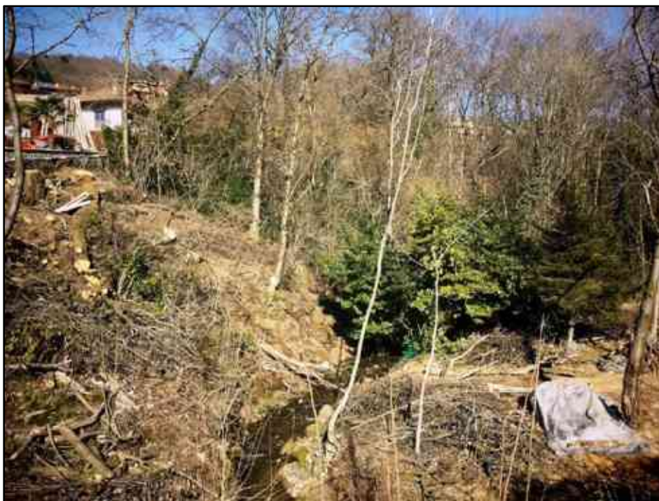
Figura 23 - Aspetto del varco V04-Pisano/Nebbiuno in corrispondenza del superamento del rio affluente sinistro del torrente Tiasca, di Via V.Emanuele al confine tra i comuni di Nebbiuno e Pisano.
