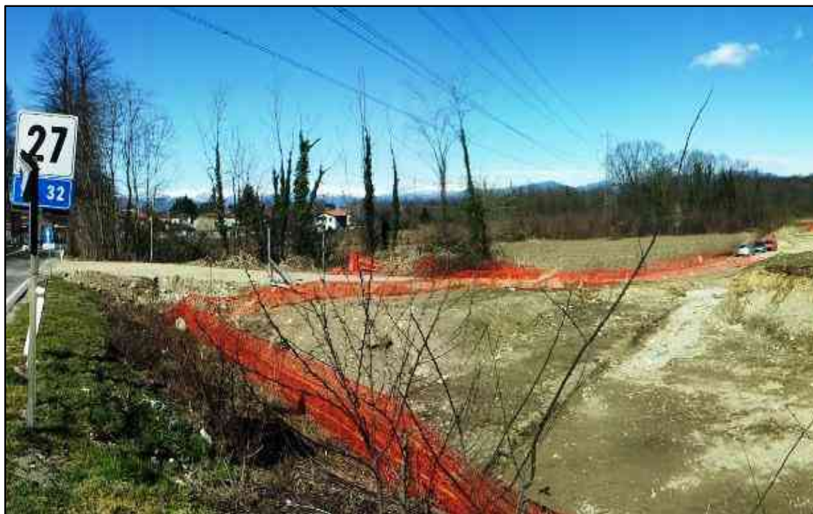
Figura 208 – Area di cantiere per la realizzazione di un nuovo raccordo stradale che si collegherà alla SS32 Ticinese con una rotatoria stradale in corrispondenza dell'intersezione con la SP166.
