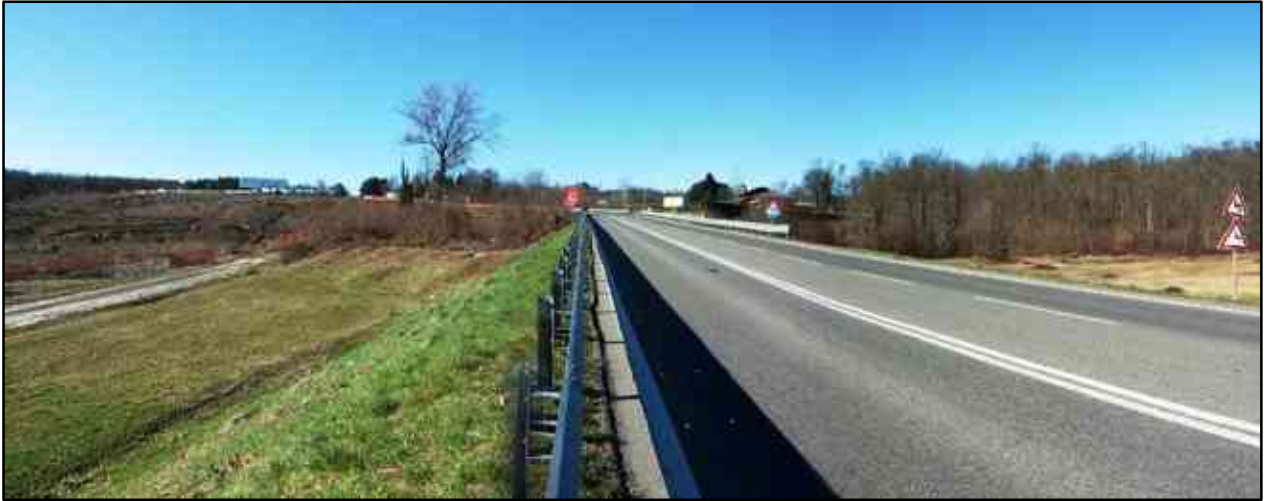
Figura 50 – Tratto della SP142 che scorre in rilevato rispetto al piano campagna in località Borgo Agnello (Posizione B in Figura 29).
