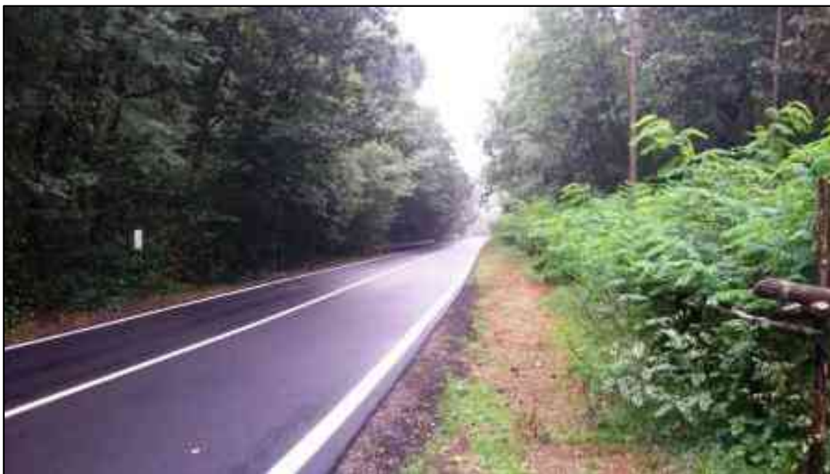
Figura 104 – Tratto meridionale della SP33/A di Briga che attraversa le formazioni boschive presenti nella porzione iniziale del Corridoio C2 (ramo C2b).
