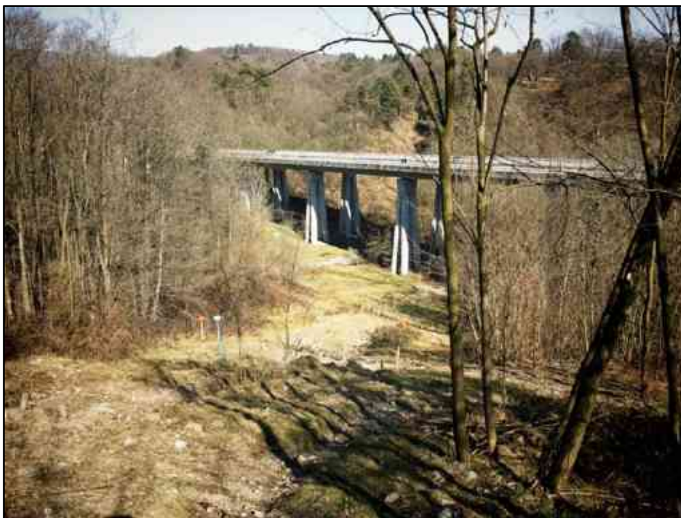
Figura 34 – Il viadotto dell'autostrada A26 che consente il superamento del torrente Vevera.
