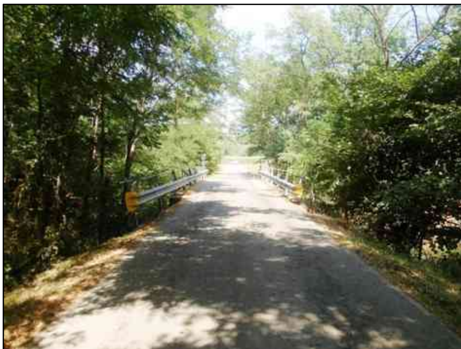
Figura 242 – Tratto della SP105 Vaprio/Mezzomerico che precede l'attraversamento del Torrente Terdoppio in comune di Vaprio d'Agogna.
