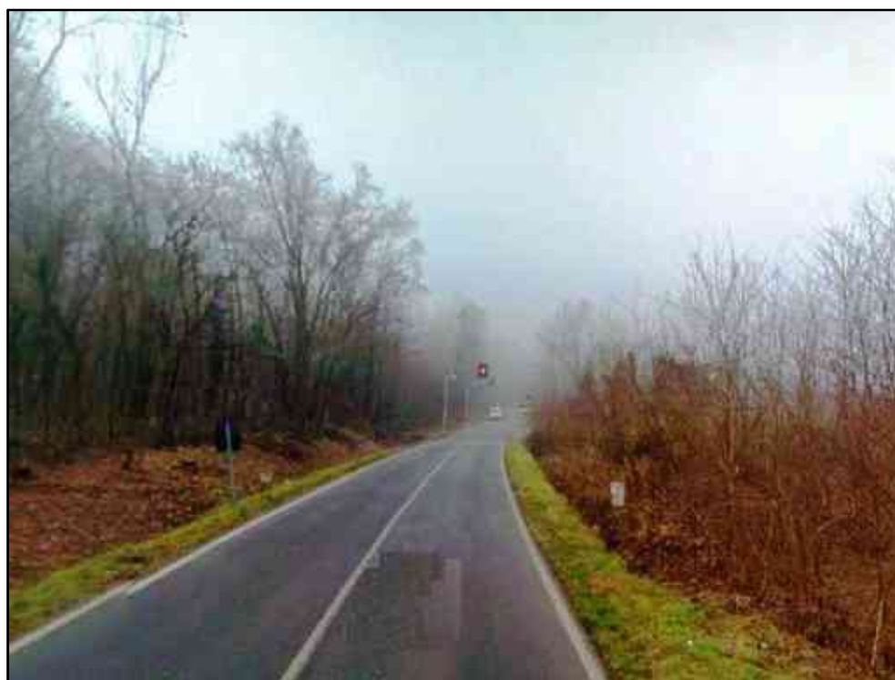
Figura 189 – Formazioni boschive nell'estrema porzione orientale del varco V11-Castelletto Ticino lungo la SP29 Pombia/Castelletto Ticino.
