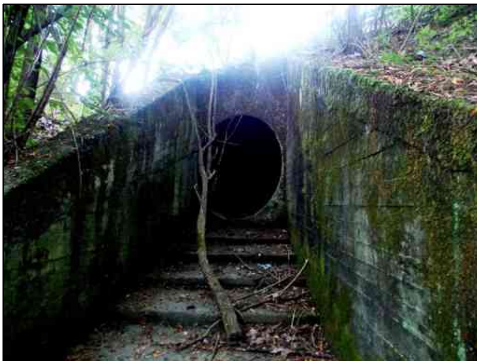
Figura 112 – Tratto finale della canalizzazione che convoglia a valle della SP142 le acque meteoriche raccolte dall'impluvio a monte.
