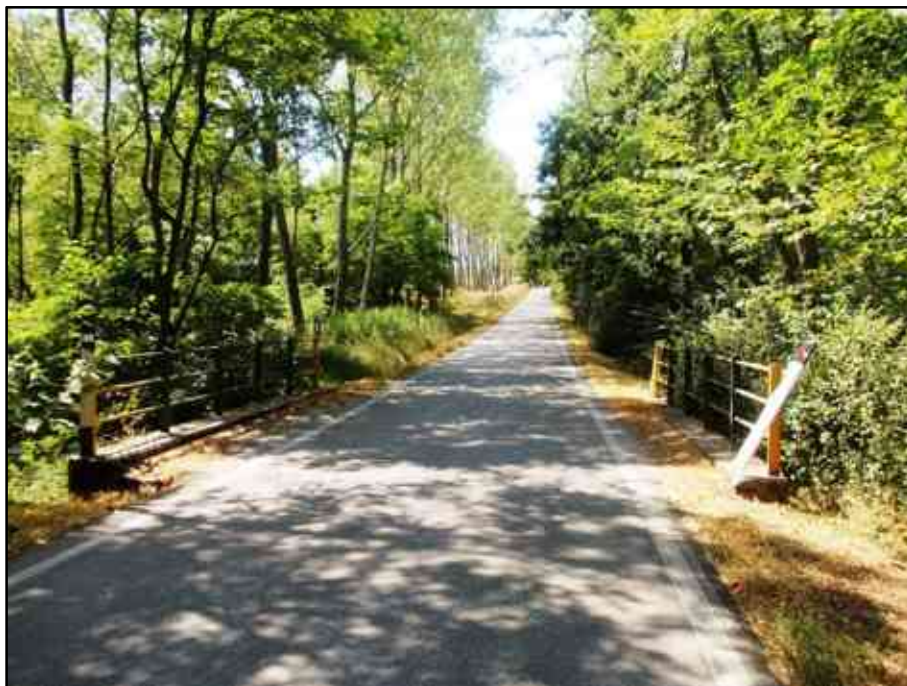
Figura 233 – Tratto della SP18 Marano/Mezzomerico/Suno/Cressa. In primo piano il ponte sul rio Zuffolone.
