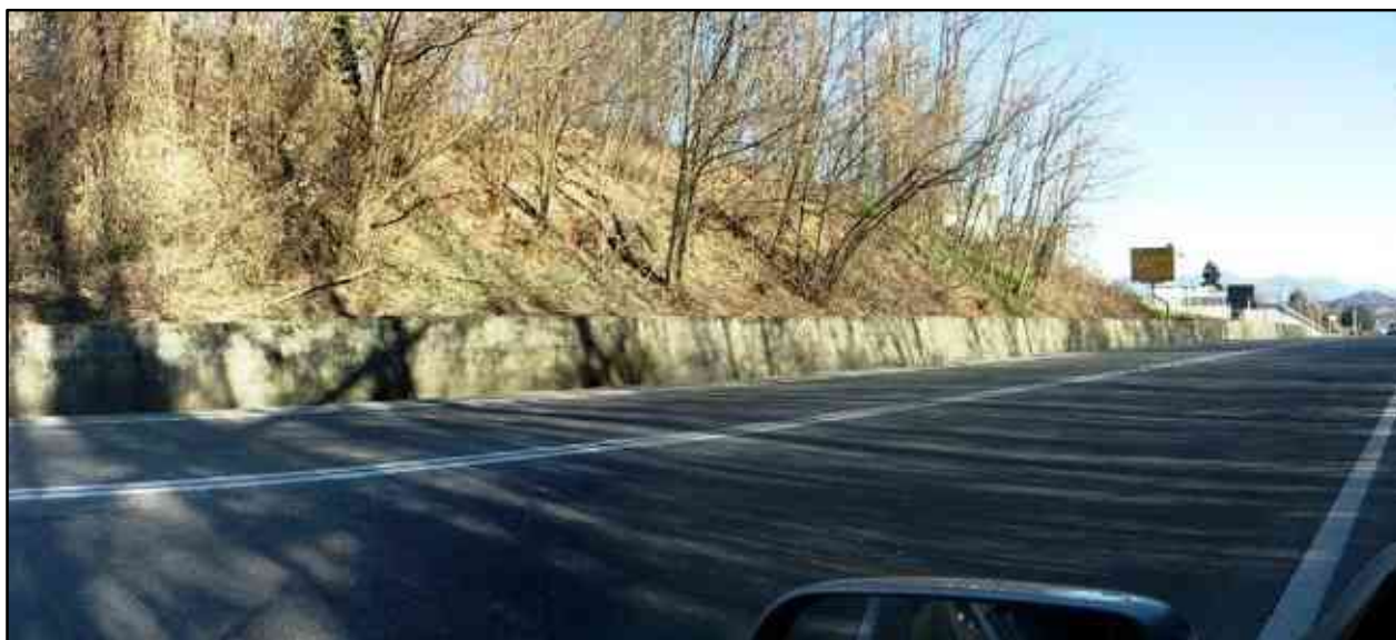
Figura 49 – Frammentazione operata dalla SP142 a carico delle formazioni boschive della porzione meridionale del varco V07-Invorio/Paruzzaro. Si notino i muri di sostegno che operano come ulteriore barriera al transito della fauna (Posizione A in Figura 29).
