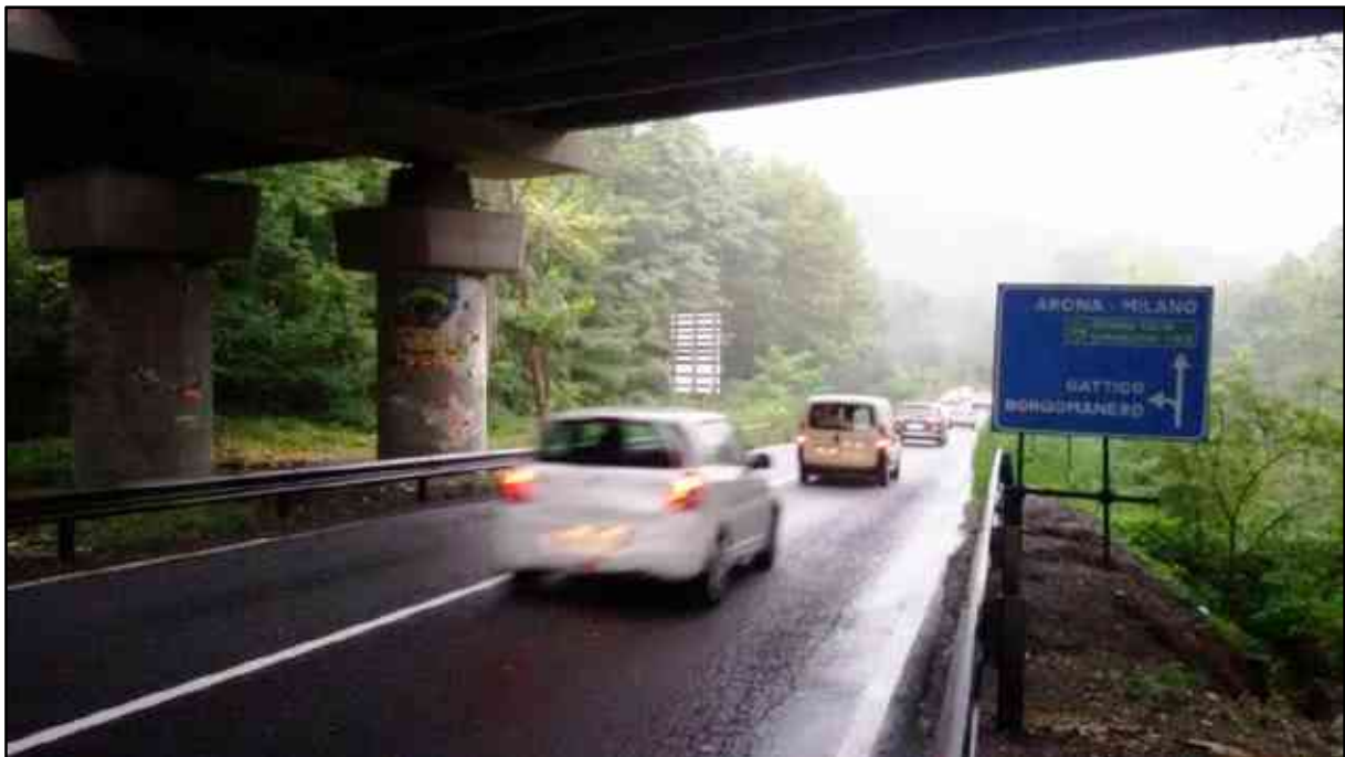
Figura 192 – Tratto della SS32 Ticinese sotto il cavalcavia Campagnola del Raccordo autostradale A8/A26.
