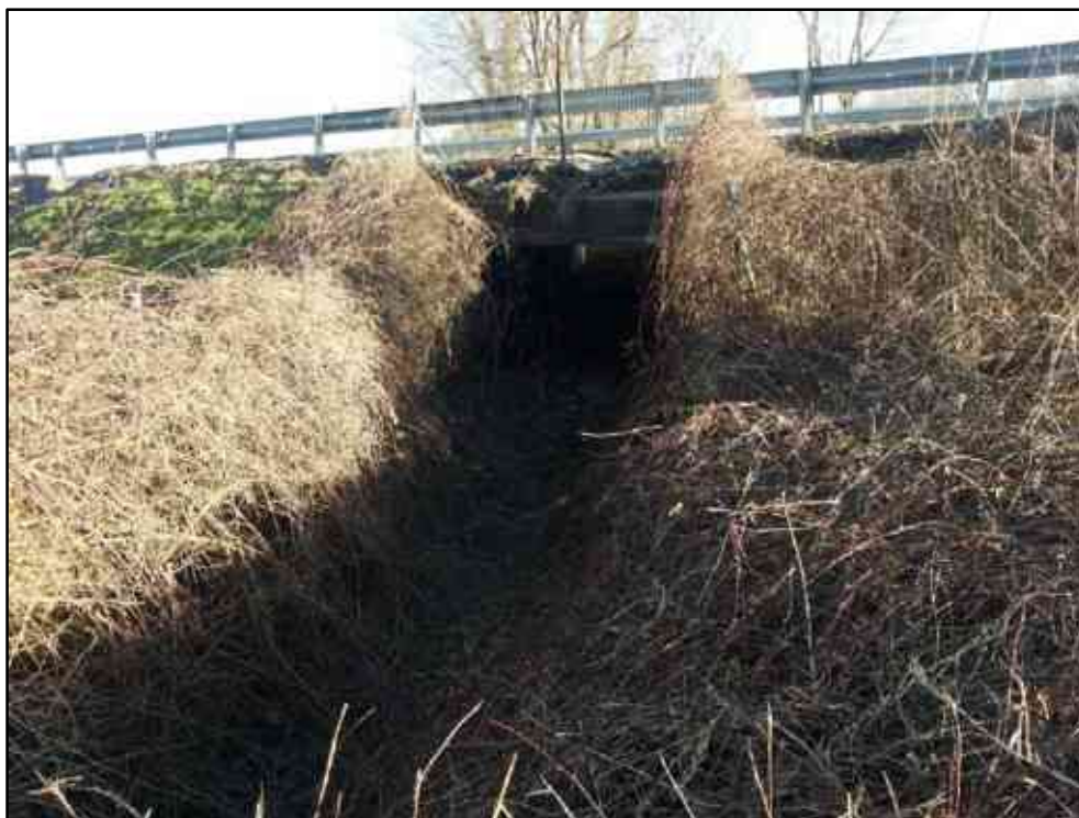
Figura 201 – Tratto canalizzato di una roggia temporanea, posta a circa 120 metri dal sottopasso precedente, abitualmente utilizzata da volpe e tasso.
