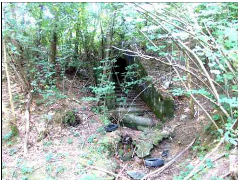
Figura 113 – Raccordo con il fondovalle della canalizzazione a valle della SP142; sono evidenti alcune locali situazioni di degrado legate all'abbandono di rifiuti.
