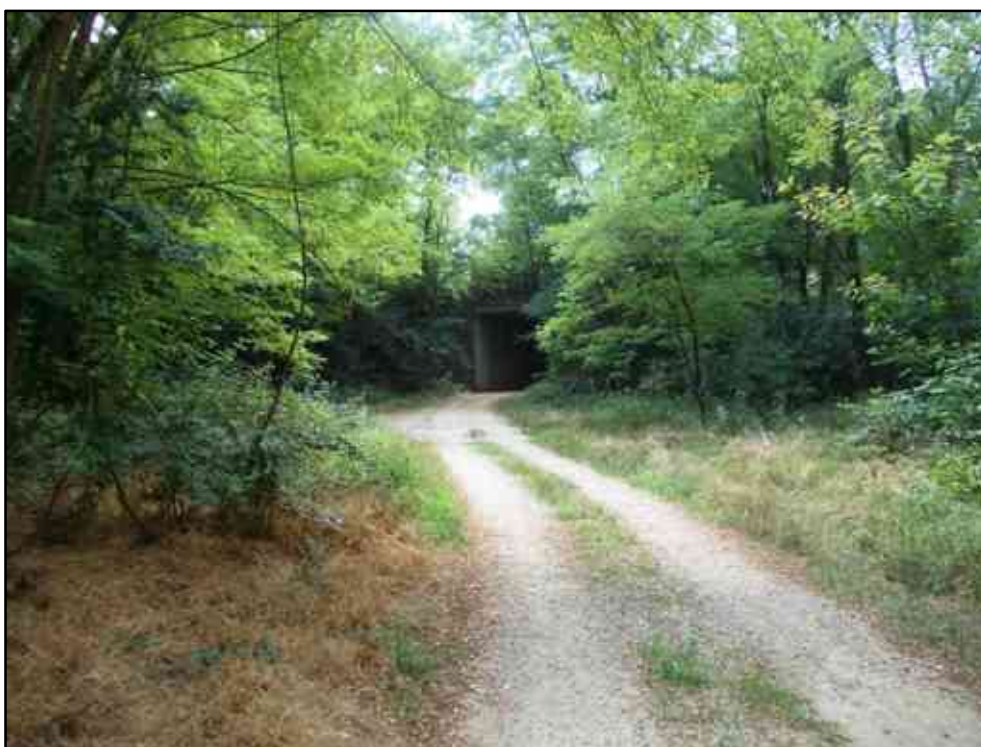
Figura 132 – Strada interpodere in comune di Gattico che attraversa le formazioni boschive; sullo sfondo il sottopasso al tracciato autostradale.
