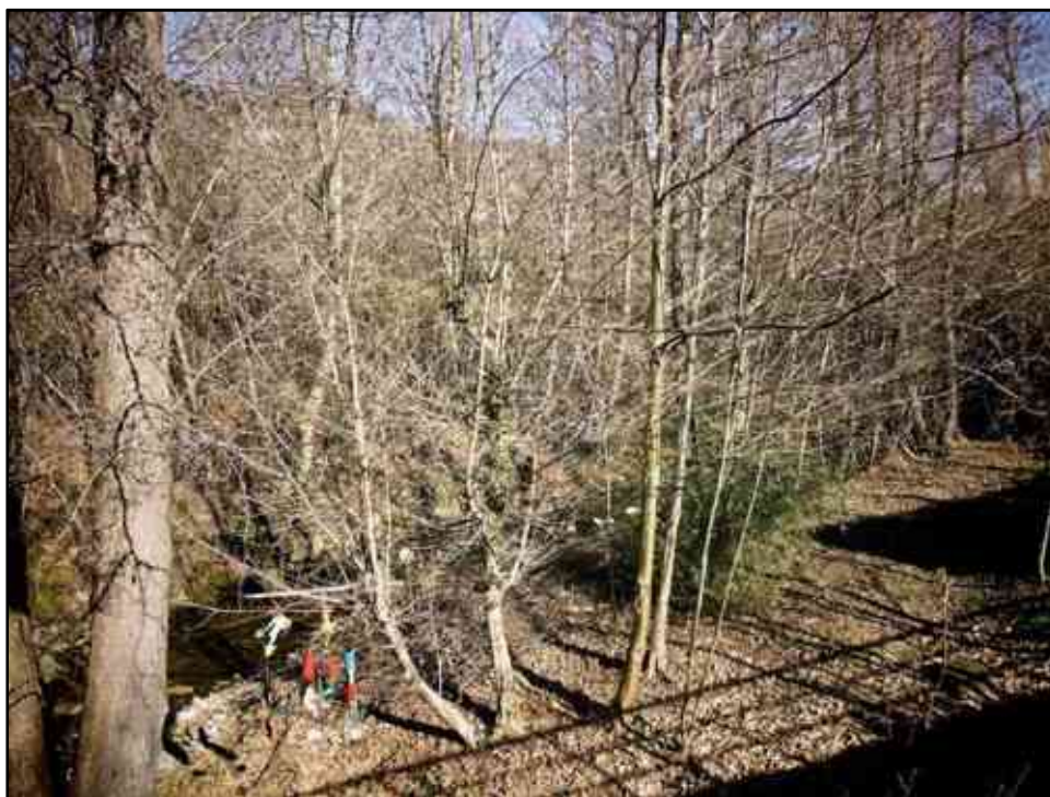
Figura 24 - Aspetto del varco V04-Pisano/Nebbiuno in corrispondenza del superamento del rio affluente sinistro del T. Tiasca, di Via per Meina al confine tra i comuni di Nebbiuno e Pisano.
