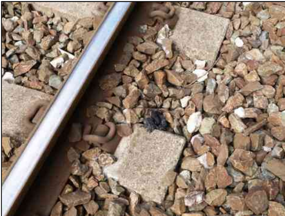
Figura 197 – Escrementi di volpe lungo la linea ferroviaria Arona/Novara nel tratto che consente il superamento del raccordo autostradale e della SP32 Dir Borgomanero.
