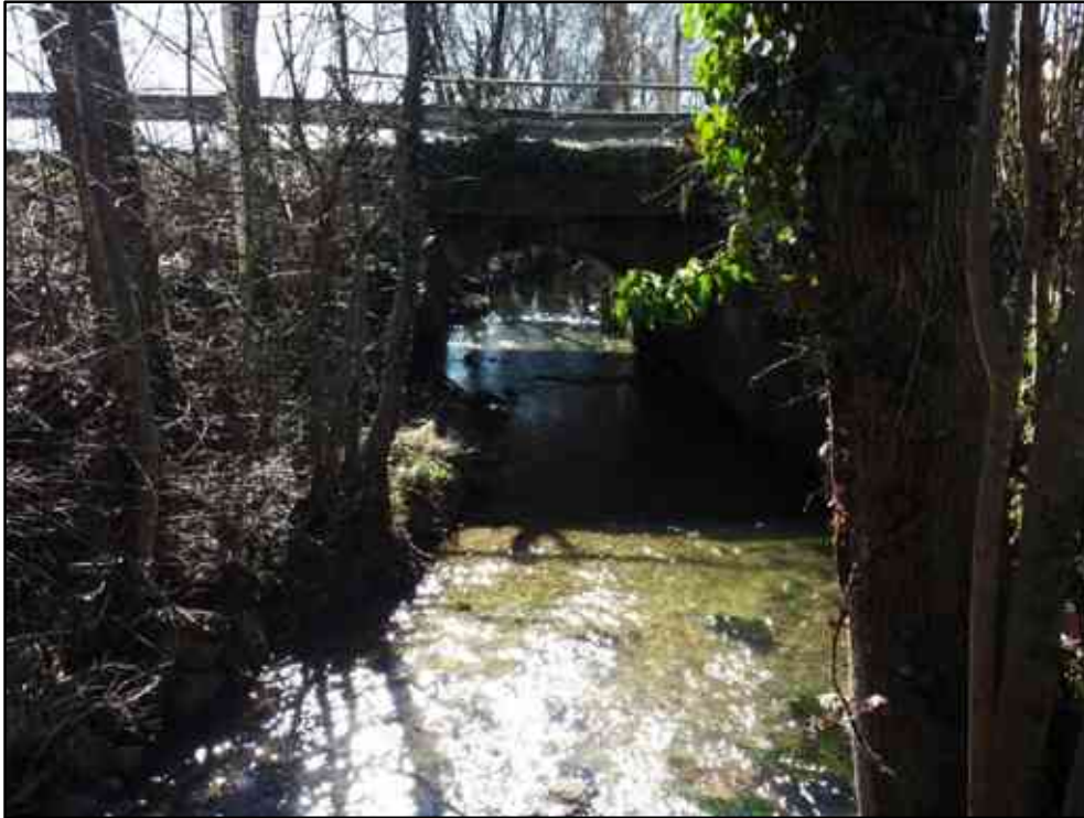
Figura 82 – Tratto a valle del fosso Geola in corrispondenza del superamento della SP32dir.
