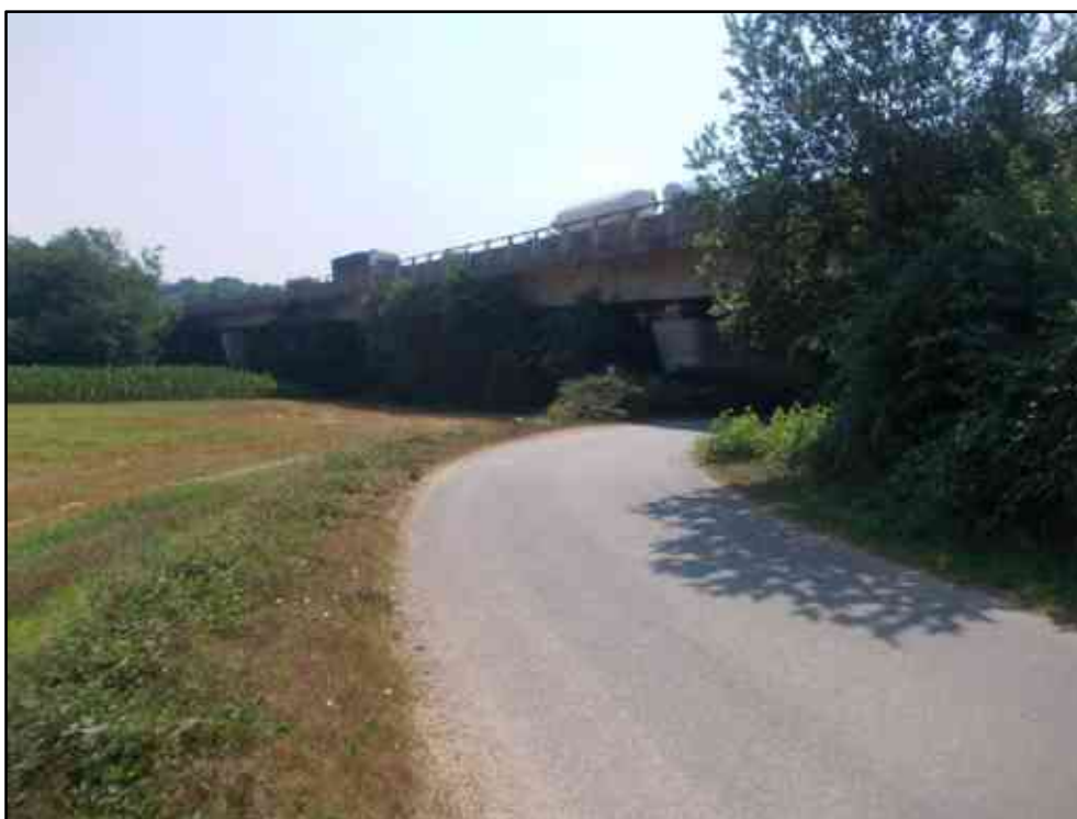
Figura 118 – Vista settentrionale del viadotto Lirone della A26-Genova Voltri/Gravellona Toce, in corrispondenza del varco V18- Borgomanero/Cressa.
