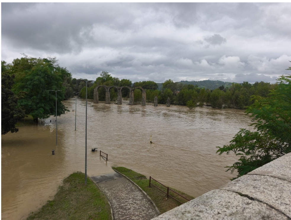
Figura 4. Zona Bagni: esondazione del fiume Bormida a valle della confluenza tra Bormida di Spigno e Bormida di Millesimo. Comune di Acqui Terme (AL). Fonte Regione Piemonte
