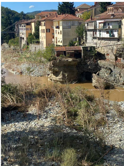
Figura 16. Lavatoi sul torrente Valla danneggiati a seguito della piena. Comune di Spigno Monferrato. (AL). Fonte Regione Piemonte
