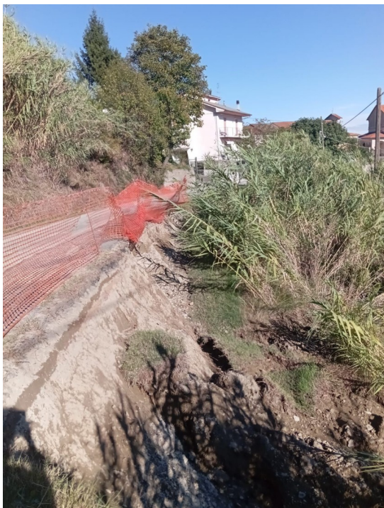
Figura 27. Strada comunale in prossimità dell'abitato di Frazione Montaldo. Comune di Spigno Monferrato (AL). Fonte Regione Piemonte
