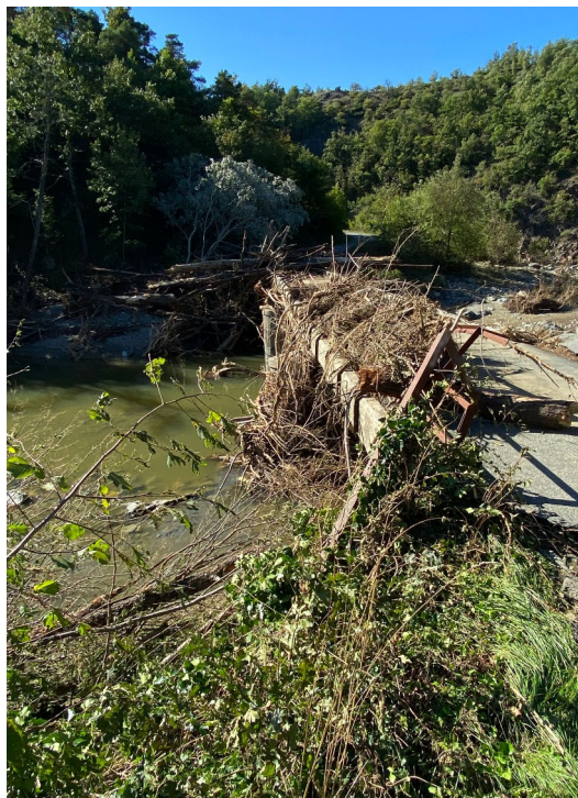
Figura 28. Ponte in località Gallareto. Comune di Spigno Monferrato (AL). Fonte Regione Piemonte
