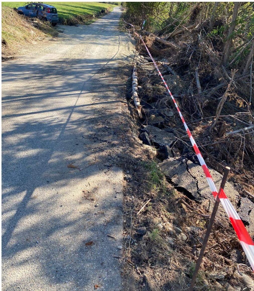
Figura 10. Strada comunale Martini-Bricco. Comune di Pareto (AL). Fonte Regione Piemonte
