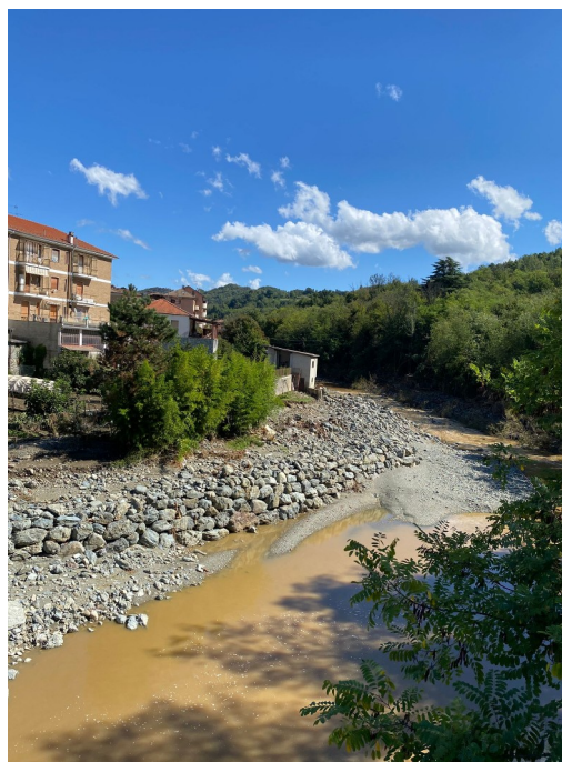
Figura 19. Torrente Valla: asportazione scogliera in corrispondenza del centro abitato. Comune di Spigno Monferrato. (AL). Fonte Regione Piemonte
