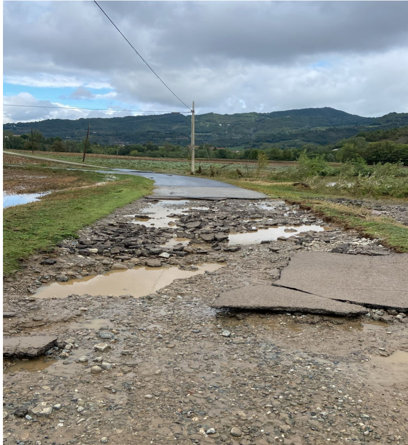
Figura 32. Danni strada causati dalla Bormida di Spigno. Comune di Mombaldone (AT). Fonte Regione Piemonte
