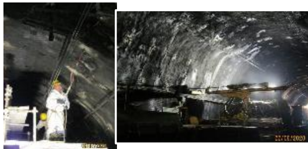
Interventi realizzati nella Galleria di Valenza
