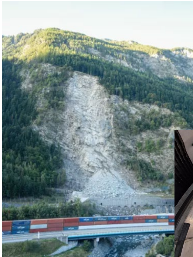
Frana in Maurienne (2023) 19 mesi di interruzione (Foto. SNCF Réseau)
