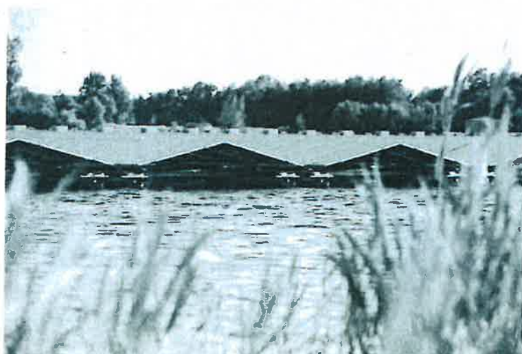
Esempio di impianto fotovoltaico flottante.
