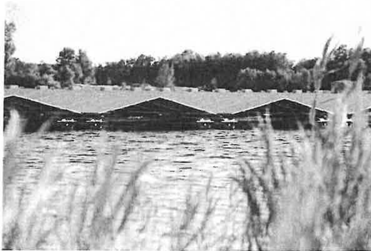
Esempio di impianto fotovoltaico flottante.
