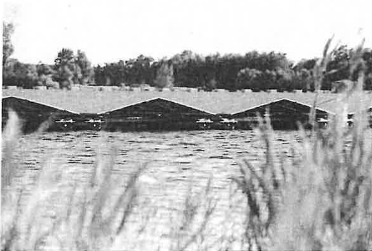
Esempio di impianto fotovoltaico flottante.
