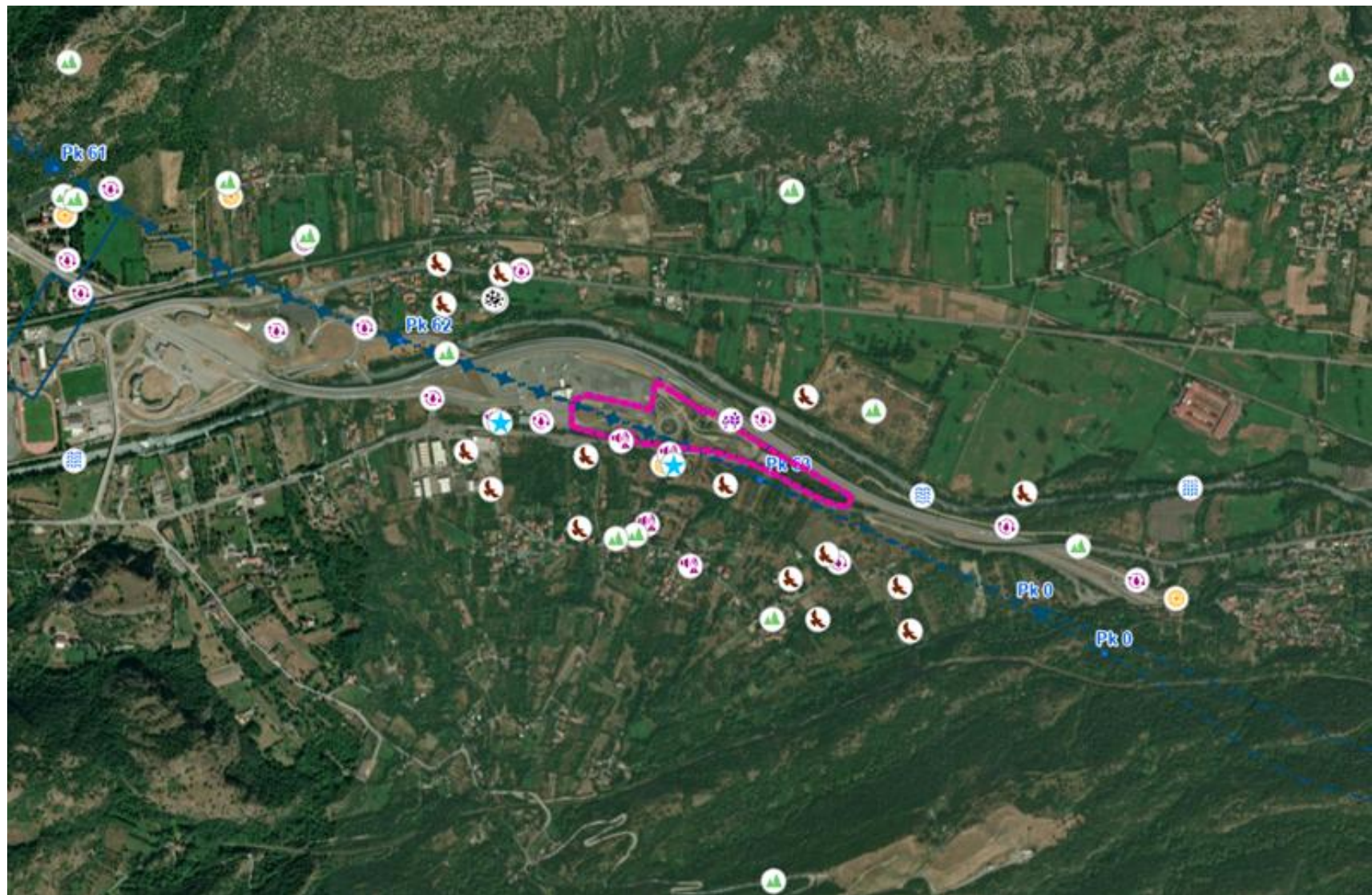
Realizzazione delle cantierizzazioni previste dal Progetto Esecutivo di 1a Fase in area Ex Pista Guida Sicura
