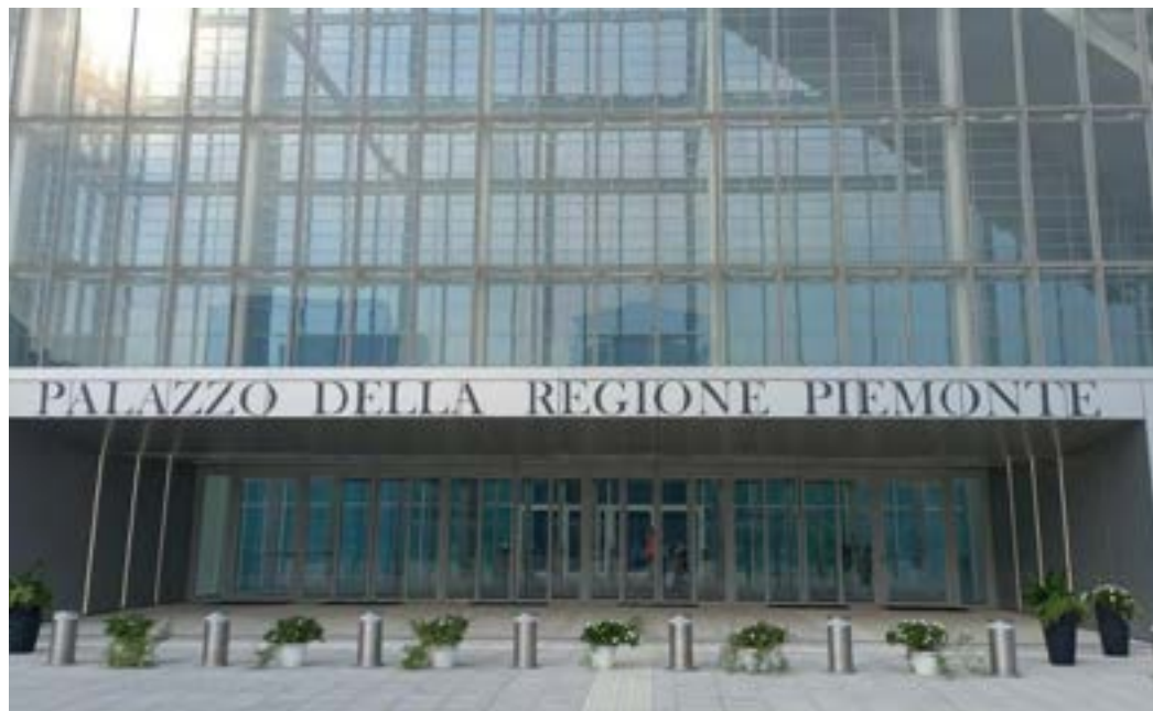
Il Grattacielo Piemonte, sede della Regione, nel quartiere Lingotto di Torino, dove si riunisce la Giunta
