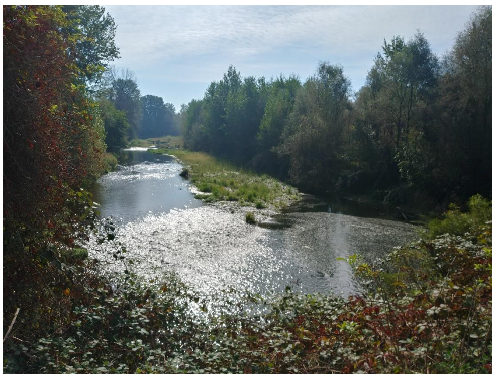
Figura 20 – Tratta 13 – Il torrente è obbligato ad un brusco cambio di direzione da nord-nord-ovest a nord-nord-est per la presenza di una massicciata a grossi blocchi di origine artificiale
