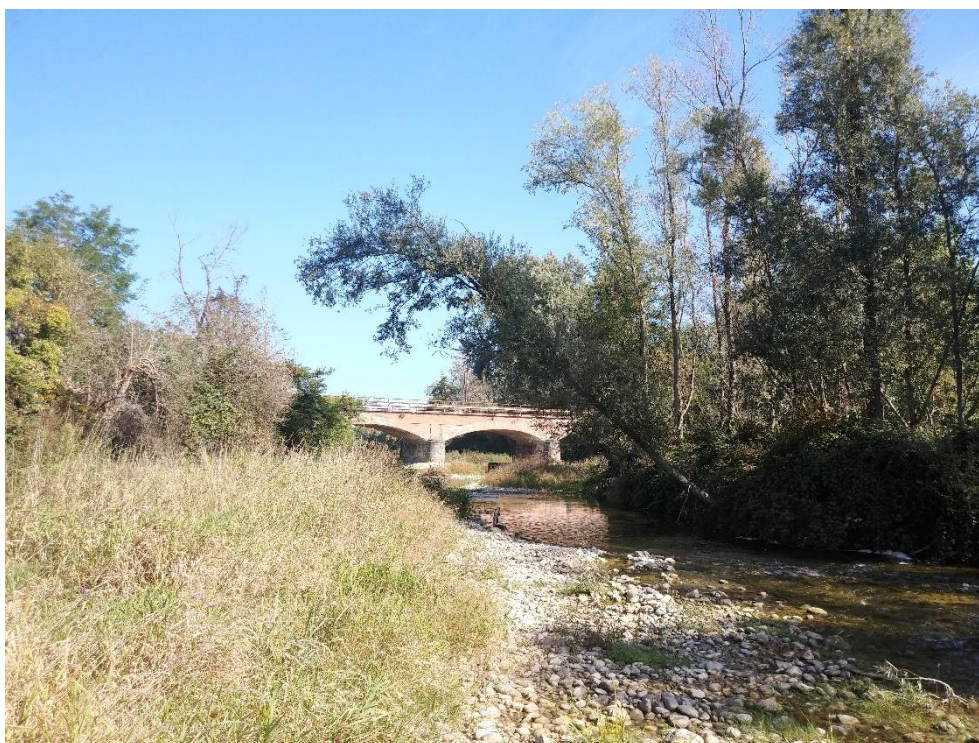
Figura 16 – Tratta 10 – Savigliano – ponte ferrovia (verso sud)
