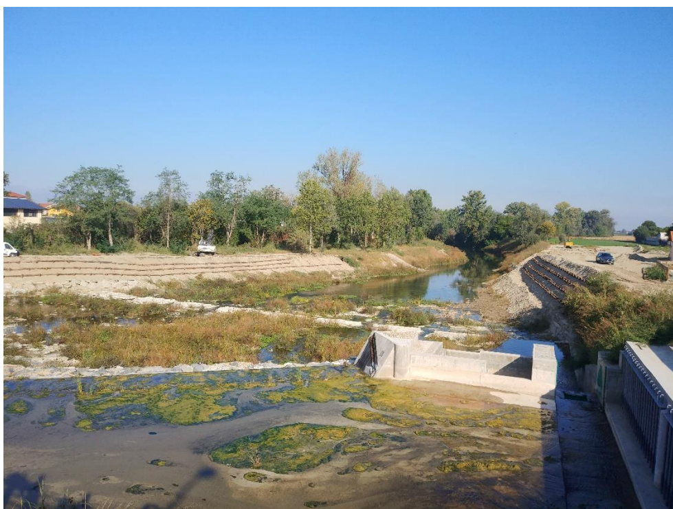
Figura 22 – Tratta 15-14: Ponte Regina Margherita di Racconigi:
