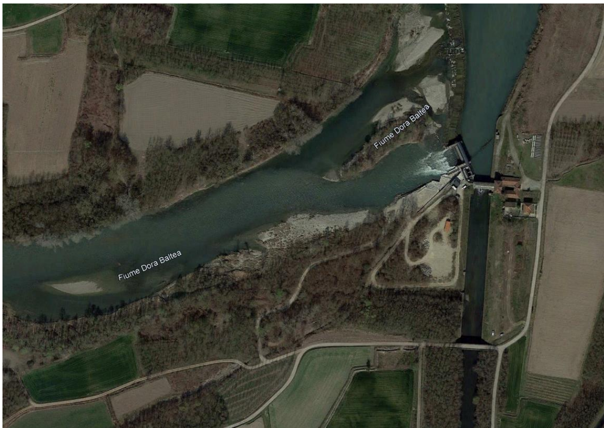
Figura 4-8: derivazione n.6 – COUTENZA CANALI CAVOUR (CONS. EST/OVEST SESIA)
