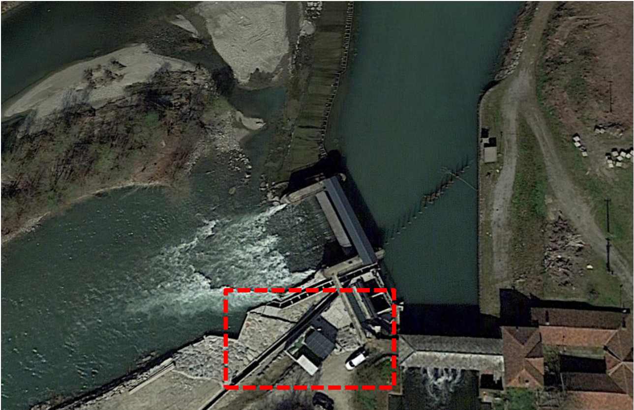
Figura 5-13: localizzazione della centralina idroelettrica
