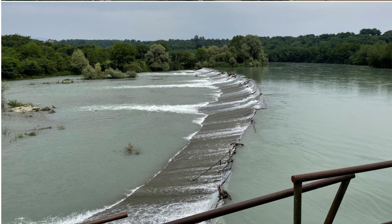
Figura 5-11: derivazione Canale Depretis; localizzazione sopra e sbarramento sotto
