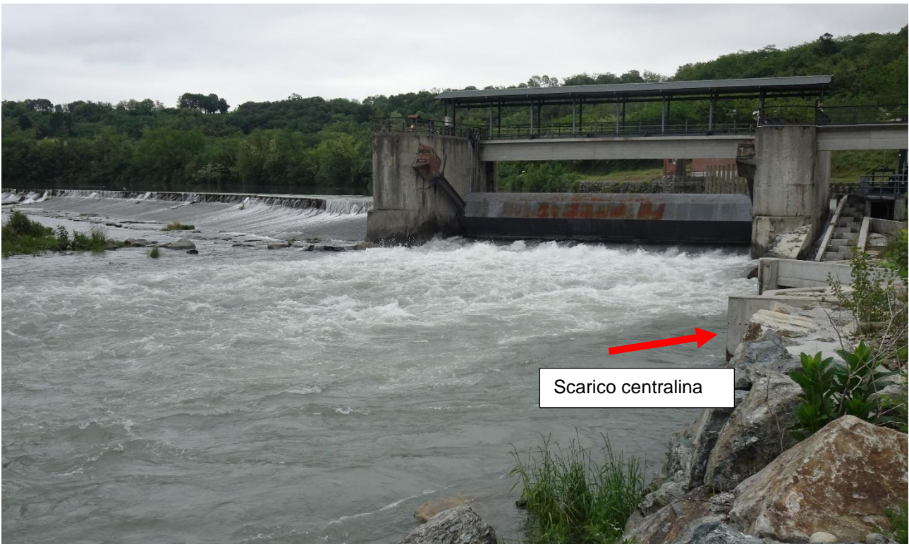
Figura 5-14: rilascio della centralina (a dx) e della paratoia di regolazione
