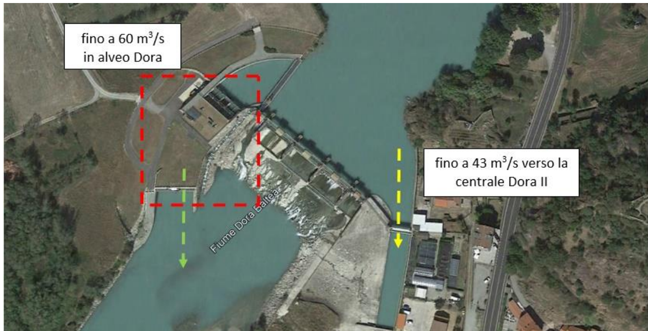
Figura 5-4: traversa di Montestrutto
