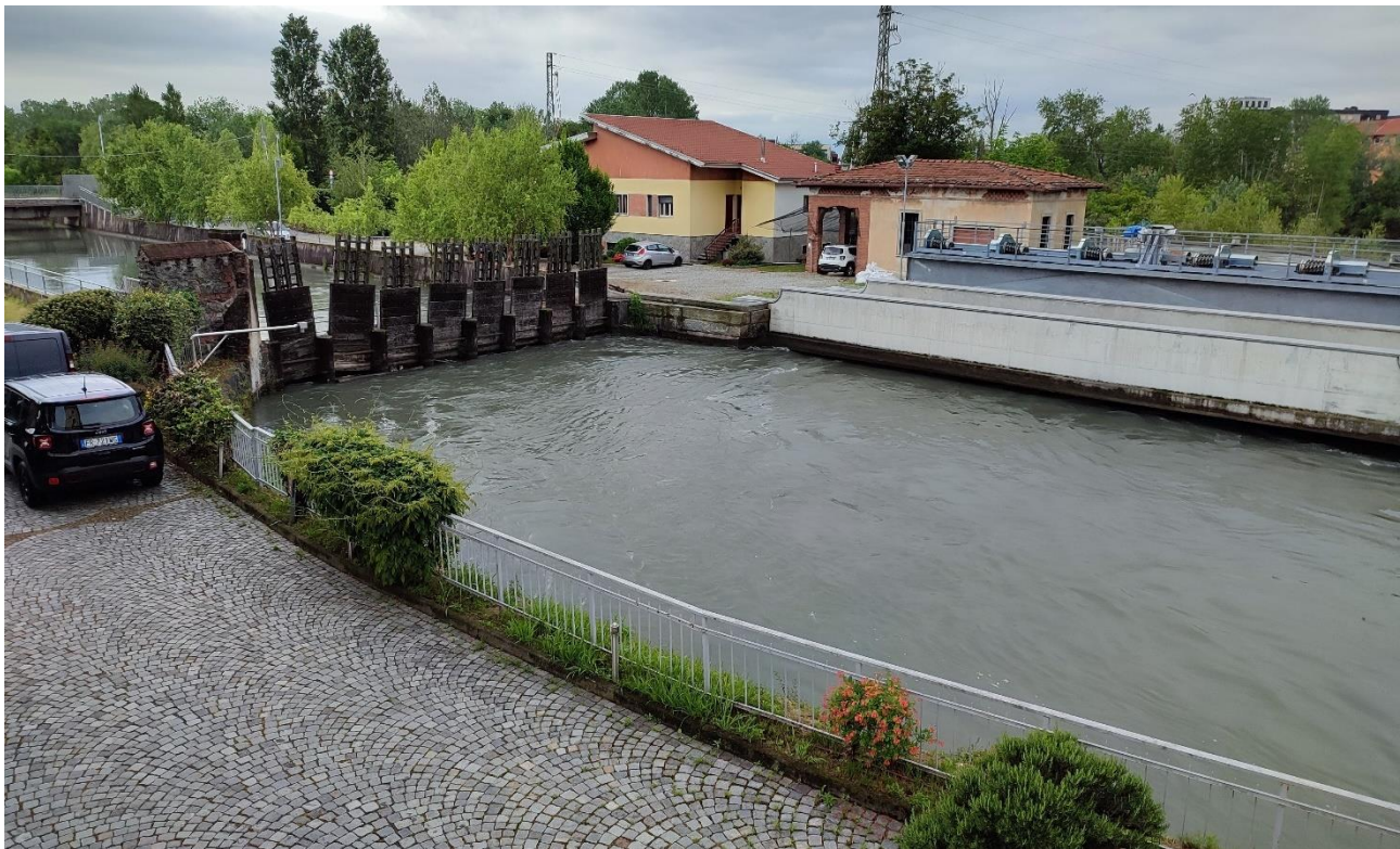
Figura 5-10: derivazione Naviglio di Ivrea a sinistra e derivazione idroelettrica a destra (sotto) e localizzazione (sopra)
