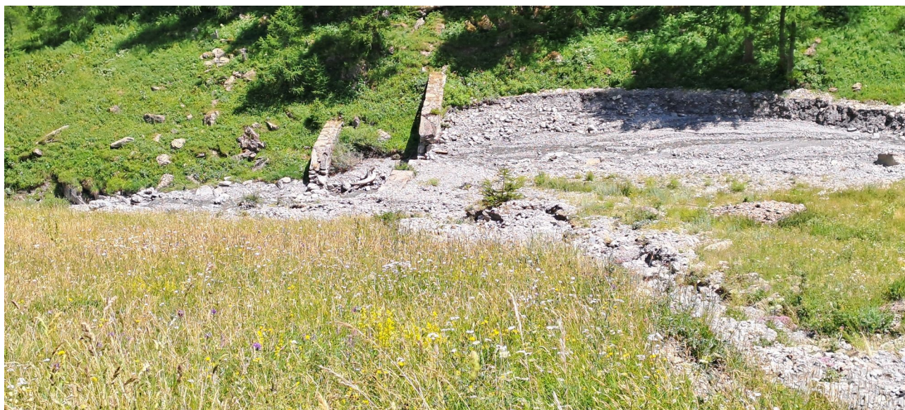
Figura 44. Vista laterale della briglia sul torrente Puriac alla confluenza con il rio Apparei. Foto del 4/7/2025. Fonte Regione Piemonte
