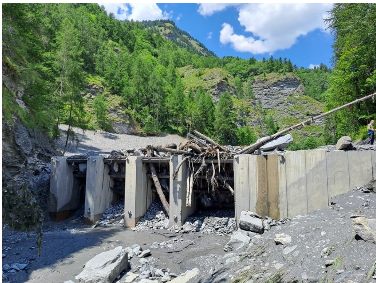
Figura 6. Briglia intasata sul rio Frejus. Foto del 1° luglio 2025. Fonte Regione Piemonte
