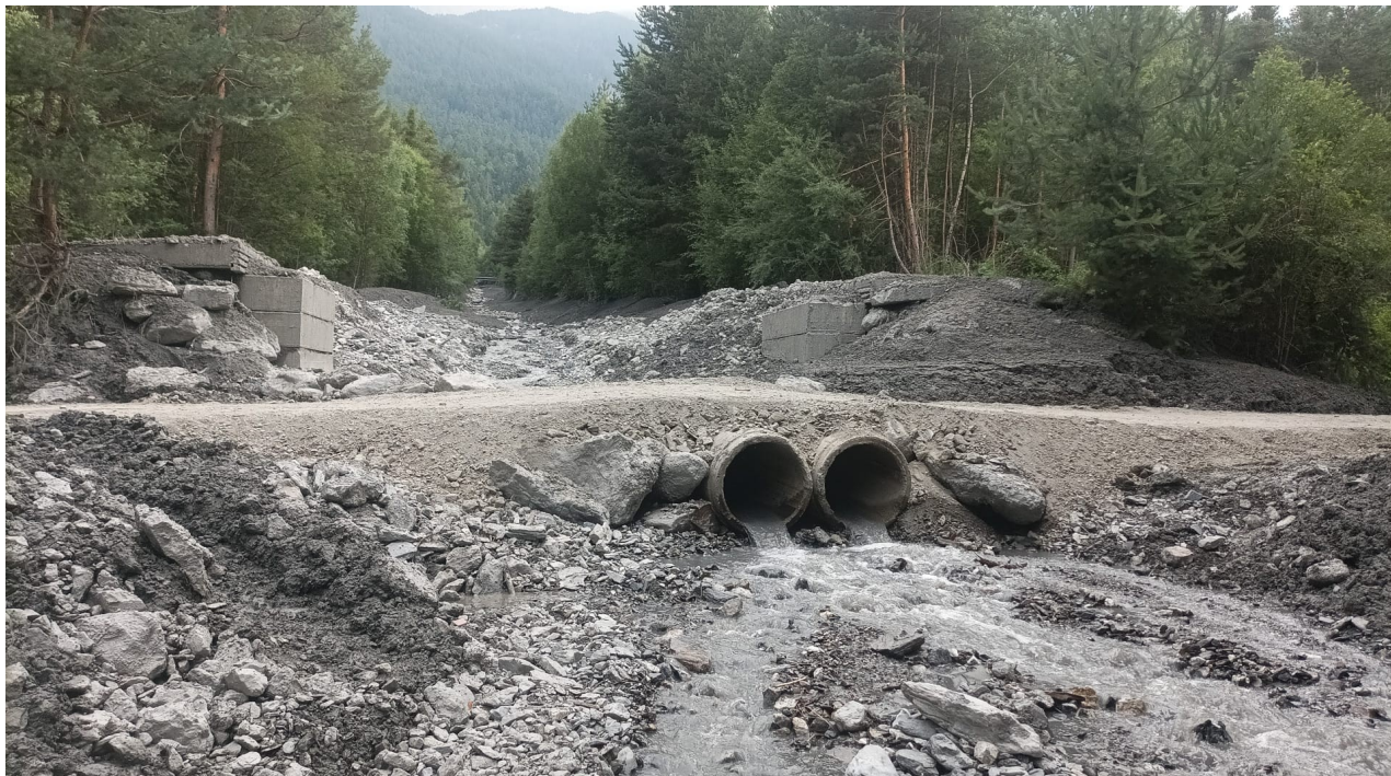
Figura 19. Sistemazione provvisoria sul rio San Giusto a Beaulard - Oulx (TO). Foto del 5 luglio 2025. Fonte Regione Piemonte
