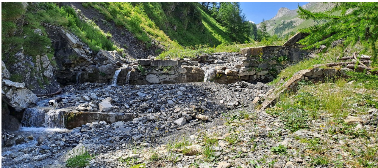
Figura 43. Vista da valle della briglia sul torrente Puriac alla confluenza con il rio Apparei. Foto del 4/7/2025. Fonte Regione Piemonte
