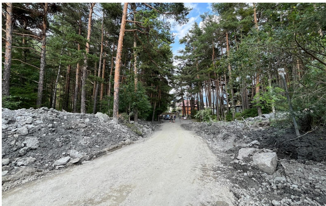
Figura 21. Accumulo di detriti e fango, già parzialmente rimossi, lungo Via del Mulino a Beaulard - Oulx (TO). Foto del 5 luglio 2025. Fonte Regione Piemonte
