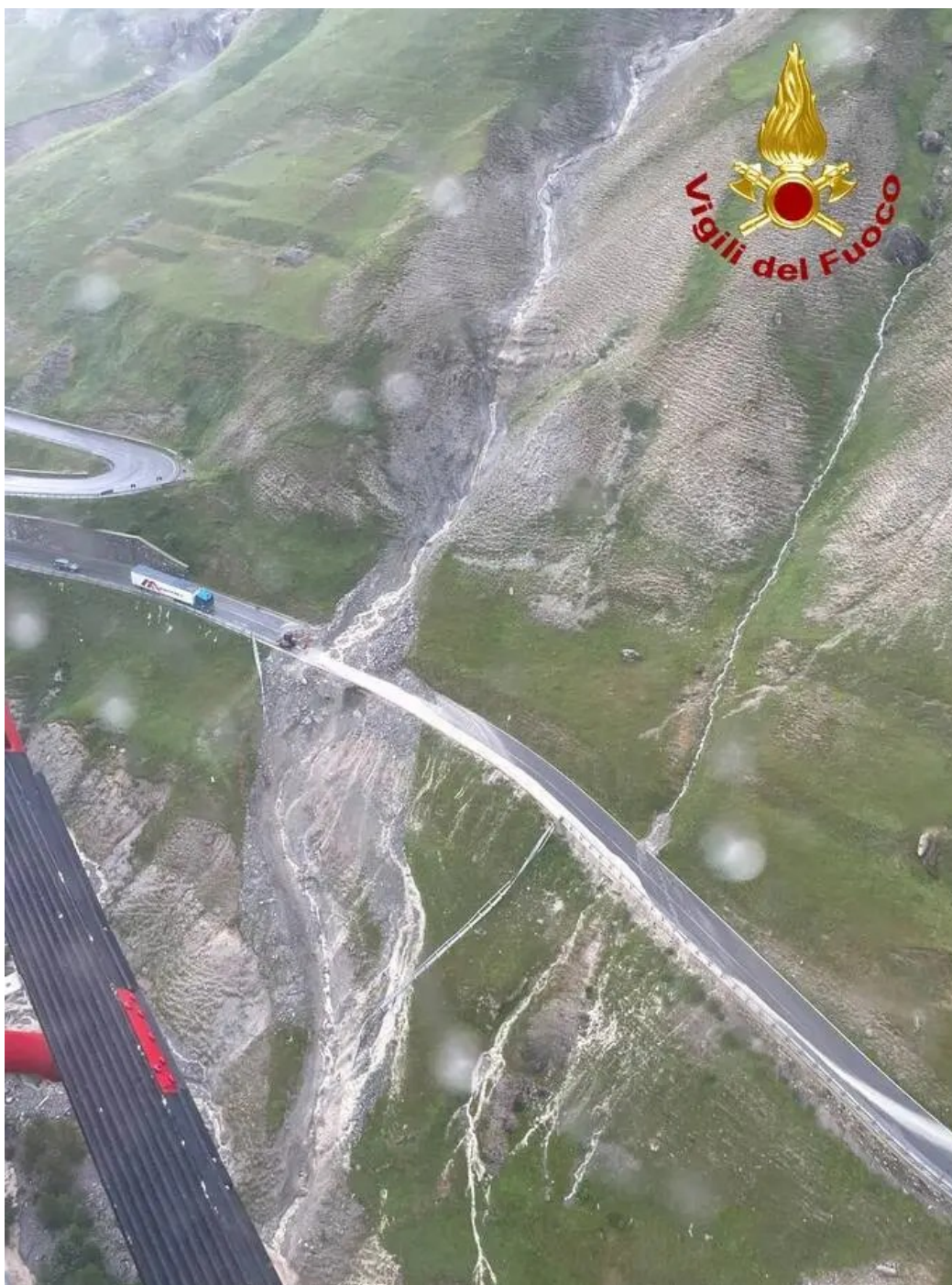
Figura 33. Fango e detriti sulla Strada Statale n.21. Fonte Vigili del Fuoco
