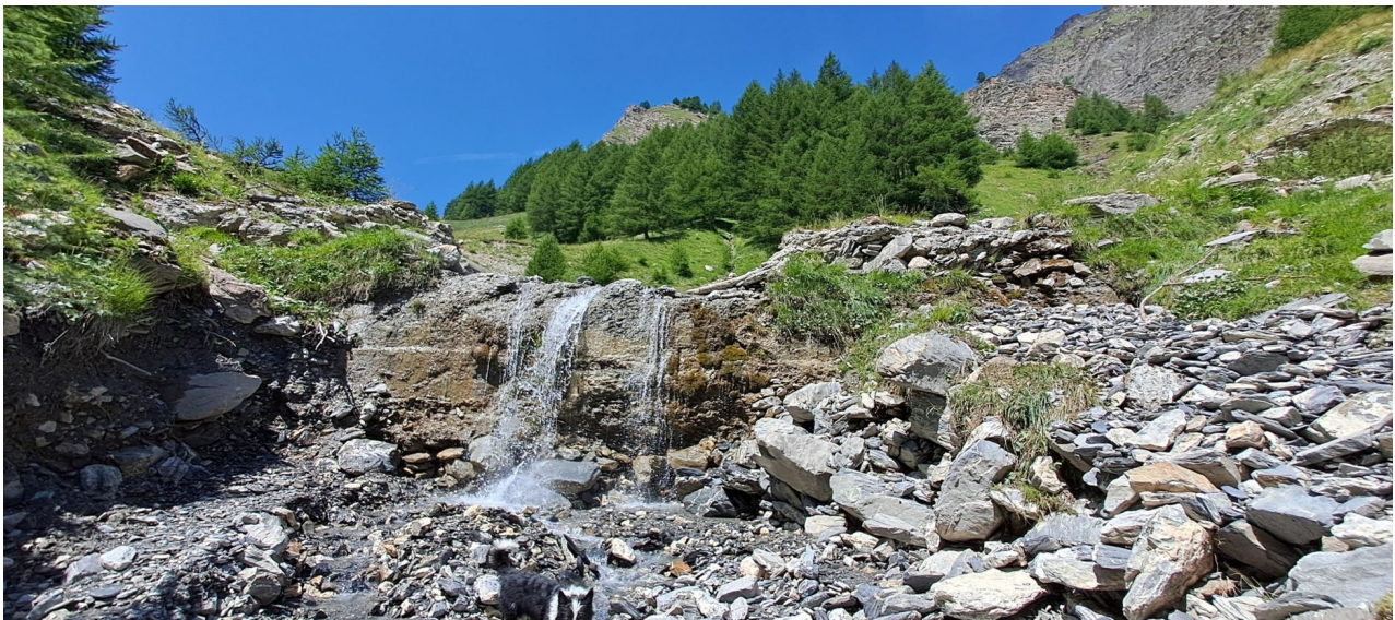
Figura 42. Briglia n.10 sul rio Apparei. Foto del 4/7/2025. Fonte Regione Piemonte
