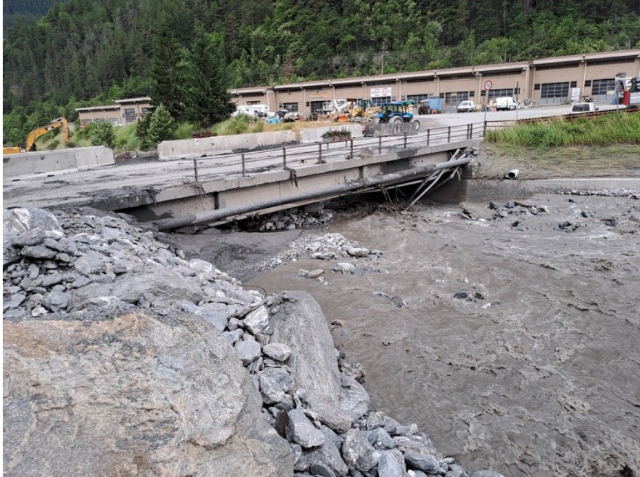
Figura 10. Ponte via Susa a Bardonecchia (TO). Foto del 1° luglio 2025. Fonte Regione Piemonte
