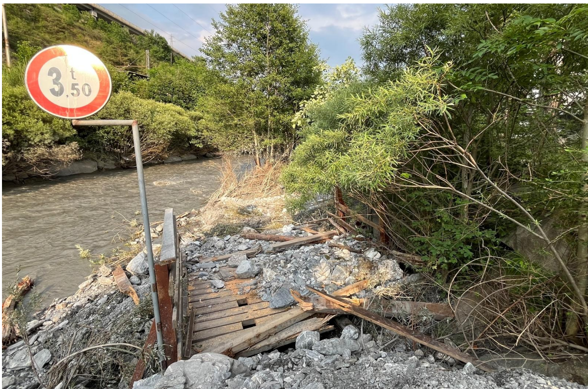
Figura 18. Resti del ponte in legno distrutto nell'alveo della Dora di Bardonecchia. Beaulard - Oulx (TO). Foto del 5 luglio 2025. Fonte Regione Piemonte
