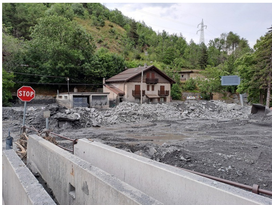
Figura 12. Fango e detriti sulla SS n.335. Abitazione e box privati già danneggiati ad agosto 2023. Foto del 1° luglio 2025. Fonte Regione Piemonte
