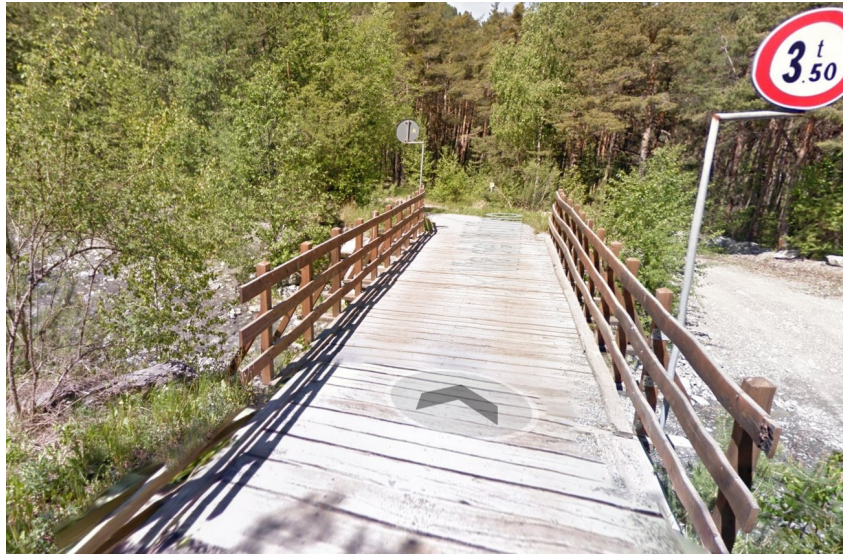
Figura 16. Ponte in legno sul rio San Giusto a Beaulard - Oulx (TO). Foto tratta da Google maps.
