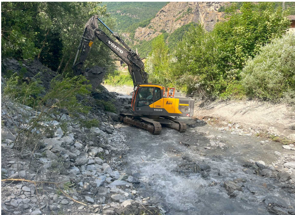
Figura 28. Rio Claretto a Novalesa (TO): intervento di sistemazione in somma urgenza. Foto del 7/07/2025. Fonte Regione Piemonte
