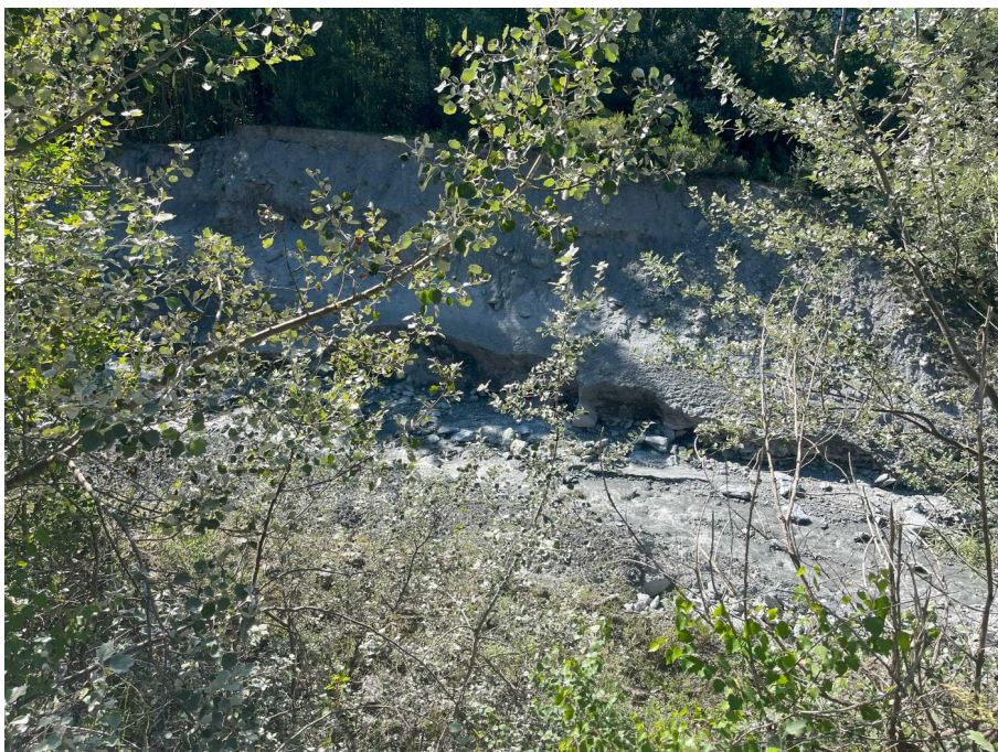
Figura 24. Rio Mardarello a Novalesa (TO): erosione di sponda. Foto del 7/07/2025. Fonte Regione Piemonte
