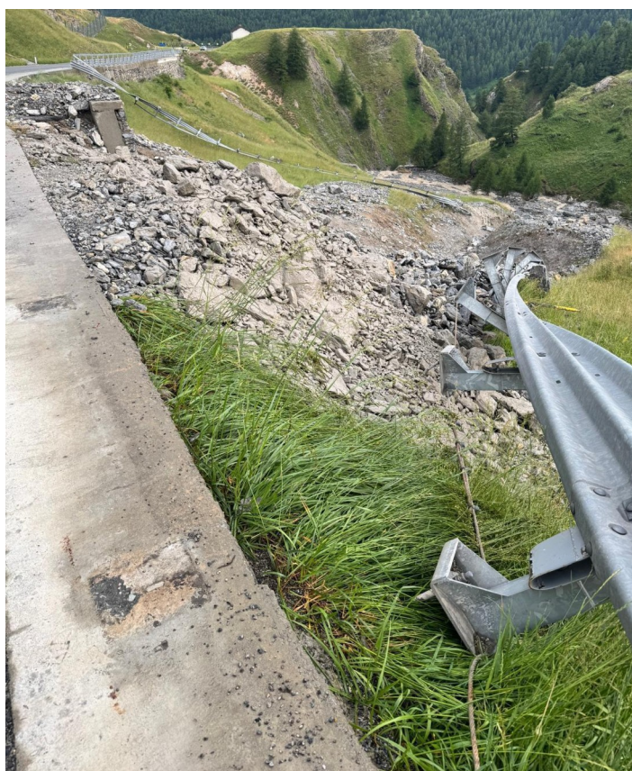
Figura 32. Guard-rail divelto lungo la Strada Statale n.21. Fonte Comune di Argentera
