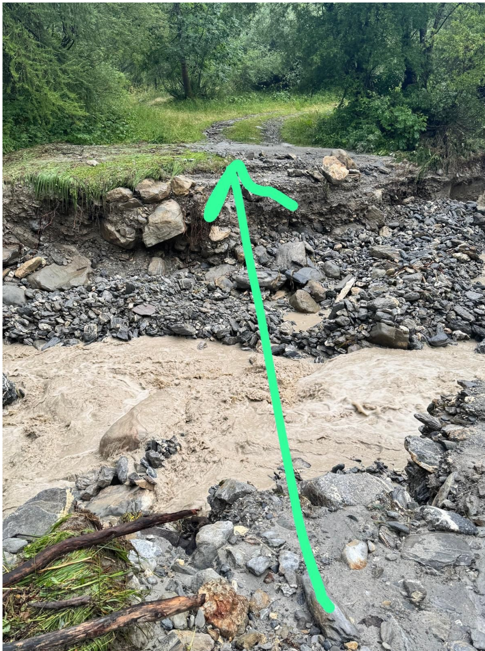
Figura 45. La freccia indica l'ubicazione del guado sul torrente Puriac che è stato asportato. Fonte Comune di Argentera (CN)
