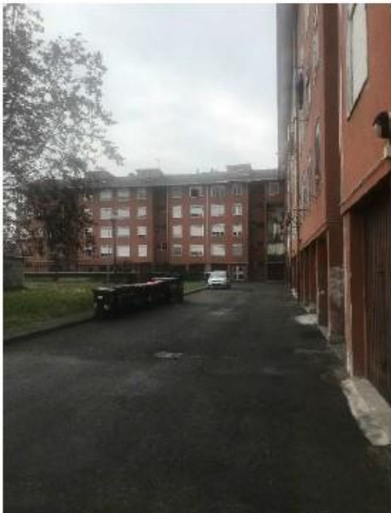
Figura 13 Casorati 38-50 vista interno cortile
