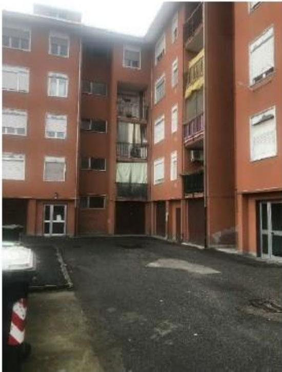
Figura 11 Casorati 38-50 interno cortile sud
