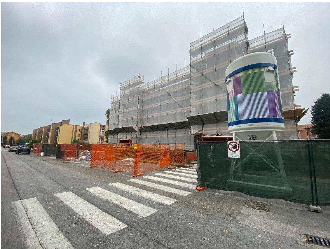
Cantiere via Ferrero
