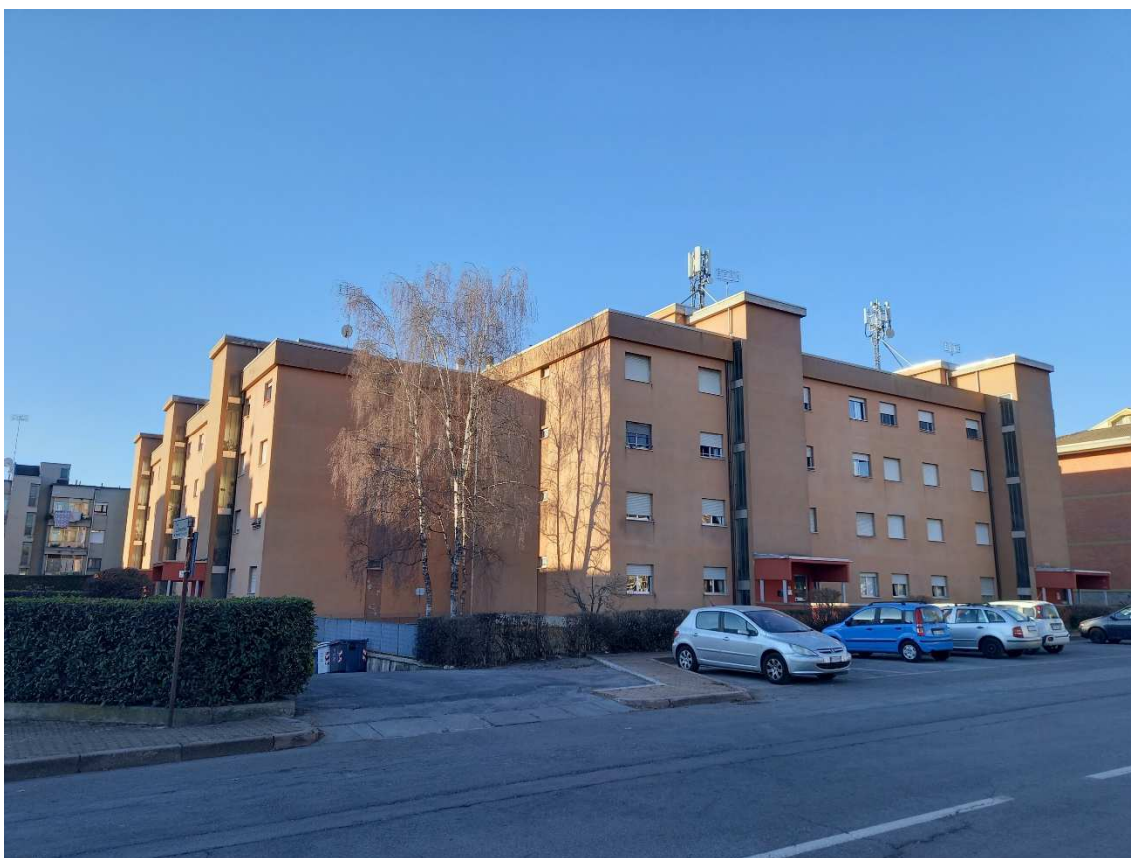
Prospetto via Ferrero ante lavorazioni
