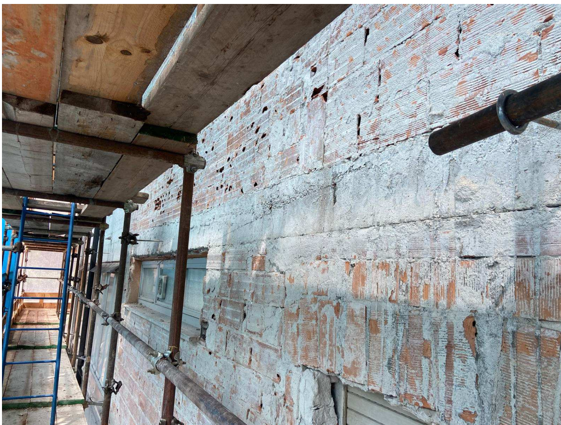
Rimozione intonaco
