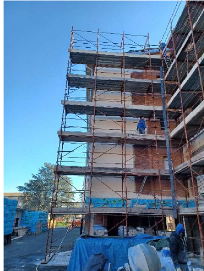
opere per antiribaltamento murature
