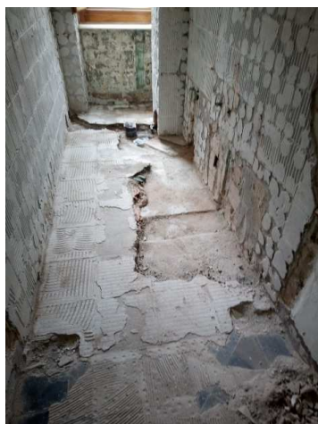
Demolizioni nel locale bagno
