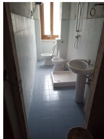
Locale bagno post lavorazioni
