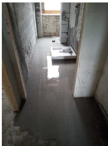
Lavorazioni in corso nel locale bagno
