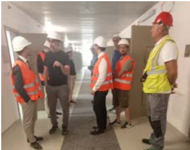
Un momento del sopralluogo. Per fine anno i lavori potrebbero essere completati. A destra, la Casa di reclusione "Giuseppe Montalto"
