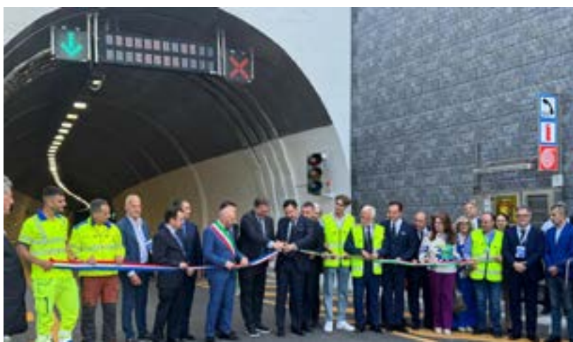
L'inaugurazione del nuovo tunnel del Tenda si è svolta venerdì 27 giugno
