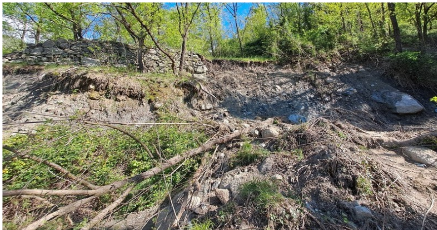
Figura 29. Frana su strada comunale a Caprie (TO). Fonte Regione Piemonte
