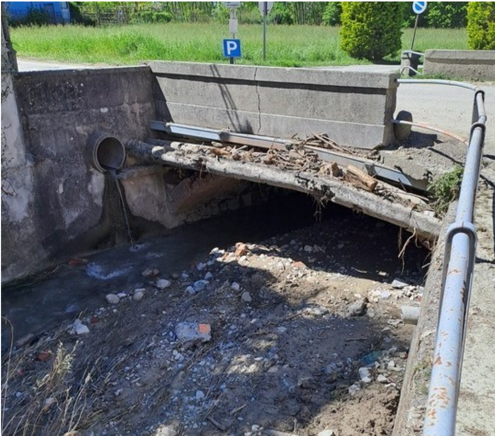
Figura 20. Rio della Valle – Monteu da Po (TO). Fonte Regione Piemonte
