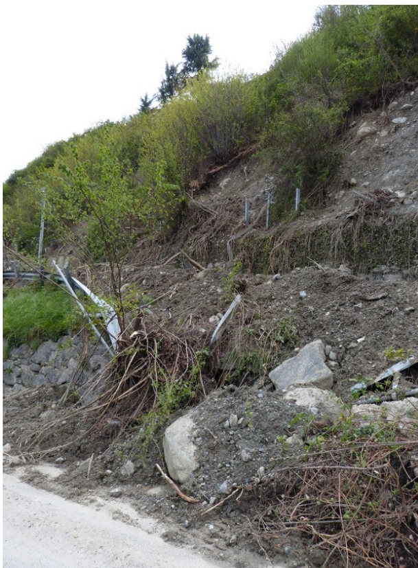
Figura 35. Danni al versante e al guardrail a Rubiana (TO). Fonte Regione Piemonte
