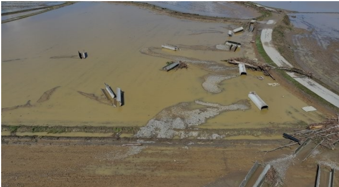
Figura 58. Danni ai canali di irrigazione per l'esondazione del fiume Sesia. Fonte Associazione d'Irrigazione Ovest Sesia
