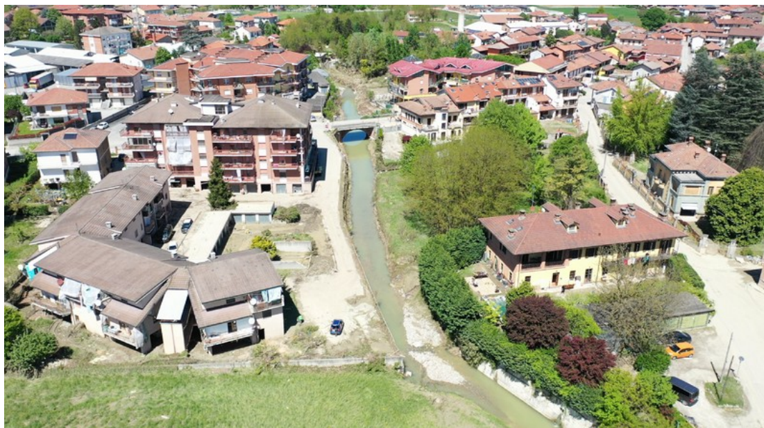
Figura 6. Complesso case ATC - Cavagnolo (TO). Data 24/04/2025. Fonte Regione Piemonte
