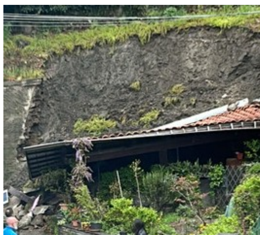
Figura 39. Smottamento in via Nazionale a Villar Perosa (TO). Fonte L'Eco del Chisone
