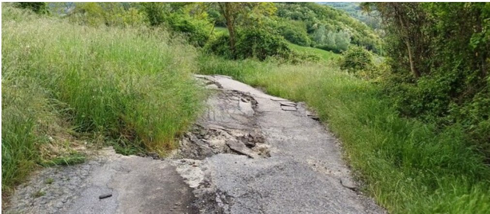
Figura 47. Comune di Castelletto-Merli SP n.18 al km 8+350. Foto Provincia di Alessandria
