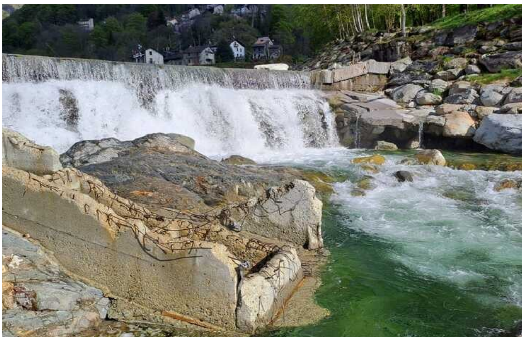
Figura 71. Torrente Cervo a Rosazza (BI), erosione di fondo e scala per la risalita dei pesci distrutta. Fonte Regione Piemonte
