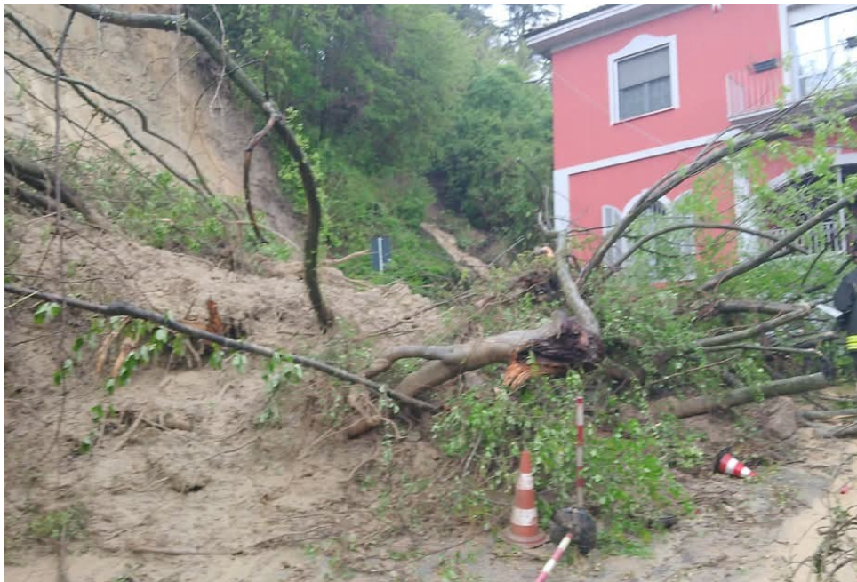
Figura 51. Frana su strada Monteriolo, Canelli (AT). Fonte Internet
