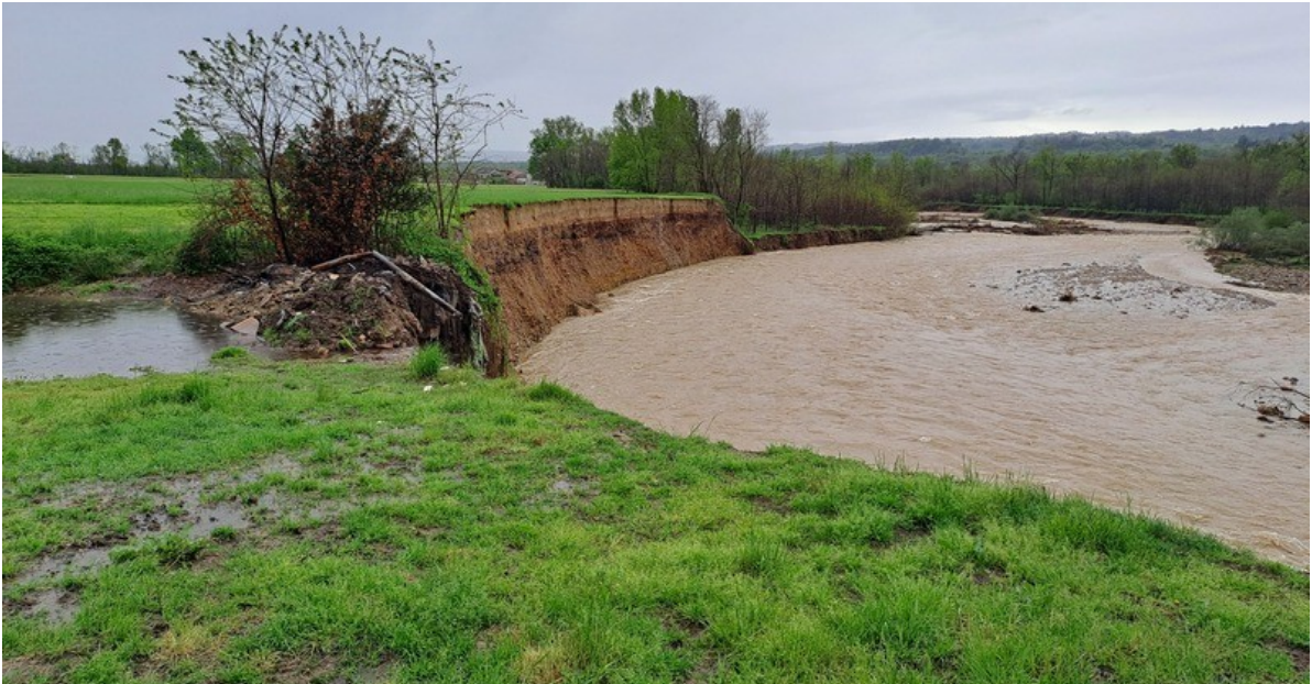
Figura 64. Erosione sponda sx torrente Elvo Comune di Mongrando (BI) in frazione Minazia. Fonte Regione Piemonte
