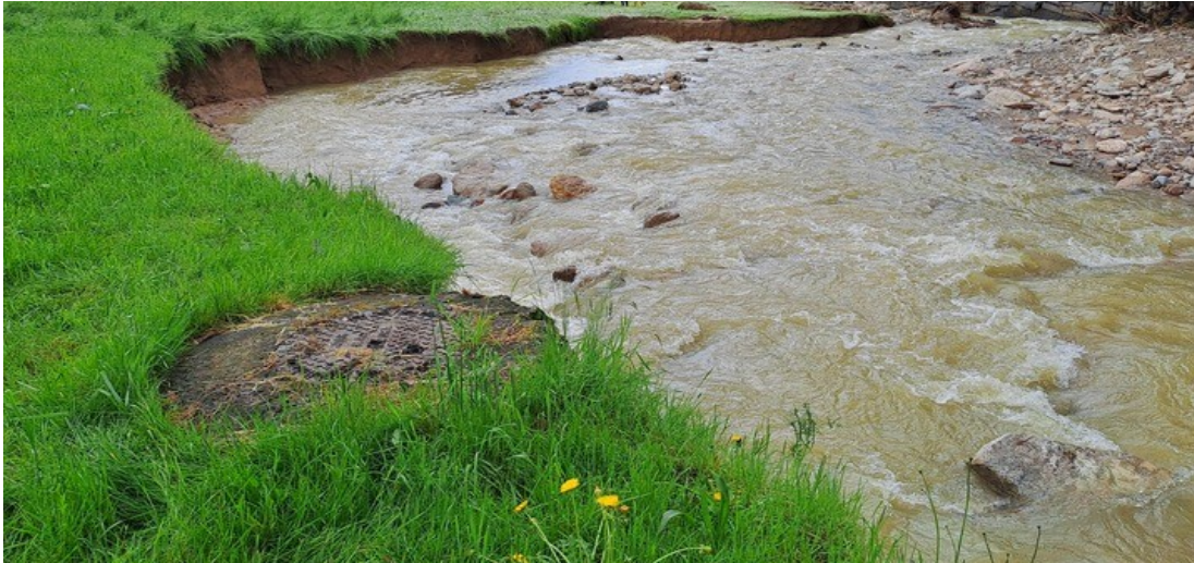
Figura 74. Torrente Eremo, erosione sponda sinistra, in primo piano il collettore fognario. Comune di Pollone (BI). Fonte Regione Piemonte
