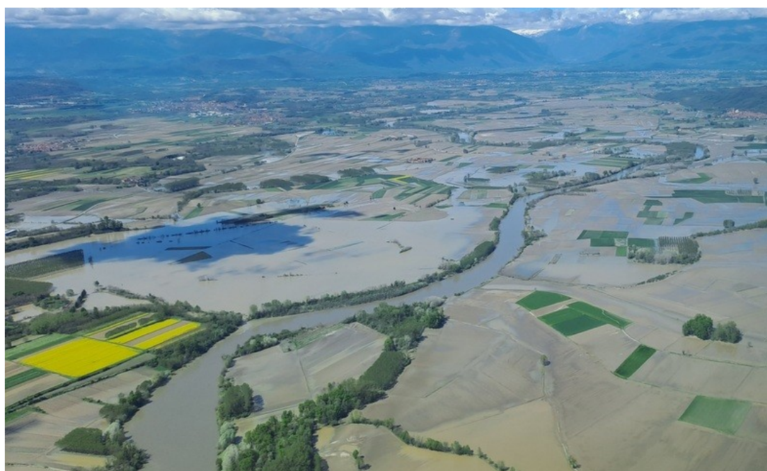
Figura 26. Esondazione Dora Baltea a valle di Ivrea (TO). Ripresa da volo aereo del 18 aprile 2025. Fonte Regione Piemonte
