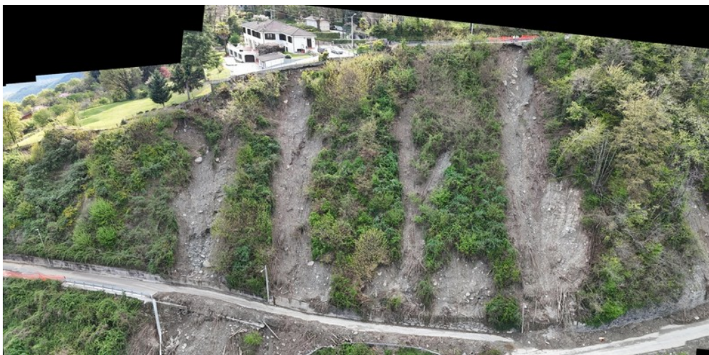
Figura 32. Frana in frazione Tetti a Rubiana (TO). Fonte P. Baggio
