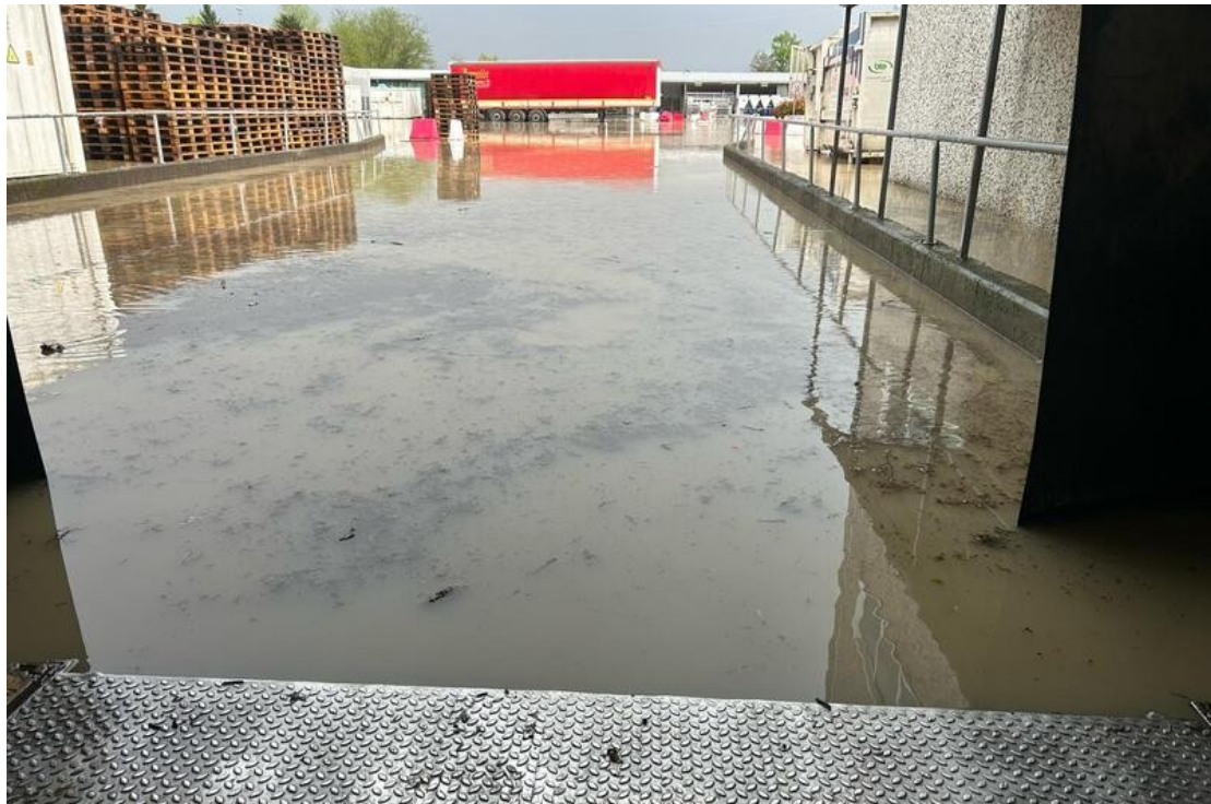
Figura 16. Allagamento stabilimento Caseificio Pugliese S.p.A. – Lauriano (TO). Fonte Internet
