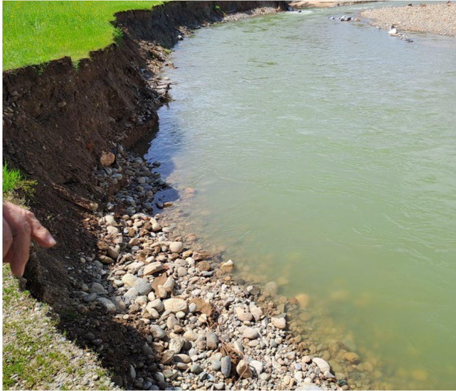
Figura 65. Erosione sponda dx torrente Elvo Comune di Cerrione (la fila di massi scarto cava indica il piede della sponda ante evento). Fonte Regione Piemonte
