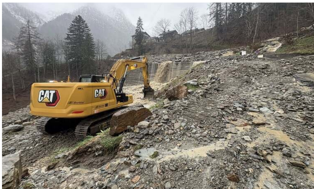
Figura 59. Intervento per rimuovere la colata detritica ad Alagna Valsesia. Fonte Comune di Alagna Valsesia (VC)
