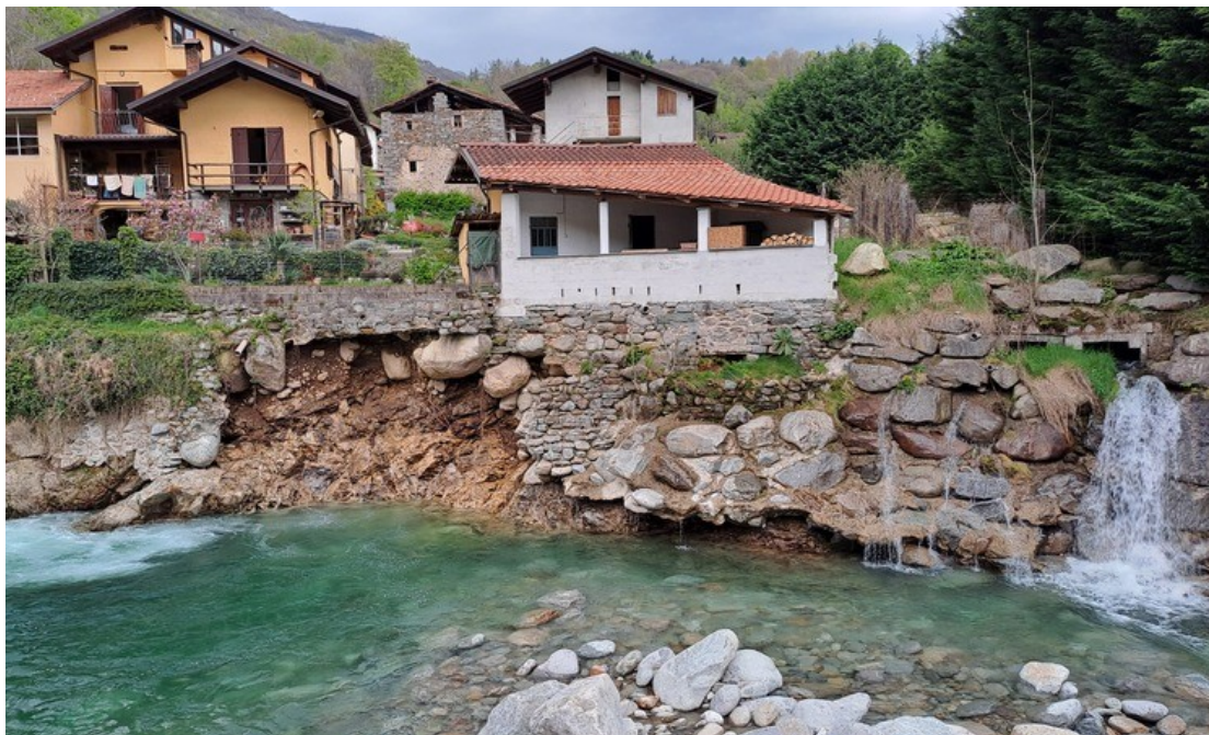
Figura 68. Erosione sponda sx del torrente Oropa in Comune di Pralungo frazione Valle. Fonte Regione Piemonte
