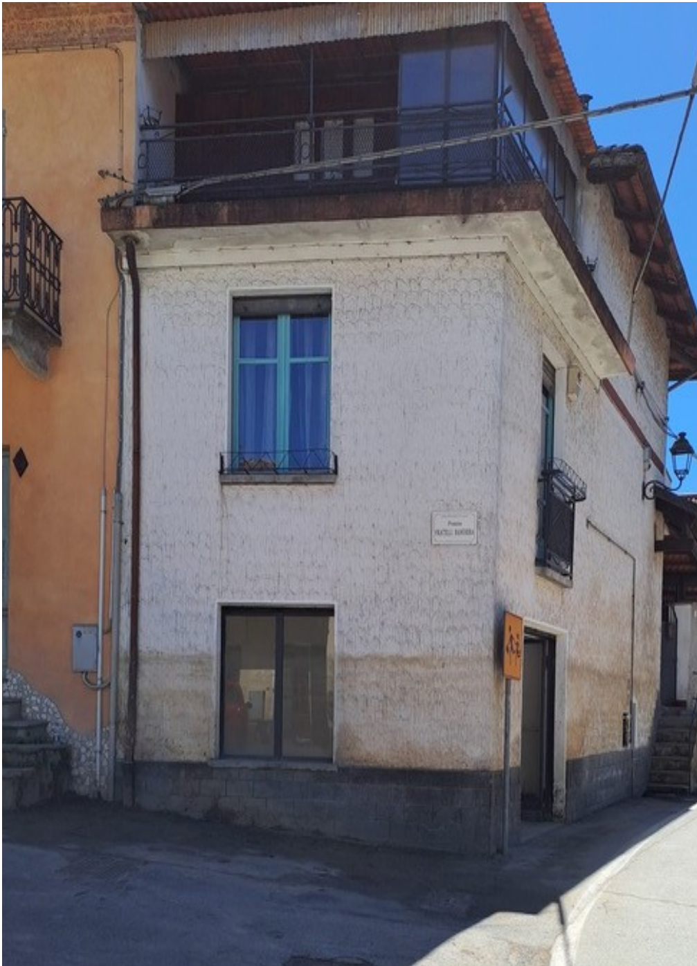
Figura 17. Piazza Fratelli Bandiera a Monteu da Po (TO). Evidenti le tracce di fango sui muri perimetrali delle abitazioni. Fonte Regione Piemonte
