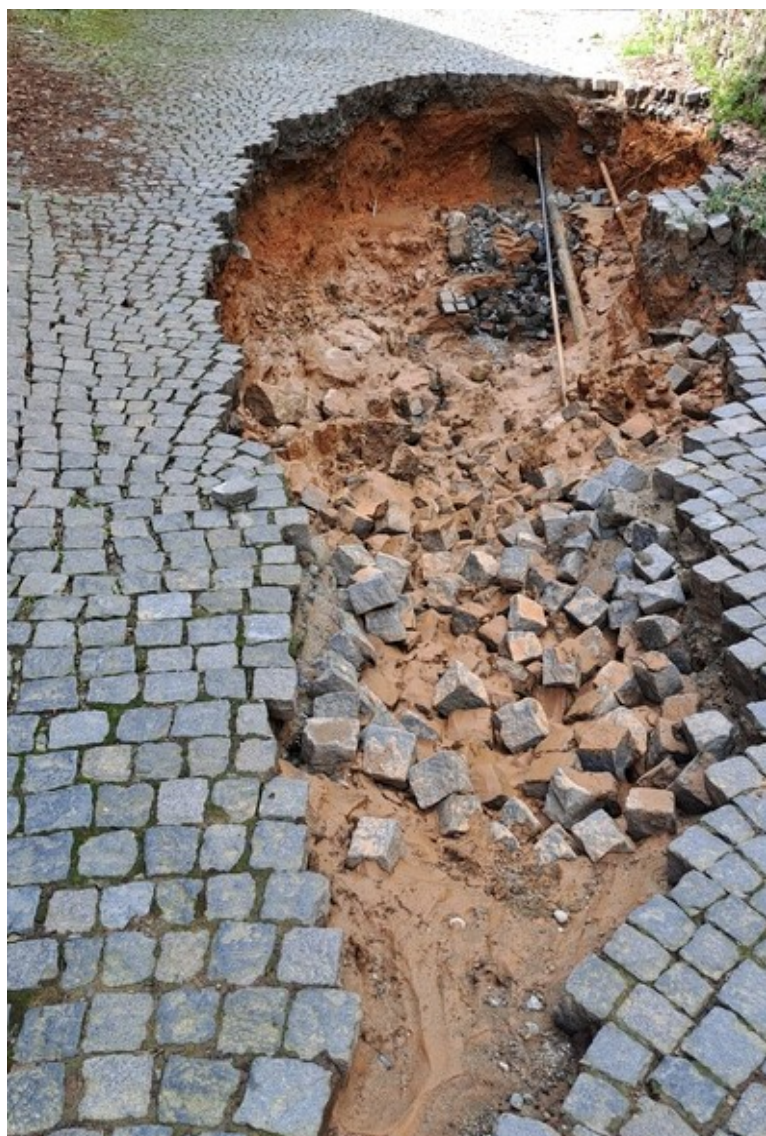
Figura 76. Allagamento via Dell'acqua in Comune di Biella. Fonte Regione Piemonte
