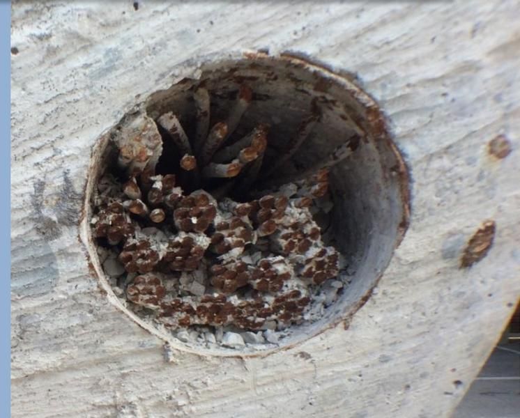
**CORROSIONE CAVI DI PRECOMPRESSIONE PER NON CORRETTA O DANNEGGIATA IMPERMEABILIZZAZIONE
