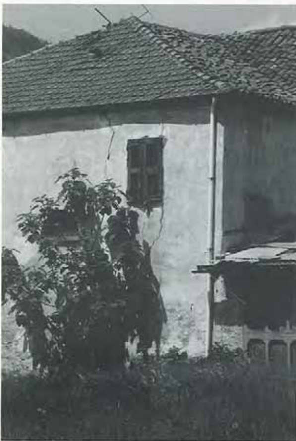
Figg. 2 e 3 - Case attualmente disabitate, lesionate nel 1924 a causa della riattivazione di un antico scorrimento traslativo.
