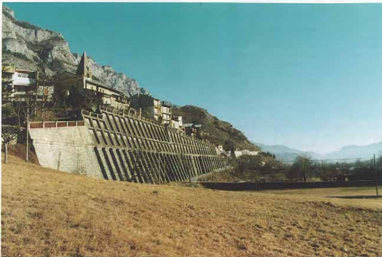
Fig. 5 - Veduta dell'intervento di consolidamento della scarpata sottostante il nucleo storico del centro abitato. Il muro a speroni fu costruito tra il 1891 e il 1957, in lotti successivi, per sostenere il ciglio della scarpata e impedirne l'ulteriore degrado.
