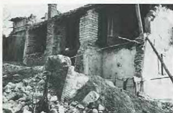
Fig. 7 - Un'abitazione di Brusaschetto ritratta nel 1955. Gli sprofondamenti delle sottostanti gallerie minerarie causarono periodici cedimenti differenziali del piano di posa e il conseguente crollo della struttura.
