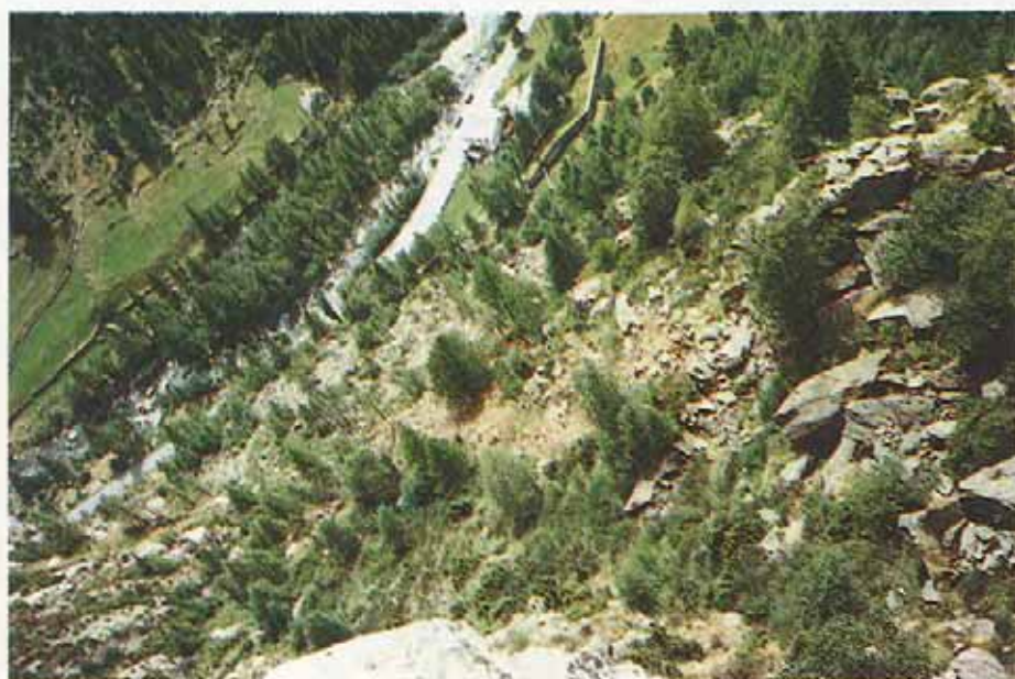
Fig. 4 - Visione dall'alto del canalone roccioso lungo il quale, in seguito alla frana verificatasi il 23 maggio 1984, sono scesi, con meccanismi di rotolamento, salti e rimbalzi, numerosi massi alcuni dei quali, deviando leggermente sulla destra, hanno danneggiato gli edifici e la strada sottostante.
