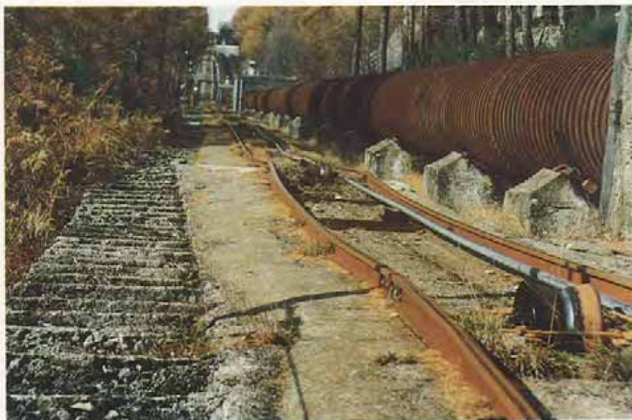
Fig. 3 - Impianto idroelettrico dell'A.E.M. di Torino. La foto mostra lo stato di deformazione del piano di risalita delle condotte. Visibili anche i cunei di legno utilizzati per correggere gli spostamenti differenziali venutisi a creare tra condotte e selle di supporto in seguito ai movimenti del terreno.
