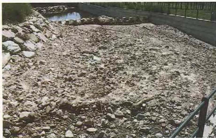
Fig. 5 - Vista da monte della cassa di sedimentazione costruita nel 1986 al piede del conoide dei rii Pisone e Sneira, suddivisa in due comparti da un briglia selettiva capace di trattenere complessivamente un migliaio di m 3 di materiale. Il 18 agosto 1987 l'opera entrò in funzione in seguito ad una piena ordinaria causata da un temporale estivo. La cassa, come mostra la fotografia, trattene la modesta quantità di materiale trasportato, ma le acque non riuscirono a defluire dal troppo stretto canale scolmatore ed allagarono le case circostanti.
