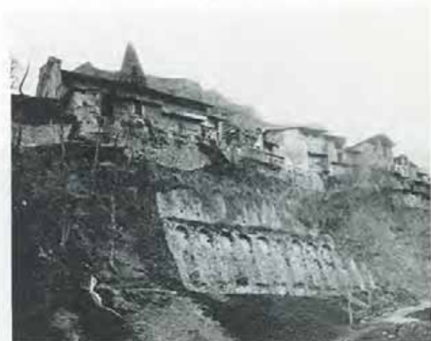
Fig. 4 - In questa foto del 1930 la scarpata sottostante l'abitato appare solo parzialmente interessata da interventi di sostegno (Archivio C.N.R.-I.R.P.I. Torino).
