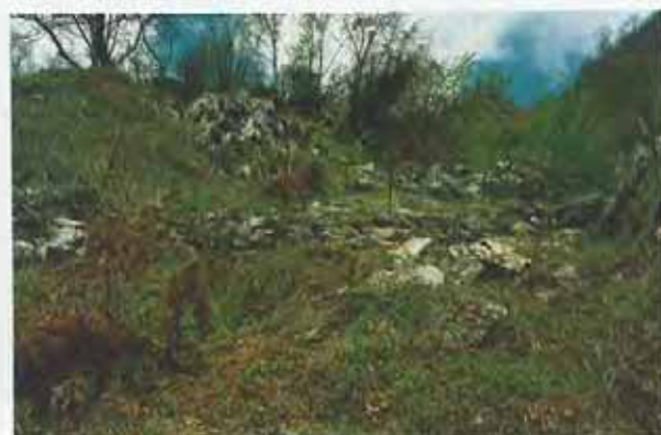
Fig. 2 - La stessa zona dopo l'intervento di demolizione dei massi di maggiori dimensioni; il materiale di risulta è stato utilizzato per costruire il muretto a secco visibile nella fotografia.
