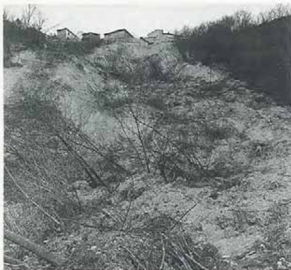
Fig. 4 - Versante meridionale dell'abitato coinvolto, il 9 marzo 1978, da un vasto movimento franoso che minacciò alcune abitazioni poste sul ciglio della nicchia di distacco.
