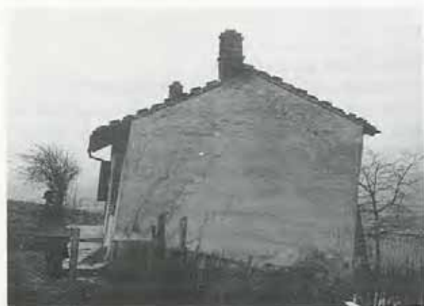
Fig. 5 - Abitazione di Brusaschetto, posta presso la strada comunale omonima, fotografata a metà degli anni '50. Malgrado gli speroni di rinforzo realizzati contro il muro di destra, rivolto a valle, la casa fu abbandonata e successivamente demolita.
