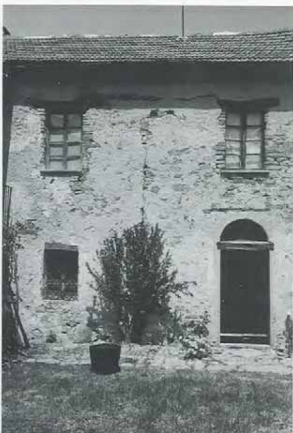
Figg. 2 e 3 - Case attualmente disabitate, lesionate nel 1924 a causa della riattivazione di un antico scorrimento traslativo.
