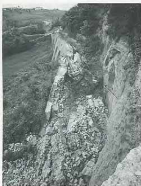
Figg. 3 e 4 - Il muro di sostegno sottostante Via Fantolino e il Pensionato Serratrice-Dafarra nel luglio 1941 subì gravi lesioni, con seria minaccia per le abitazioni soprastanti.
