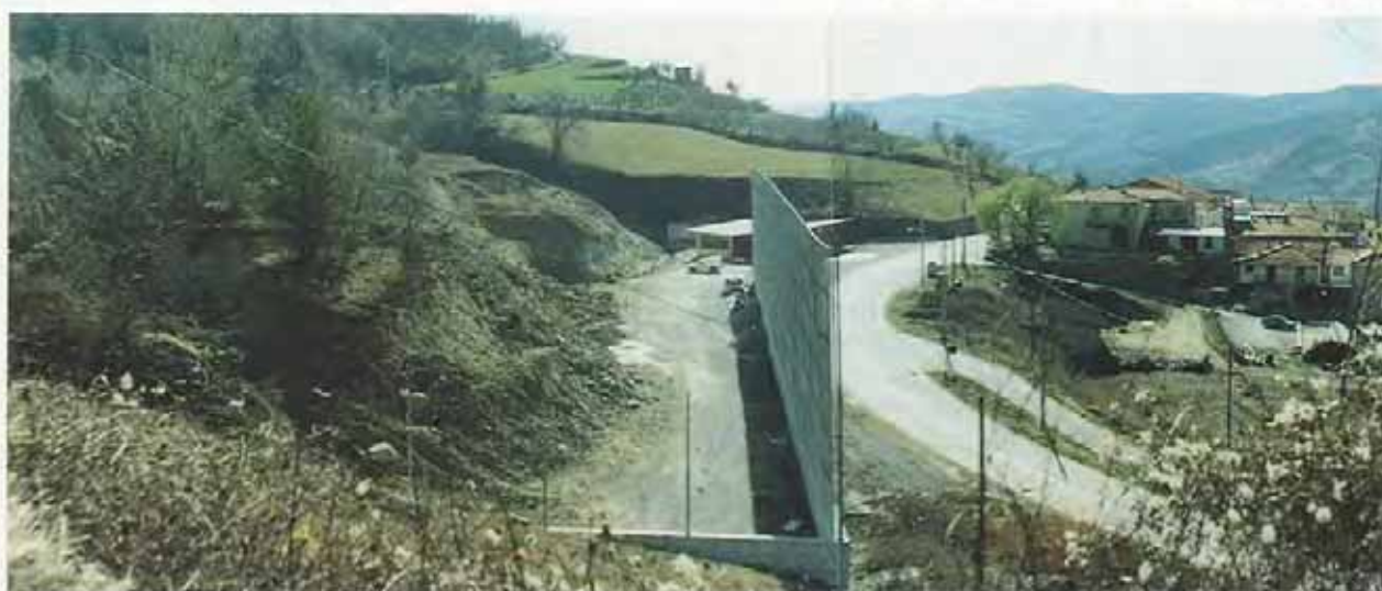
Fig. 2 - Particolare della parte inferiore della frana attivata nel 1926. Questa porzione dell'accumulo è oggi mascherata dalla strada Levice-Bergolo e dall'impianto sportivo, in corso di costruzione, al centro della fotografia. Proprio le operazioni di sbancamento attuate hanno riattivato parzialmente il movimento franoso che ha in parte invaso l'area sportiva.
