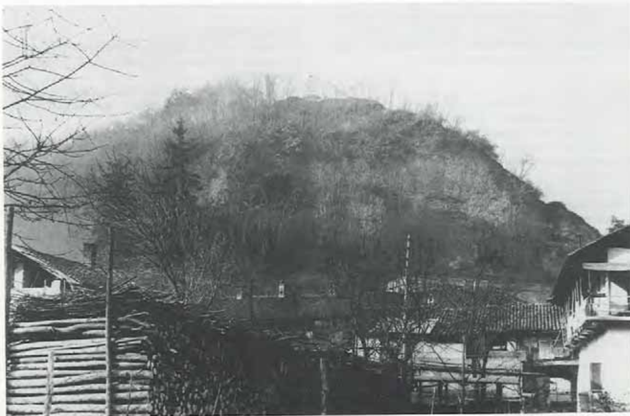
Fig. 1 - La fotografia mostra la situazione creata dopo la frana avvenuta nel dicembre 1960. La scarpata assunse una inclinazione media di 70^\circ con tratti anche verticali, per cui si crearono condizioni di ulteriore instabilità legate al rischio di arretramento del ciglio per frana (Archivio C.N.R.-I.R.P.I. Torino).
