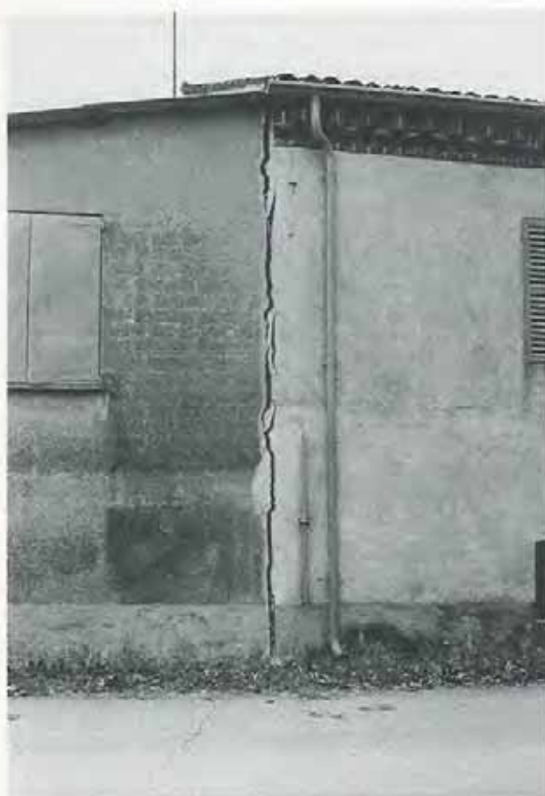
Fig. 3 - Fabbricato attualmente lesionato nel quale si rileva una profonda fenditura nel muro perimetrale, evidenziatasi verso l'inizio degli anni '80.
