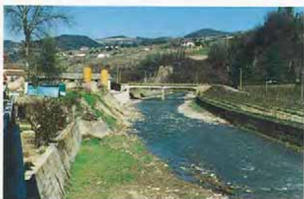
Figg. 1 e 2 - Confronto dello stesso tratto d'alveo del T. Belbo. In alto (estate 1926) è in fase di ricostruzione parte del ponte in pietra e della strada d'accesso al cimitero, asportati dalle acque in piena il 16 maggio del medesimo anno. In basso la situazione attuale: la sezione di deflusso del ponte è stata notevolmente ampliata, ma si notano purtroppo un restringimento dell'alveo, causa la presenza di riparti e manufatti in area allagabile.
