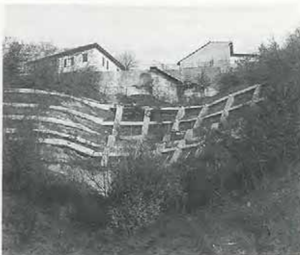
Figg. 2 e 3 - A sinistra il versante meridionale coinvolto nel movimento franoso del 9 marzo 1978, come appariva una settimana dopo l'evento; a destra come appare oggi la stessa zona dopo gli interventi sistematori realizzati nel 1980-81.
