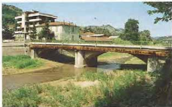
Fig. 2 - Ponte sul T. Belbo nel centro dell'abitato. L'opera di attraversamento ha una luce di circa 120 m 2 che potrebbe rivelarsi tuttora insufficiente se si ripetessero gli eventi di piena registrati nel 1948, 1951 e 1968.
