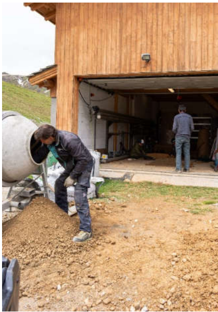
Mélange pour les fascines (sable + terre) Miscela per fascine (sabbia + terra)
