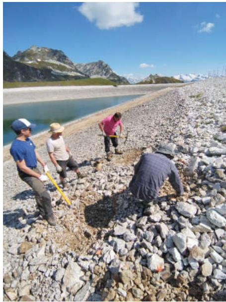
Intégration des fascines dans le revêtement de la retenue
