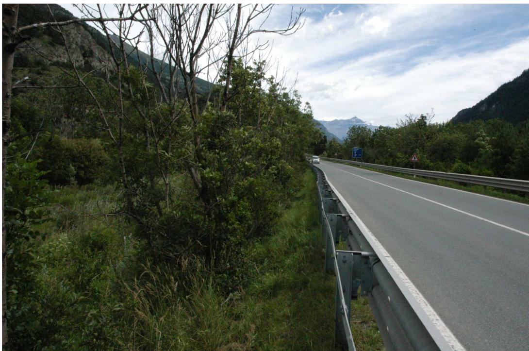
Foto 13. S.S. 24 – Autostrada A32 – Area interclusa: la visibilità dalla strada della fascia oltre il guard-rail è limitata dalla presenza di alberi e arbusti a ridosso della carreggiata.
