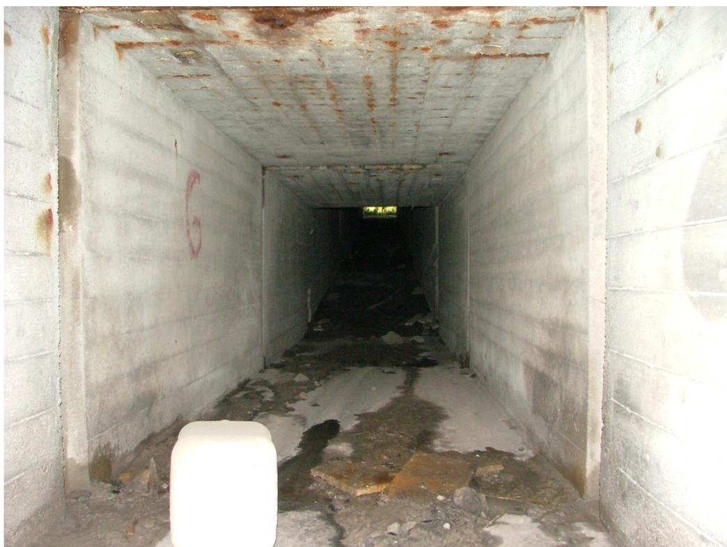
Foto 16. Strada comunale – Tombini autostradali: vista dell'interno del tombino. Le ridotte dimensioni permettono appena di intravedere l'uscita, sul basamento sono abbandonati materiali di scarto e, in caso di piogge abbondanti, il pavimento rimane completamente sommerso; tutte queste caratteristiche disincentivano l'uso da parte di animali anche di piccola taglia.
