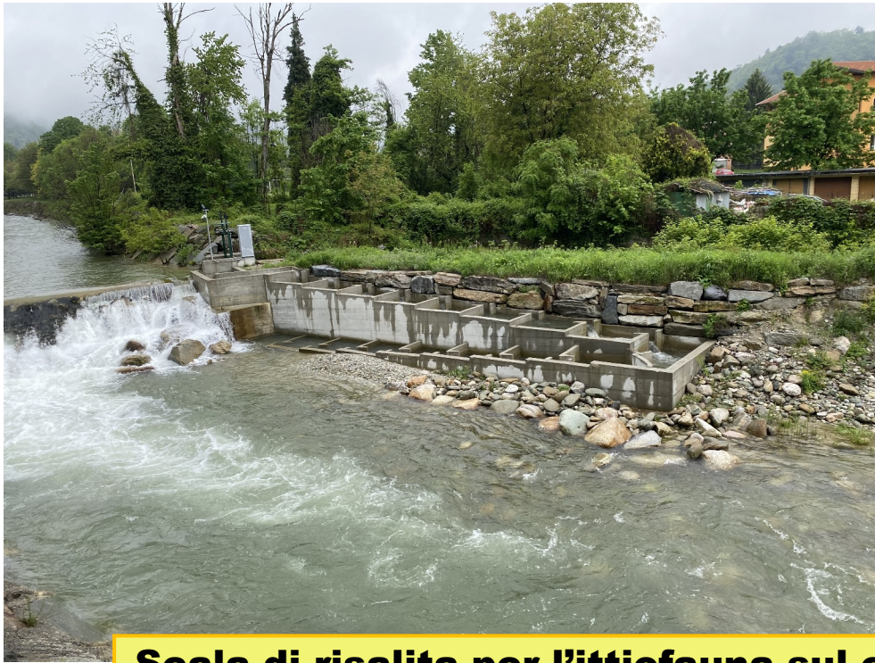
Scala di risalita per l'ittiofauna sul canale Vigne Combe, a destra il dettaglio della strumentazione di regolazione
