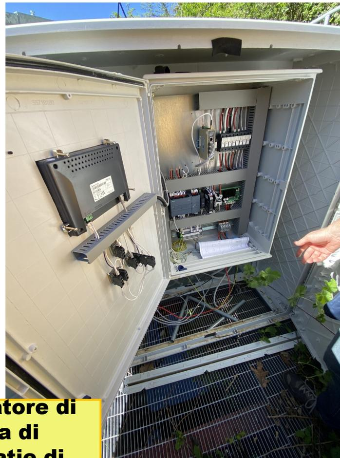
**Dettaglio del misuratore di portata e sistema di controllo delle paratie di deflusso**
