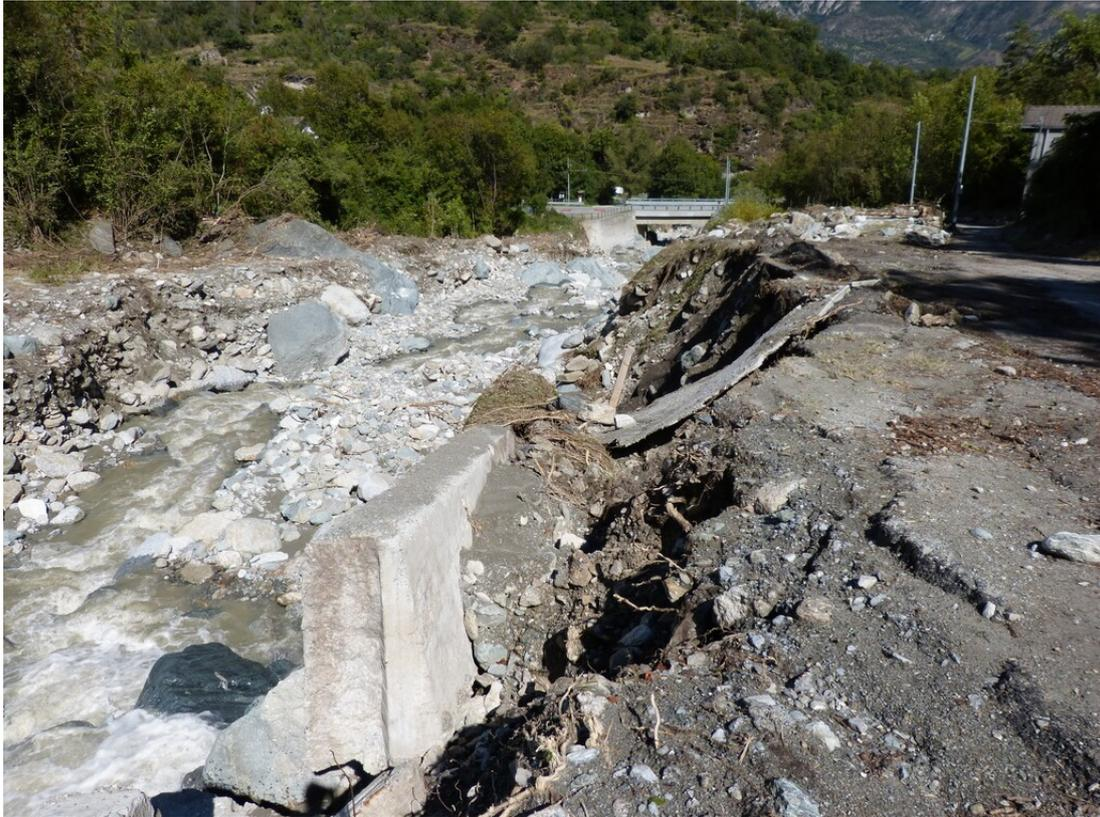
Figura 17. Scalzamento spalla destra ponte crollato in località Giordani. Fonte Regione Piemonte
