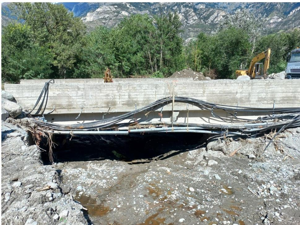
Figura 28. Danni ai sottoservizi sotto al ponte della SP 24 – Bussoleno (TO). Foto scattata il 9 settembre 2024. Fonte Regione Piemonte
