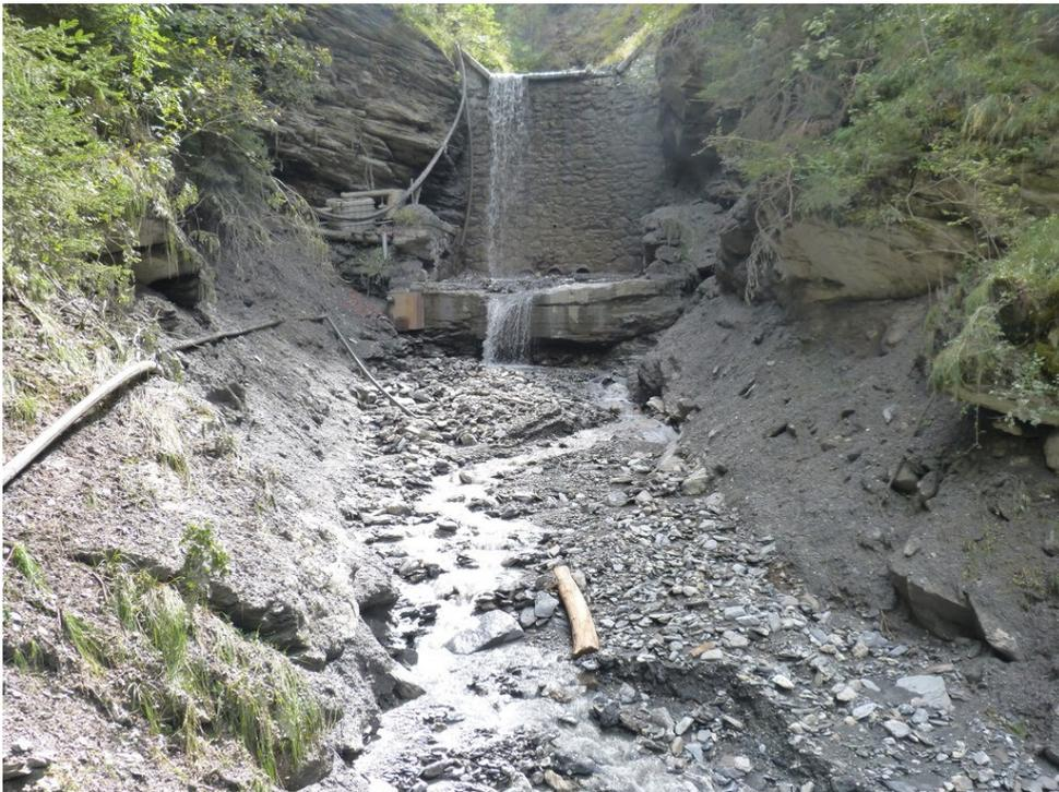
*Figura 33. Rio San Giusto: erosione e deposito a valle di una briglia. Oulx (TO). Fonte Regione Piemonte*
