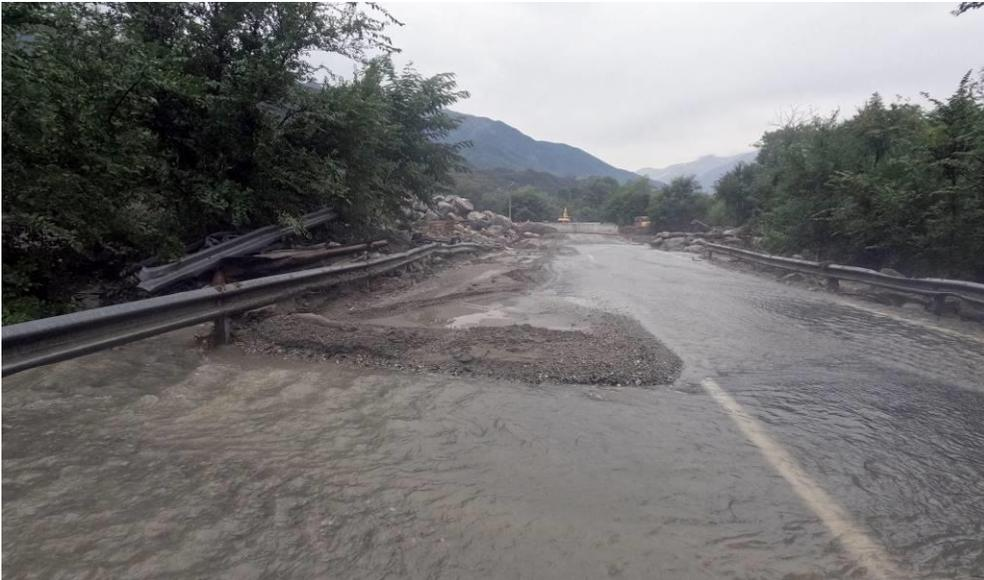
Figura 32. SP24 del Monginevro (ex SS24), poco oltre l'abitato di Bussoleno: in primo piano le acque divaganti del rio Gerardo con piccoli depositi ghiaiosi, in lontananza il ponte del rio totalmente intasato da grossi blocchi, di cui in sinistra (lato di monte del ponte) si riconosce parte dell'accumulo.
