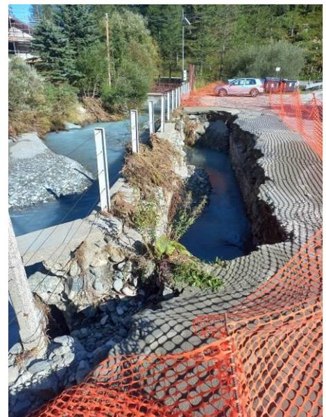
Figura 22. Comune di Balme, Pian della Mussa: sovralluvionamento in località Alpe Venoni (a sinistra) ed erosione del parcheggio (a destra).
