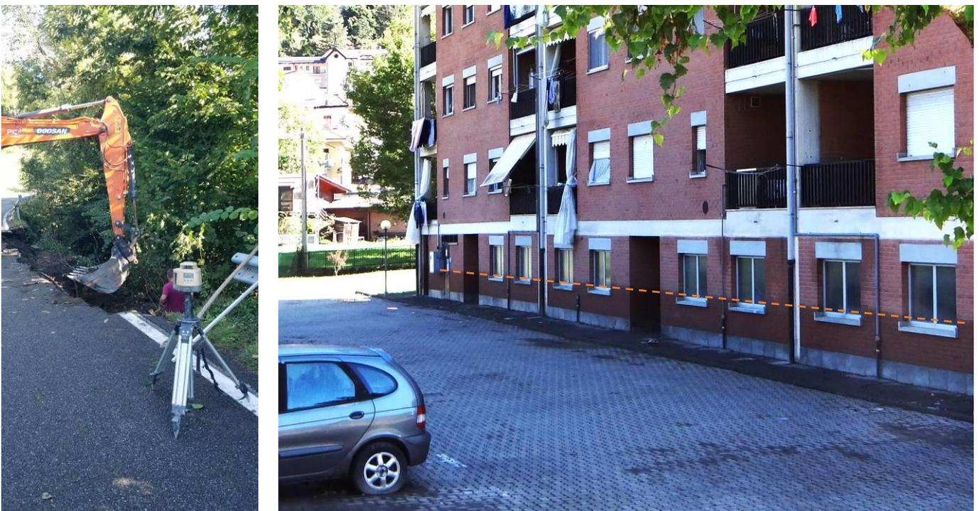
Figura 35. A sinistra, cedimento di un tratto del muro di sottoscarpa in pietrame tra il km 8+150 e il km 9 della strada provinciale 166. A destra l'allagamento del parcheggio prospiciente l'edificio posto in Via Torino nel Comune di Villar Perosa (la linea tratteggiata indica il battente raggiunto dall'acqua)
