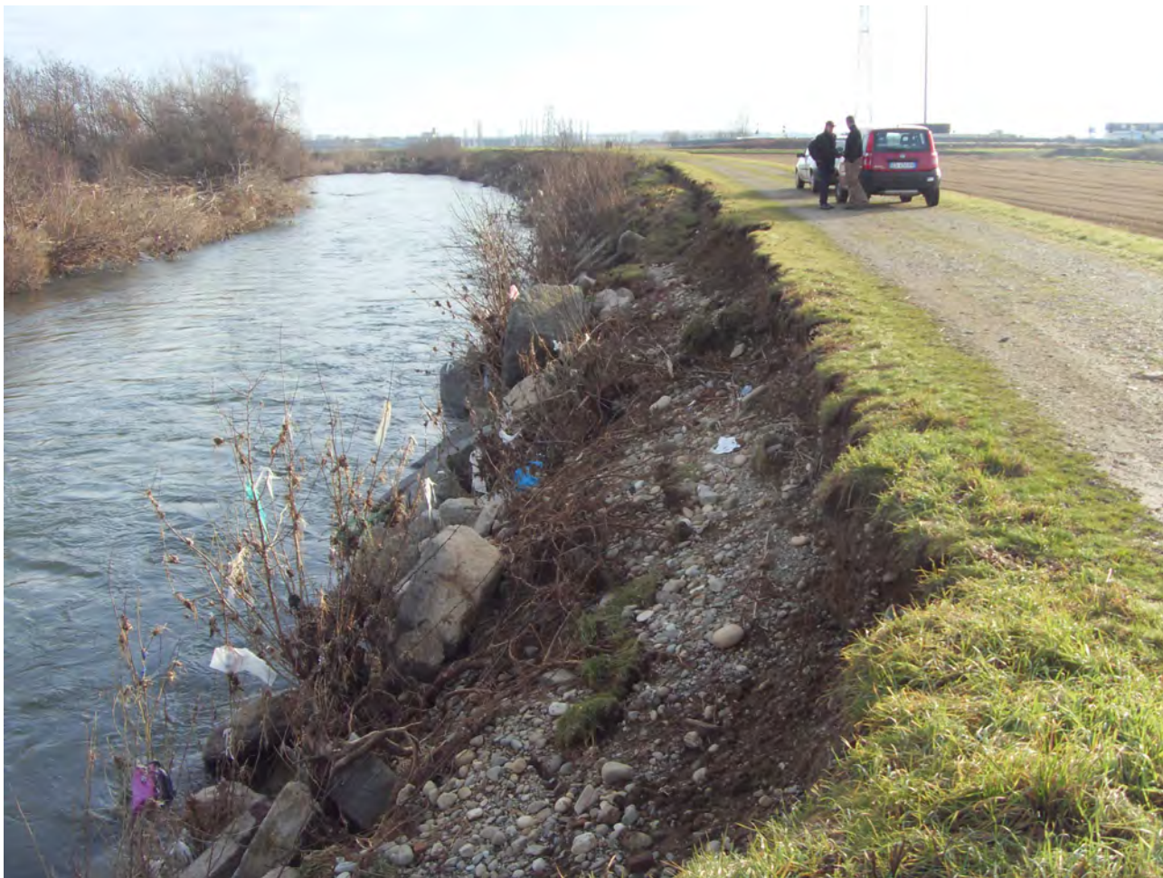
Foto 5 – Vista da monte in direzione di deflusso torr.: erosione e crollo scogliera in massi in sponda dx e presenza di vegetazione (prossimo intervento con squadre Forestali Regionali) ed accumulo inerti su lato sx
