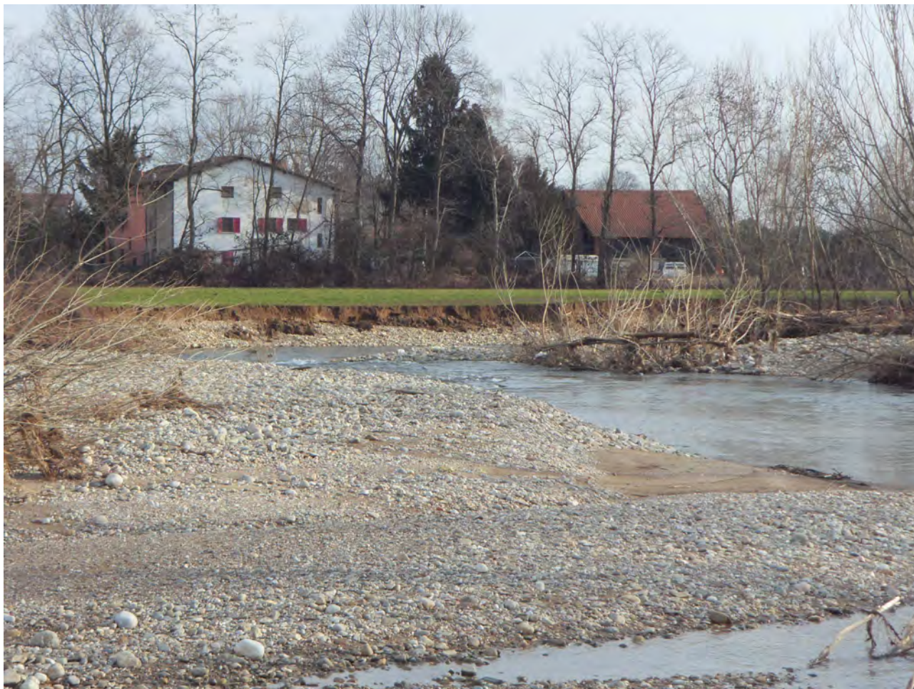
Foto 22 cascina Molinaccio a tergo erosione foto 29.
