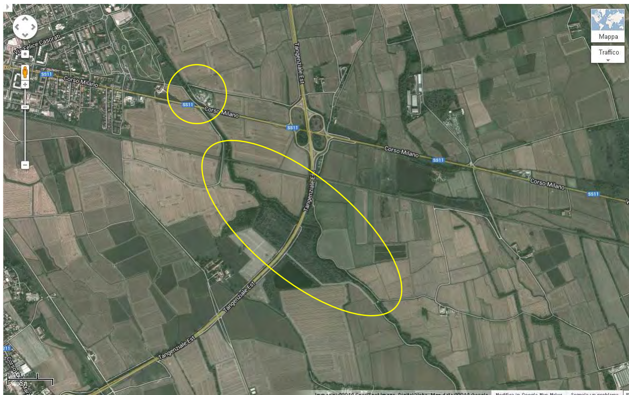
Indicazione zone interessate da ostruzioni, erosioni ed esondazioni
