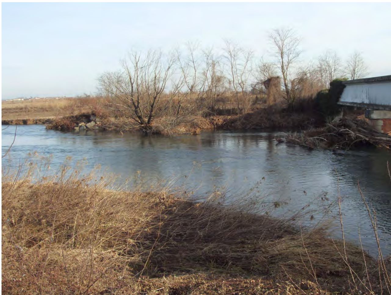
Foto 1 - Vista da monte ponte ferroviario e difesa in aggiramento spalla sx
