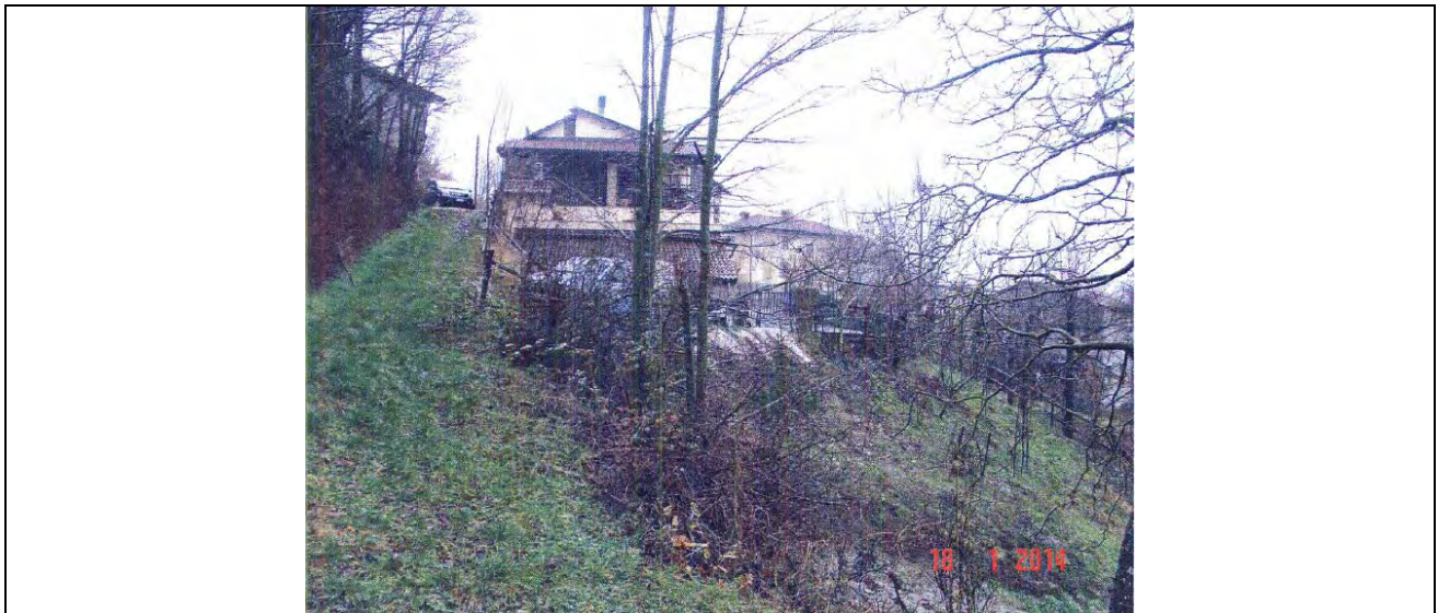
Figura 4 – Cantalupo L. (AL), loc. Costa Merlassino. Edifici posti a monte della postazione I5.
