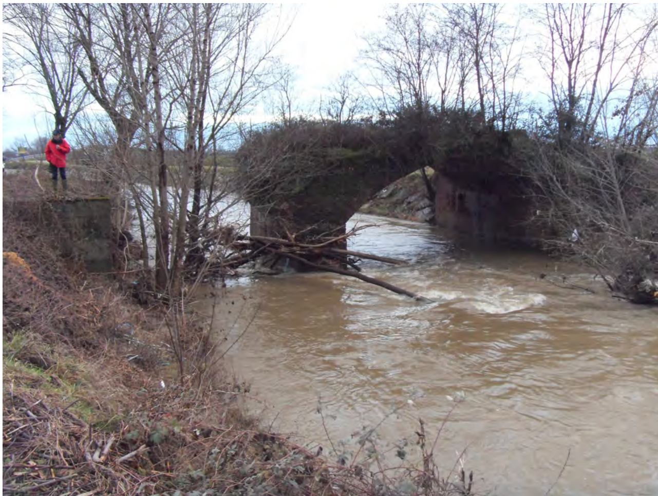
Foto 19 - Vista da monte della S.P. 11 verso valle.
