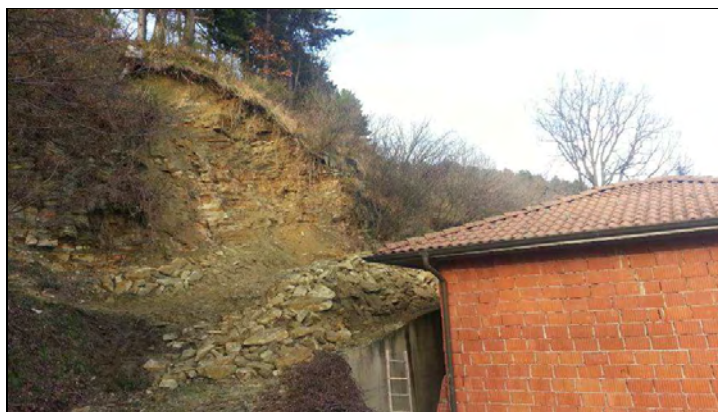
Figura 7 – Comune di Borghetto Borbera, fraz. Sorli. Crollo a monte di un'abitazione
