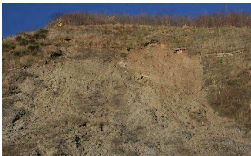
Figura 4 – Parziale riattivazione della frana delle Rocche a Montecastello (AL).
