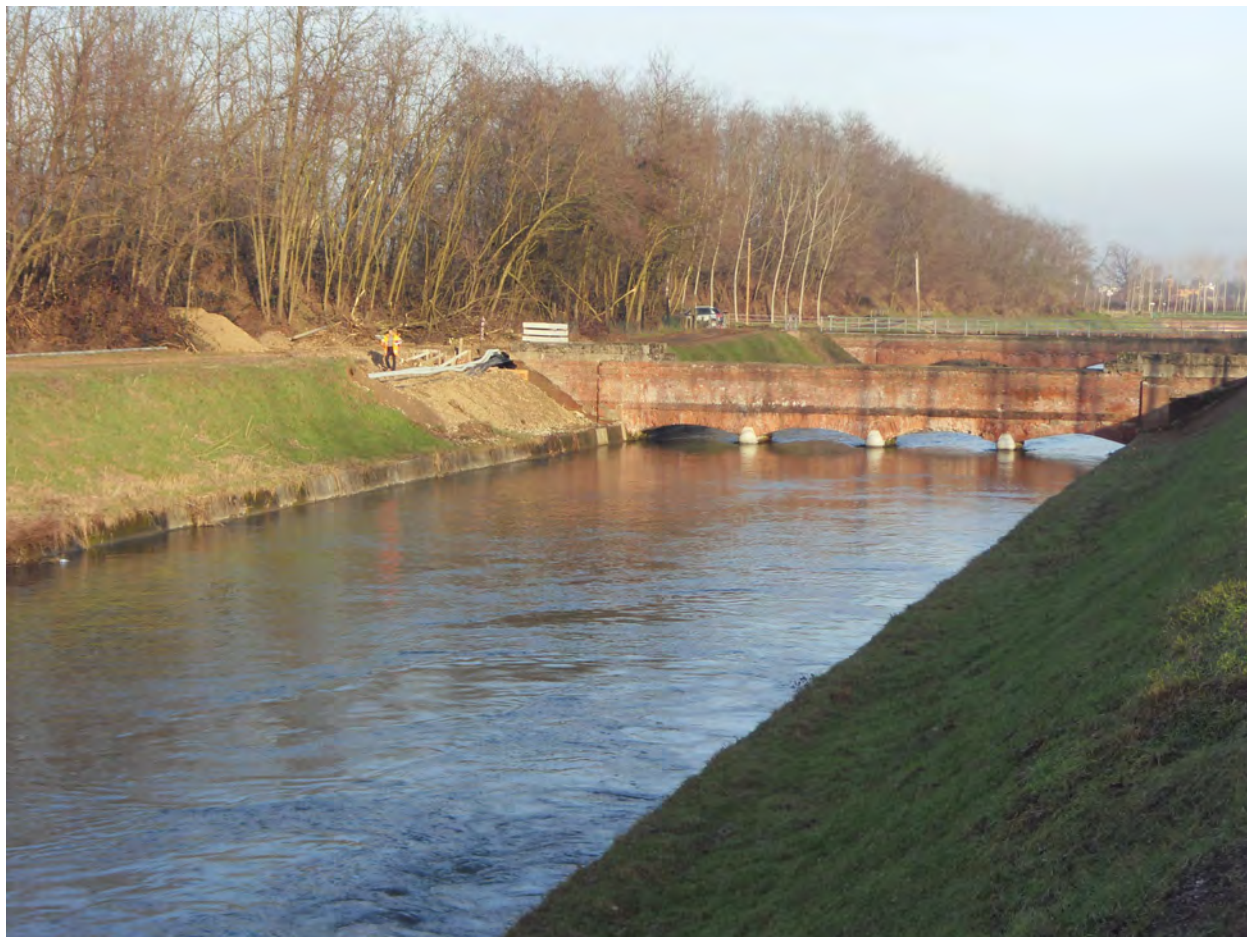
Foto 8 – Vista del Canale Cavour interessato dallo sversamento delle acque di esondazione a valle del sifone di attraversamento Agogna
