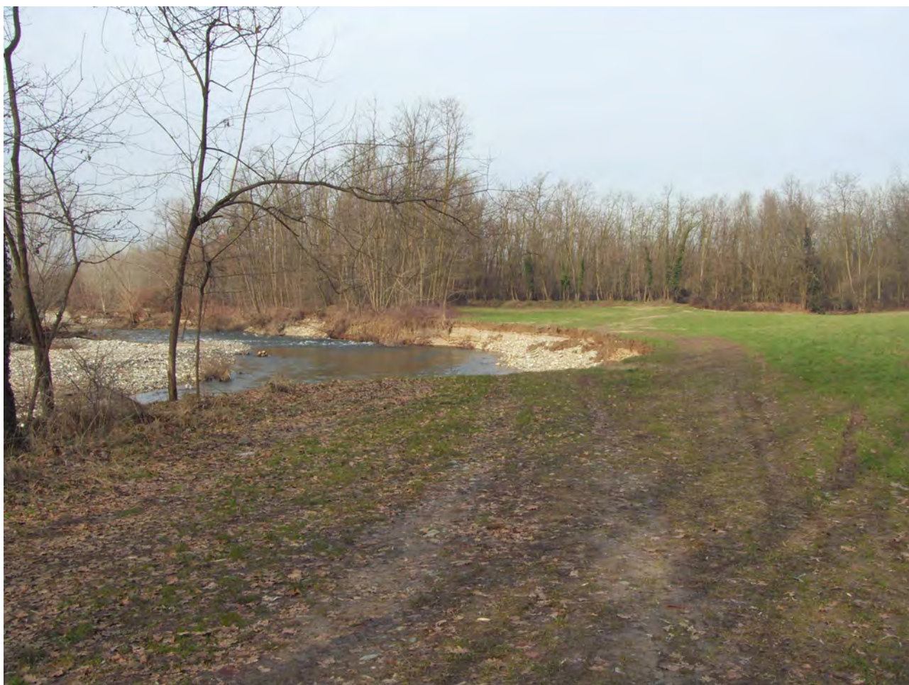
Foto 29 erosione in sponda sinistra con asportazione strada alzaia in prossimità della cascina Molinaccio.
