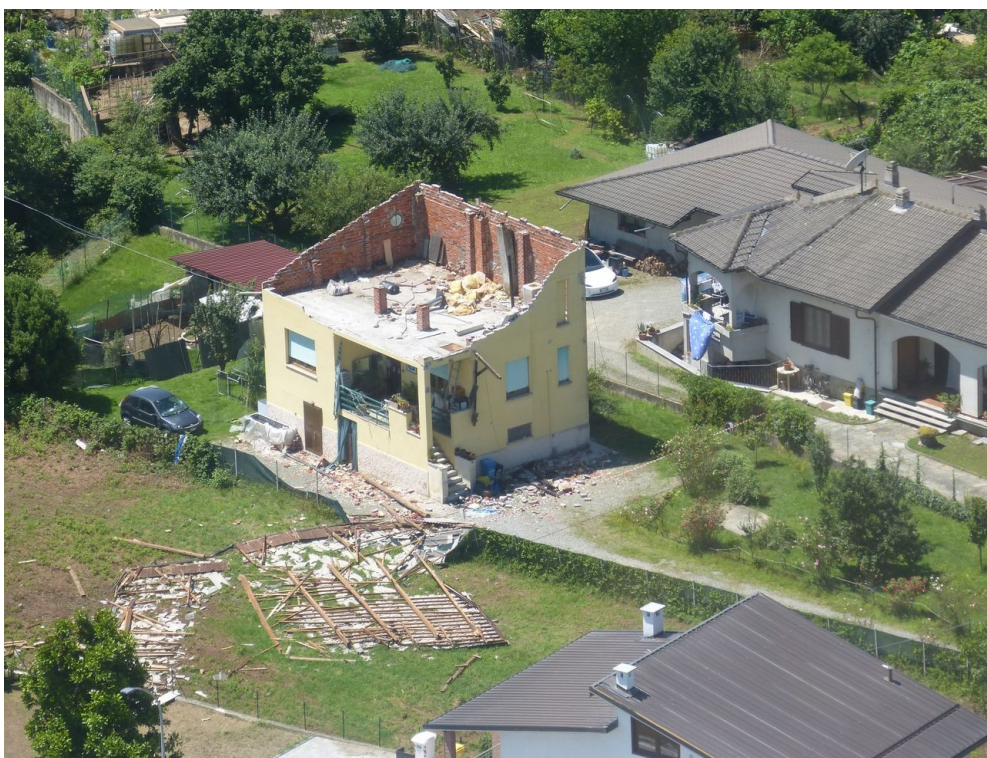
Figura 10. Abitazione danneggiata in via Matteotti, Busano Canavese (TO) - Fonte Regione Piemonte
