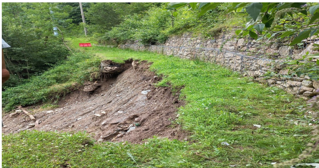
Figura 11. Riattivazione frana con asportazione gabbionate, Ingria (TO) - Fonte Regione Piemonte
