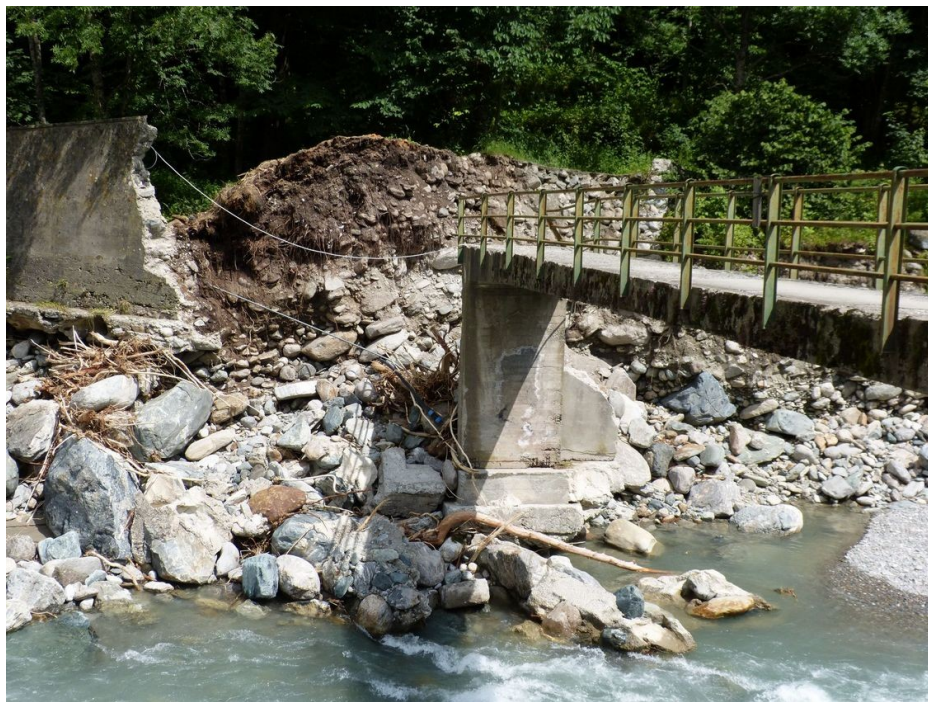
Figura 19. Ponte di Schennine (in alto prima dell'evento, in basso dopo il passaggio della piena del Sesia). Fonte Regione Piemonte
