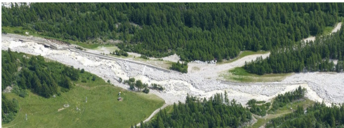
Figura 17. Erosioni spondali torrente Anza. Fonte Regione Piemonte (Ripresa da sorvolo in elicottero del 2 luglio 2024)
