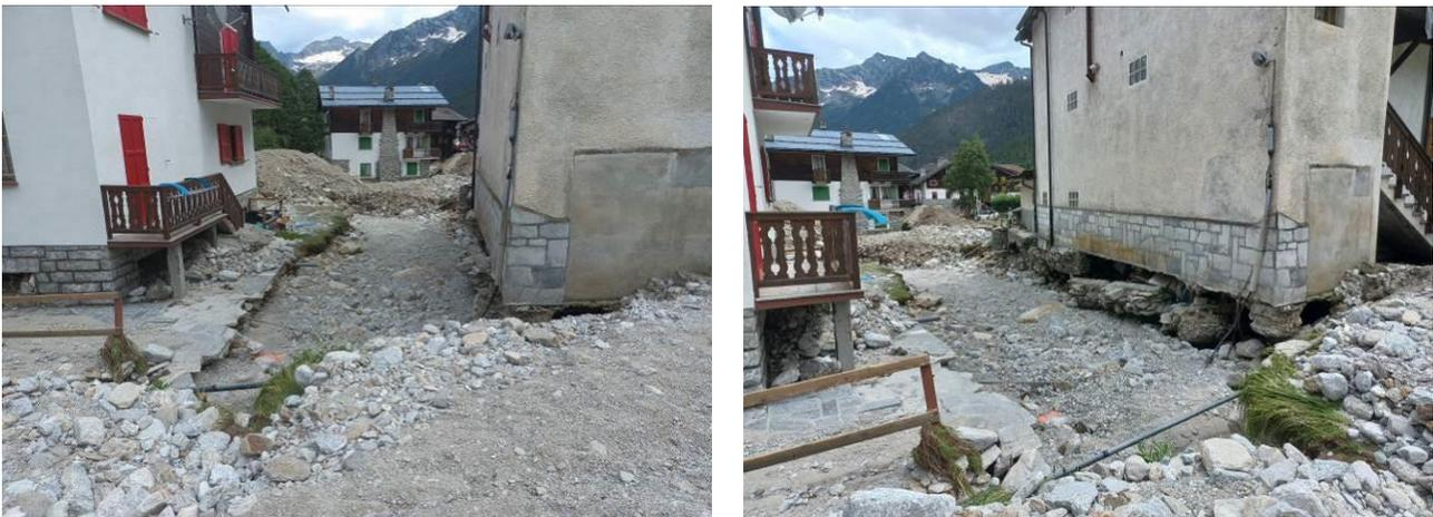
Figura 65 - Deviazione dell'alveo del rio Tambach tra le prime abitazioni a sud del piazzale della funivia Passo Moro; l'erosione ha scalzato parzialmente le fondazioni delle abitazioni (Foto: Regione Piemonte, Settore Tecnico NO-VB).
