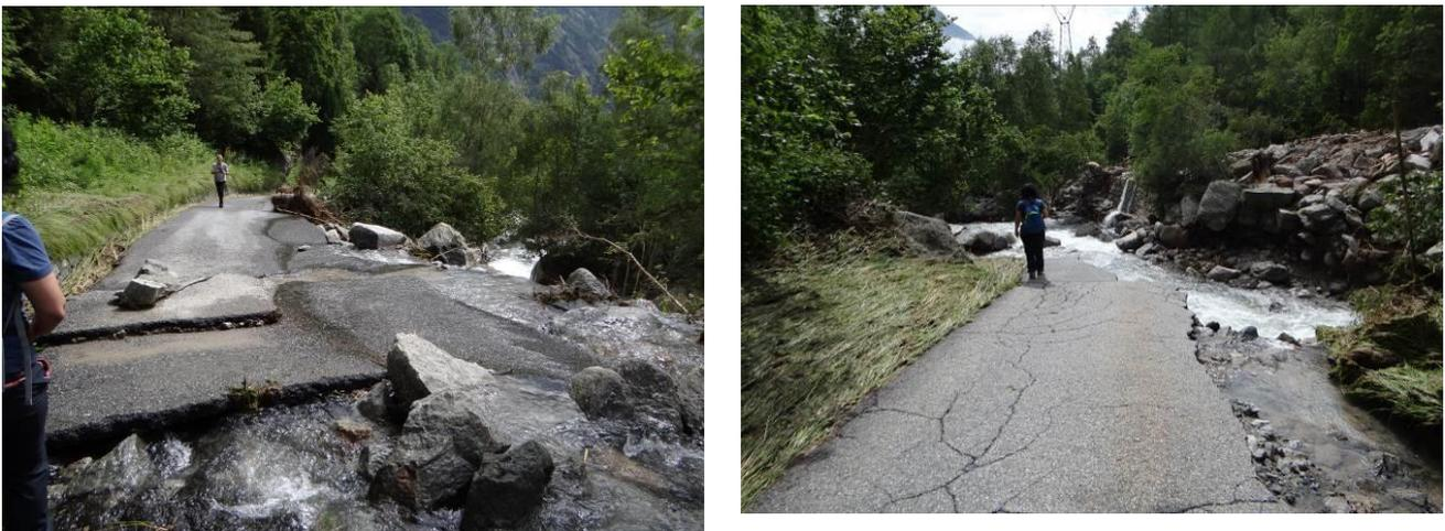
Figura 37 - Tratto di strada completamente asportato dall'erosione di sponda causata dalla deviazione dell'alveo del Piantonetto. A sinistra, vista verso monte; a destra, vista verso valle.
