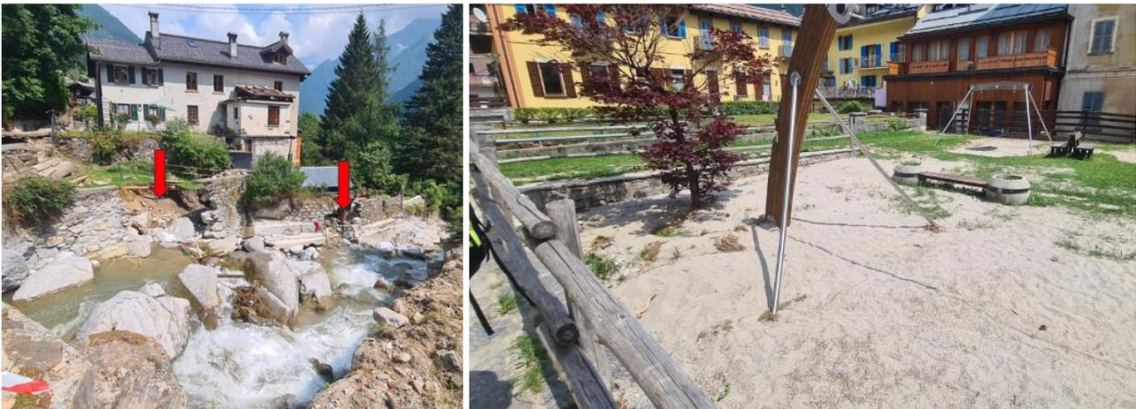
Figura 66 - Le immagini illustrano gli effetti del transito della piena nel tratto terminale del rio Tambach, poco prima della sua confluenza nel torrente Anza. A sinistra, si osserva il crollo dell'argine in due punti, evidenziati dalle frecce rosse, a causa della spinta idraulica dell'acqua. L'immagine a destra mostra il parco giochi comunale in via Jacchetti, dove il deposito presenta una granulometria più fine.
