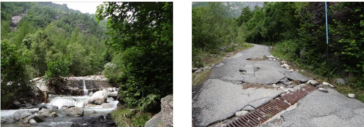
Figura 38 - A sinistra, la colata ha completamente riempito l'alveo del Piantonetto, che prima scorreva oltre il muro in pietra; a destra, poco a valle del tratto asportato la sede stradale si presenta danneggiata in modo lieve.
