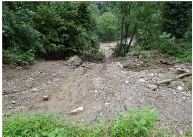
Figura 26 - A sinistra, zona di distacco della frana poco al di sotto della strada comunale per Ingria; a destra zona di scorrimento del materiale detritico, che ha invaso la sottostante sede stradale della comunale e della provinciale.
