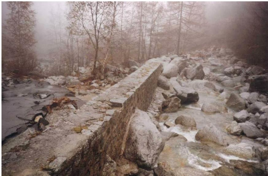
Figura 40 - Dall'Archivio della banca dati di Arpa Piemonte si evince che lo stesso tratto di strada era già stato danneggiato in occasione dell'evento del 13 ottobre 2000. Nella foto di destra si vede l'alveo che scorre nella sede originaria, a destra del muro in pietra.
