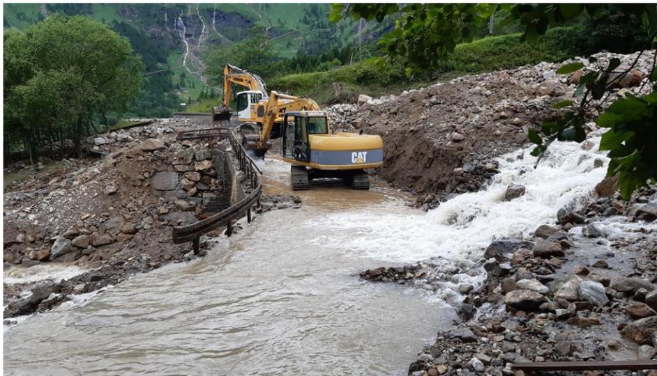
Figura 43 - Il ponte di collegamento tra la località San Domenico e la località Ponte Campo è stato invaso dal materiale detritico trasportato dal rio Grosso. (Fonte: immagine tratta da sito web del Comune di Varzo).
