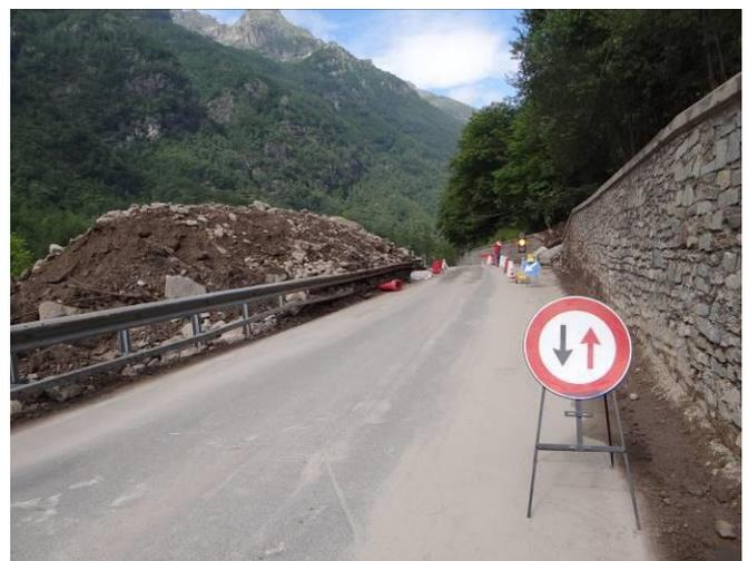
Figura 30 - Il materiale detritico che ha invaso la sede stradale è stato ricollocato oltre il guard-rail per ripristinare la circolazione. A sinistra, vista da monte verso valle; a destra vista da valle verso monte.
