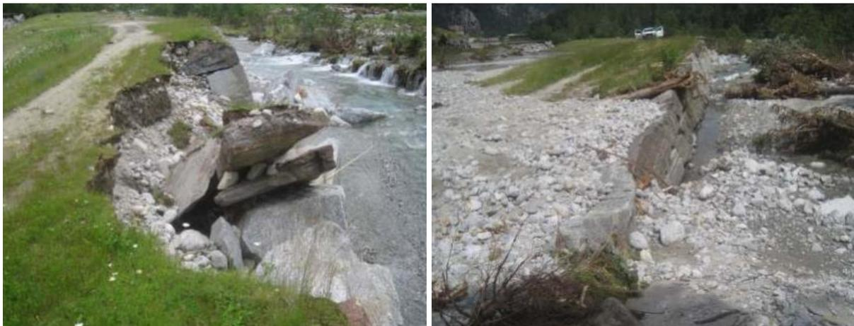
Figura 85 - Effetti dell'alluvionamento prodotto dal torrente Quarazza a monte dell'immissione nel lago delle Fate. In entrambe le immagini sono visibili i danni provocati alle scogliere poste a difesa spondale. (foto Regione Piemonte)
