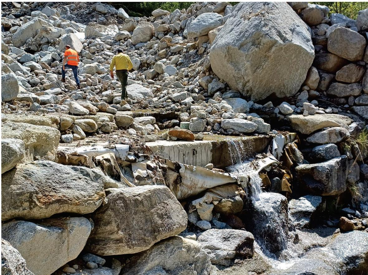
**Figura 1:** S.P. 460 km 60+550 (paravalanghe): strato di impermeabilizzazione danneggiato
