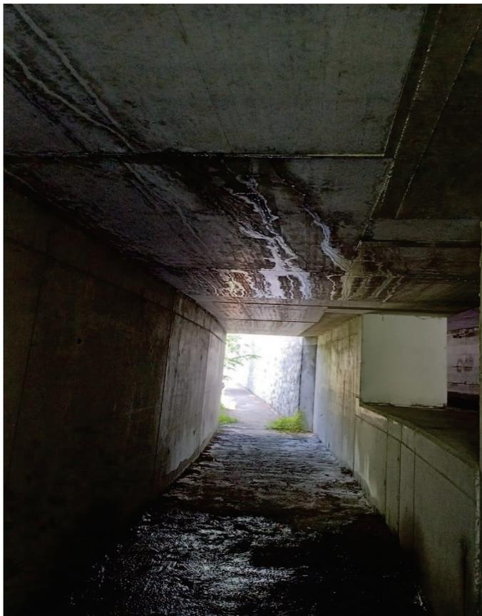
**Figura 2:** S.P. 460 km 60+550 (paravalanghe): infiltrazioni a seguito danneggiamento strato di impermeabilizzazione
