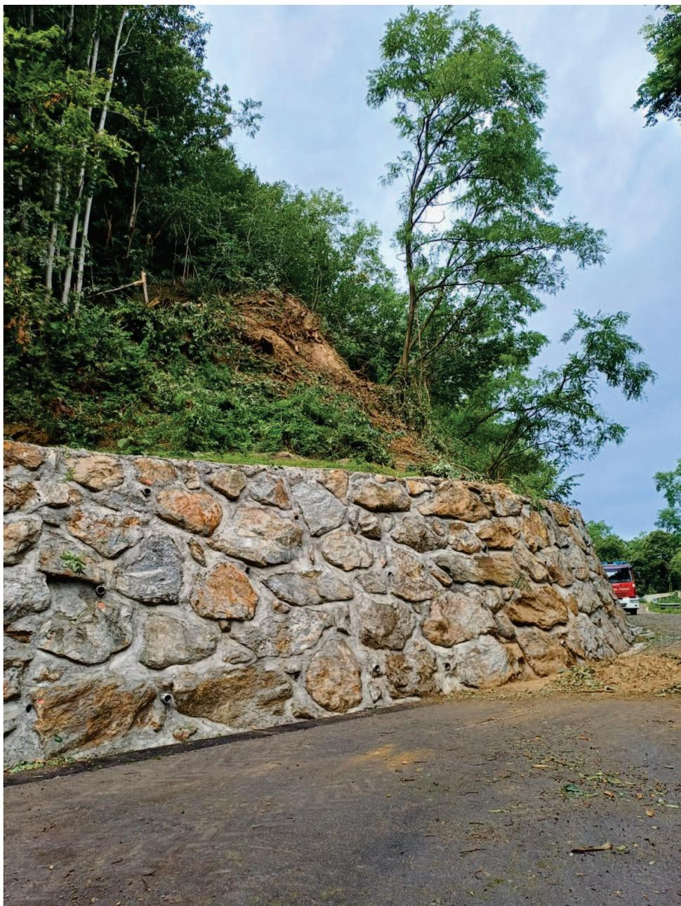
**Figura 4:** S.P. 243 km 0+700: materiale instabile a seguito evento del 12.07
