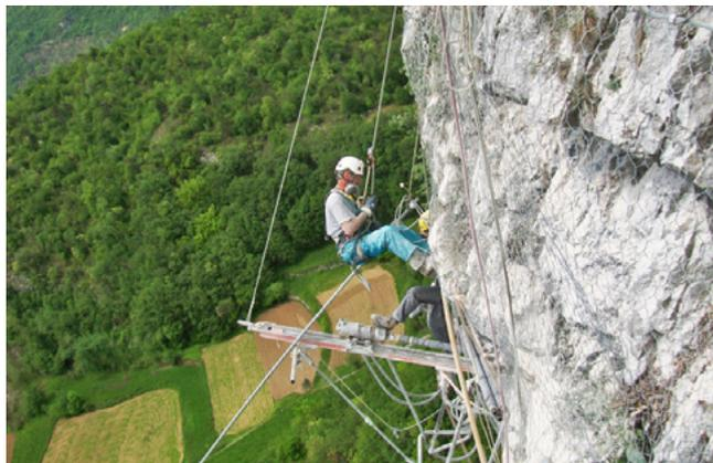
A fronte delle operazioni di movimento terra sui versanti, spesso risulta necessario procedere al consolidamento di blocchi, lastre rocciose e scarpate mediante chiodature, funi e reti metalliche.
