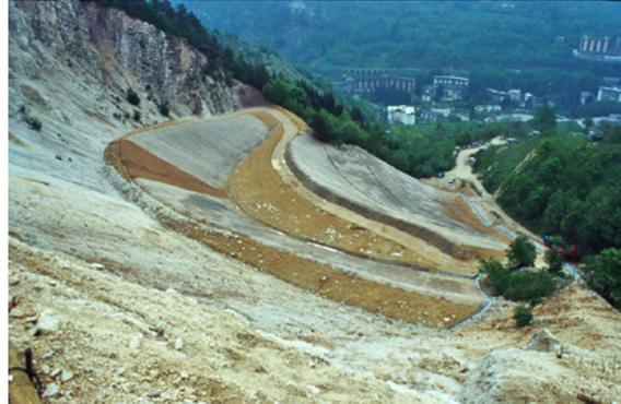
Esempio di sistemazione di versante attraverso l'apporto di materiale dall'esterno del cantiere
