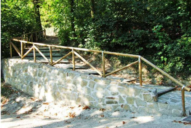
La costruzione deve rispettare diversi accorgimenti costruttivi, i più importanti dei quali consistono nella **disposizione omogenea** di pietrame di diverse dimensioni, in modo da costituire corsi orizzontali regolari e soprattutto un costante sfalsamento dei giunti verticali: un'operazione che risulterebbe molto semplice nella costruzione di un muro in mattoni di laterizio, di forma regolare, ma che richiede in questo caso notevole perizia. Agli angoli delle strutture murarie
