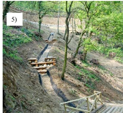
**Canalizzazioni in pietrame malta (1), in legname e pietrame (2-3-4), in geocomposito (5: geostuo in polipropilene a struttura tridimensionale su geomembrana)**
