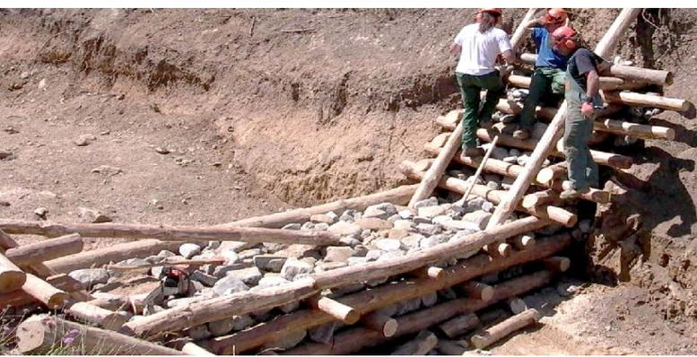
*Sopra: palificate vive di sostegno, impiegate per il consolidamento di sponde fluviali*
