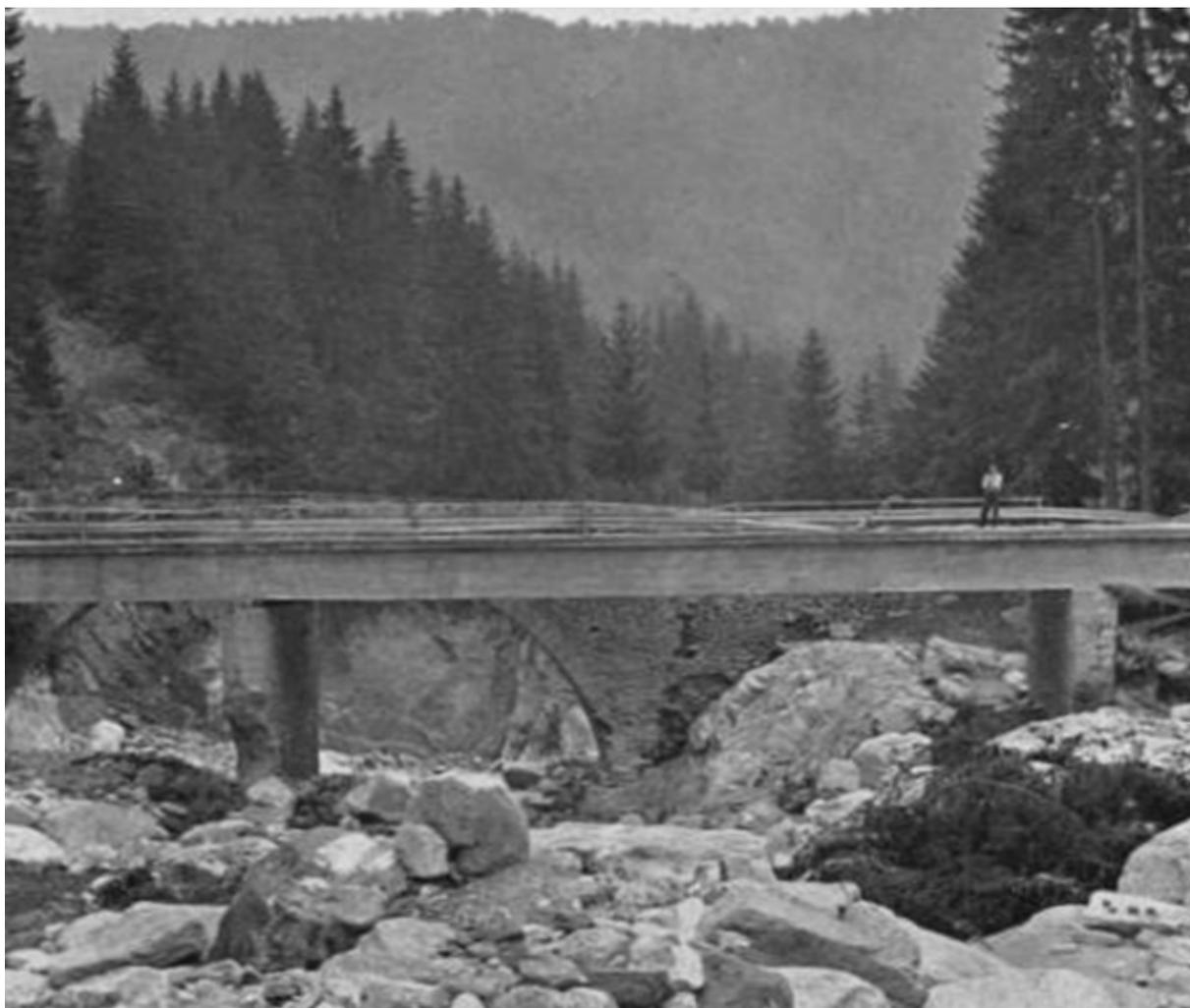
Foto 20.1 : Vecchio ponte ad arco sul rio Vasca visibile dietro al nuovo ponte in cemento armato gravemente danneggiato dalla piena (fonte: ANSELMO, 1980).
