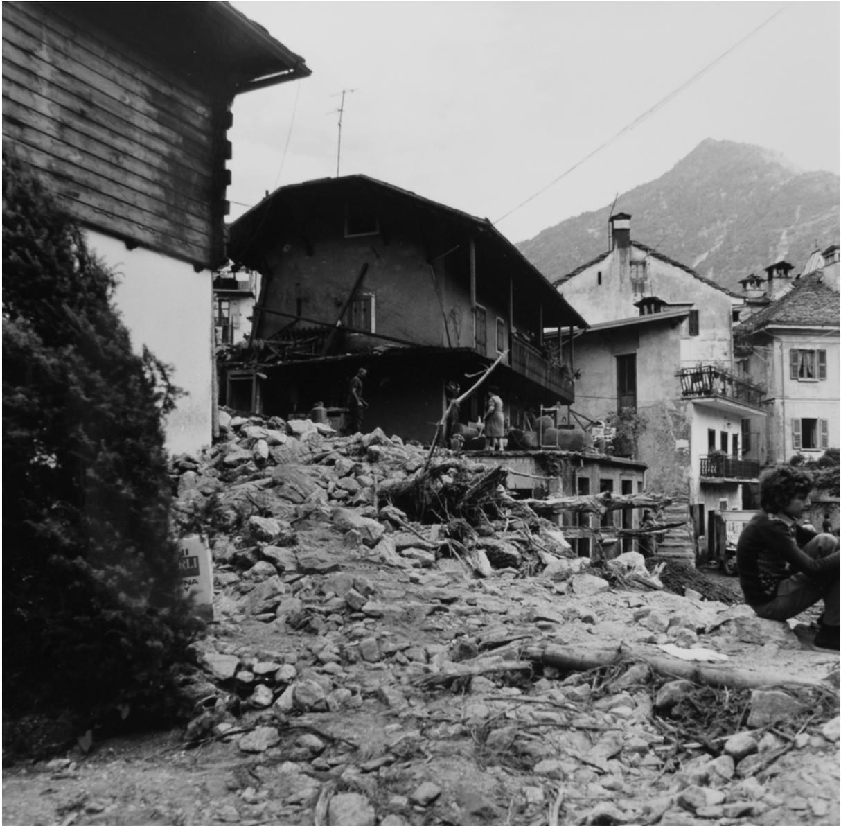
Foto III.2 : Località Pontegrande (comune di Calasca - Castiglione). Gravi danni all'abitato e fabbricati da parte del trasporto solido dei torrenti (fonte: fotografia di STUDIO PESSINA, 1978).
