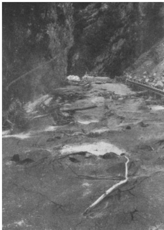
Foto 17.3 : La pressione delle acque circolanti nel sottosuolo danneggiò e spesso divelse il manto di asfalto delle strade. Qui un tratto della Statale della valle Vigizzo poco dopo Masera dove la fiumana che invase la sede stradale ne cancellò parecchi tratti e li rese impraticabili (fonte: BERTAMINI, 1978).
