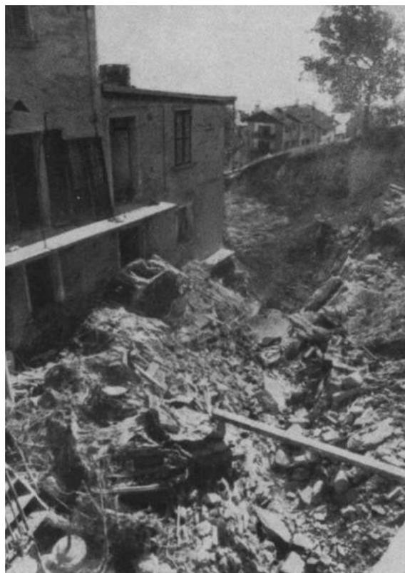
Foto 17.2 : A Toceno la piena del rio Rido fece esplodere la volta in muratura che lo ricopriva per un tratto del suo percorso interno al paese. Il percorso del rio è segnato da distruzioni sparse dell'abitato, trascinamento e deposito di carcasse di automobili e suppellettili (fonte: BERTAMINI, 1978).
