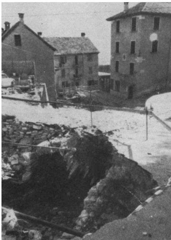
Foto 17.1 : A Toceno il rio Rido che attraversa il paese è stato in altri tempi coperto da una volta in muratura per rendere più facile l'accesso alle abitazioni sorte ai bordi. Il rio, in forte pendenza, intasandosi per il materiale sceso dall'alto, è esploso come una bomba per un lungo tratto (fonte: BERTAMINI, 1978).
