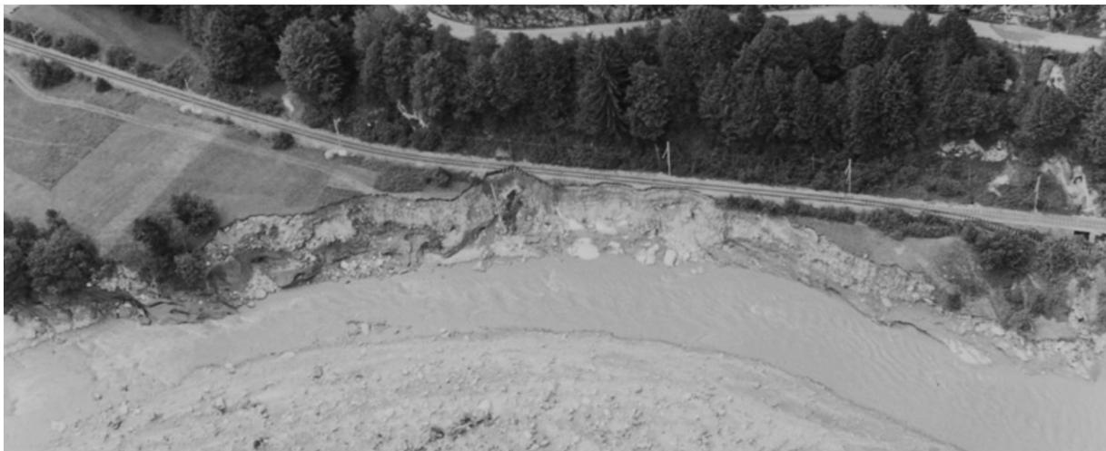
Fig. 2.1 : Tratto di ferrovia danneggiata da un'azione di forte erosione in sinistra del Melezio orientale in località Olgia (comune di Re) (fonte: fotografia di STUDIO PESSINA, 1978).
