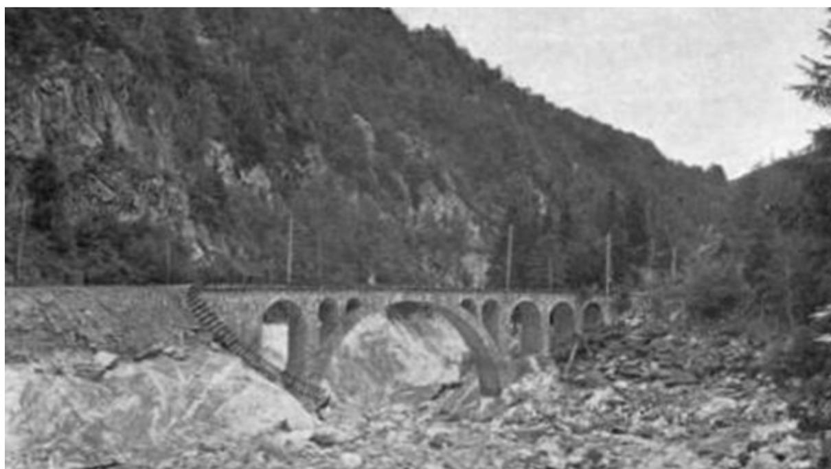
Foto 5.1 : Ponte della ferrovia vigezzina presso Dissimo. La spalla destra è stata raggiunta e danneggiata dalla piena (fonte: ANSELMO, 1980).
