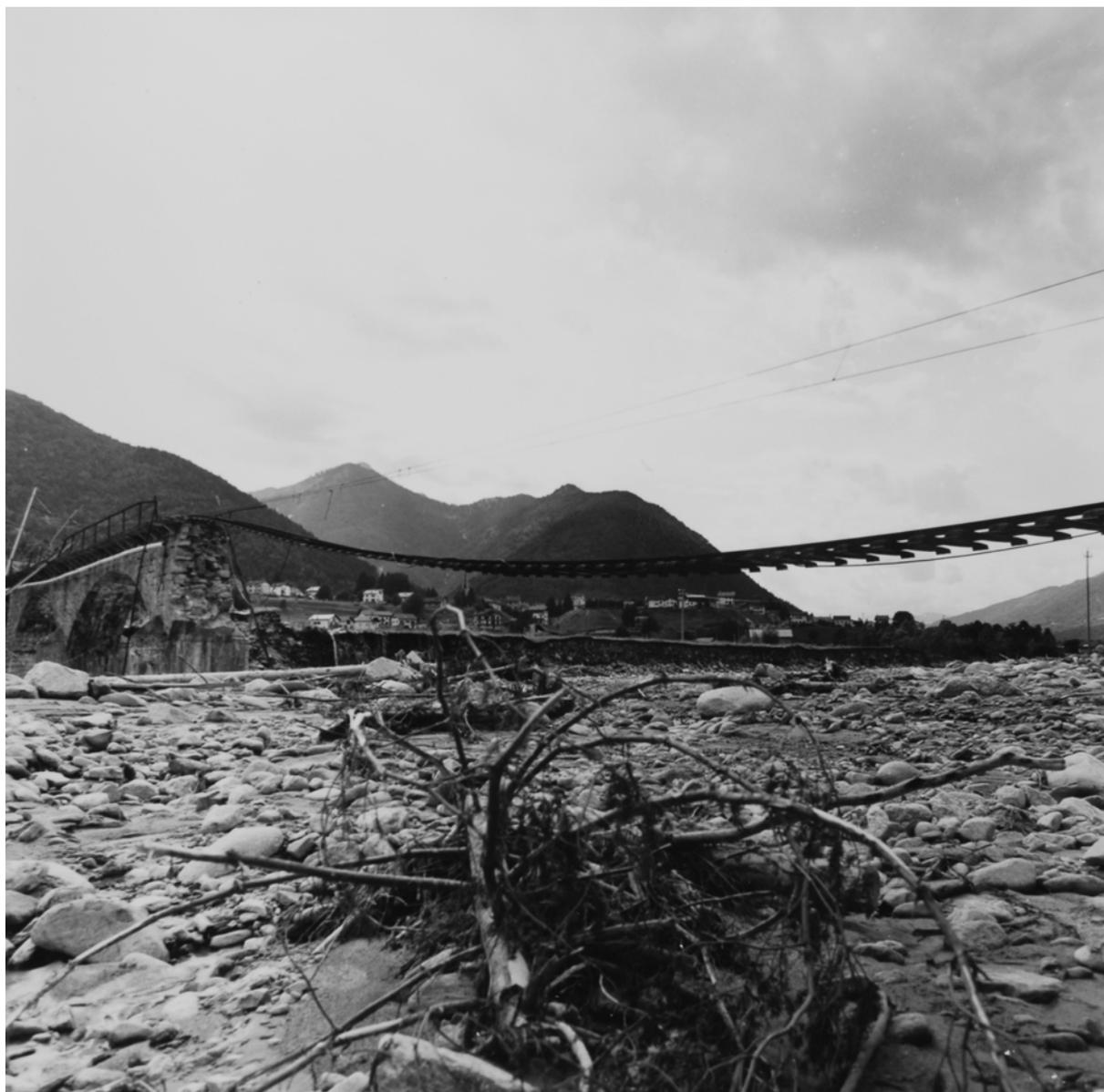
Foto 7.1 : Località Cutredo, nel comune di Malesco. Il ponte ferroviario che connetteva il paese ai suoi vicini venne travolto e distrutto dalla piena del Melezzo orientale. Passato il nubifragio e defluite le acque rimangono le macerie del ponte e la devastazione del letto del torrente (fonte: fotografia di STUDIO PESSINA, 1978).
