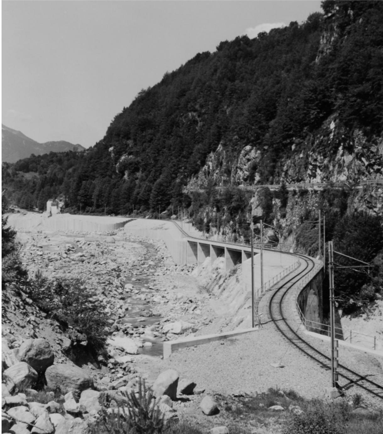
Foto 6.2 : Fenomeno di trasporto solido nei torrenti con conseguenti danni alla ferrovia vigezzina e necessari interventi di sistemazioni idrauliche (fonte: fotografia di STUDIO PESSINA, 1978).
