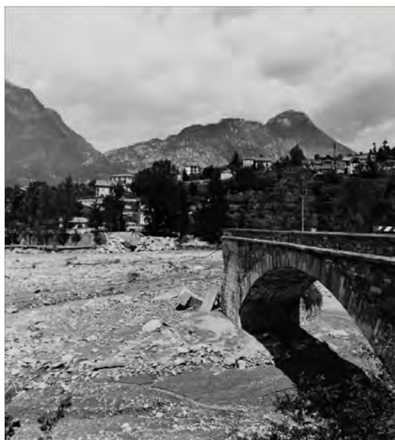
Foto 4.5 : Ponte stradale sul torrente Isorno asportato dalla piena in località Pontetto (comune di Montcrestese) (fonte: fotografia di STUDIO PESSINA, 1978).
